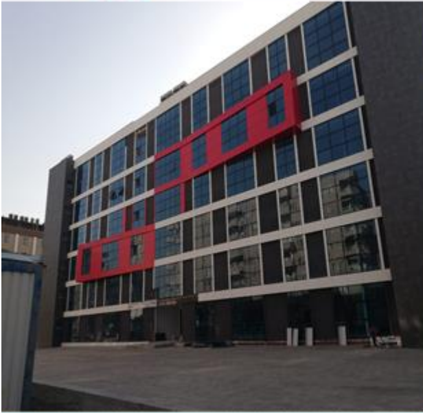
Batman Belediyesi Ek Hizmet Binası ve Dış Cephe Giydirme Yapım İş'i
