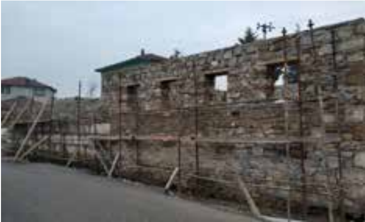
Restorasyon ve Çevre Düzenleme İşi( Konuralp Hamam)
