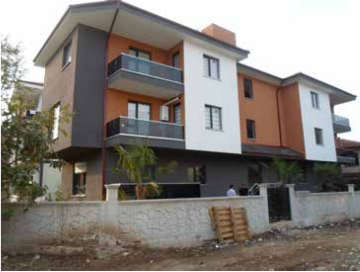
%95 Hakediş seviye kontrolü yapılmıştır.
