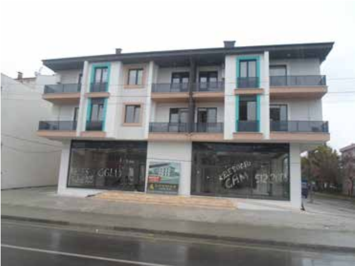
%100 Yapı kullanım izin belgesi seviye kontrolü yapılmıştır.
