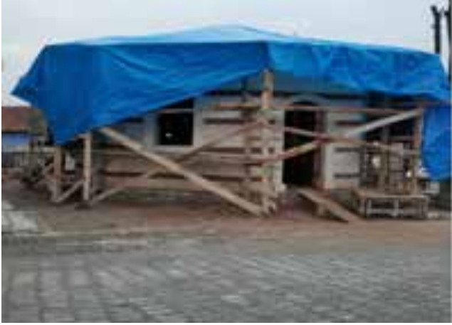
Restorasyon ve Çevre Düzenleme İşi(Türbe)
