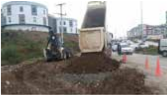
Orhangazi Mahallesi Konuralp 330 Cadde Yol Açım Çalışması
