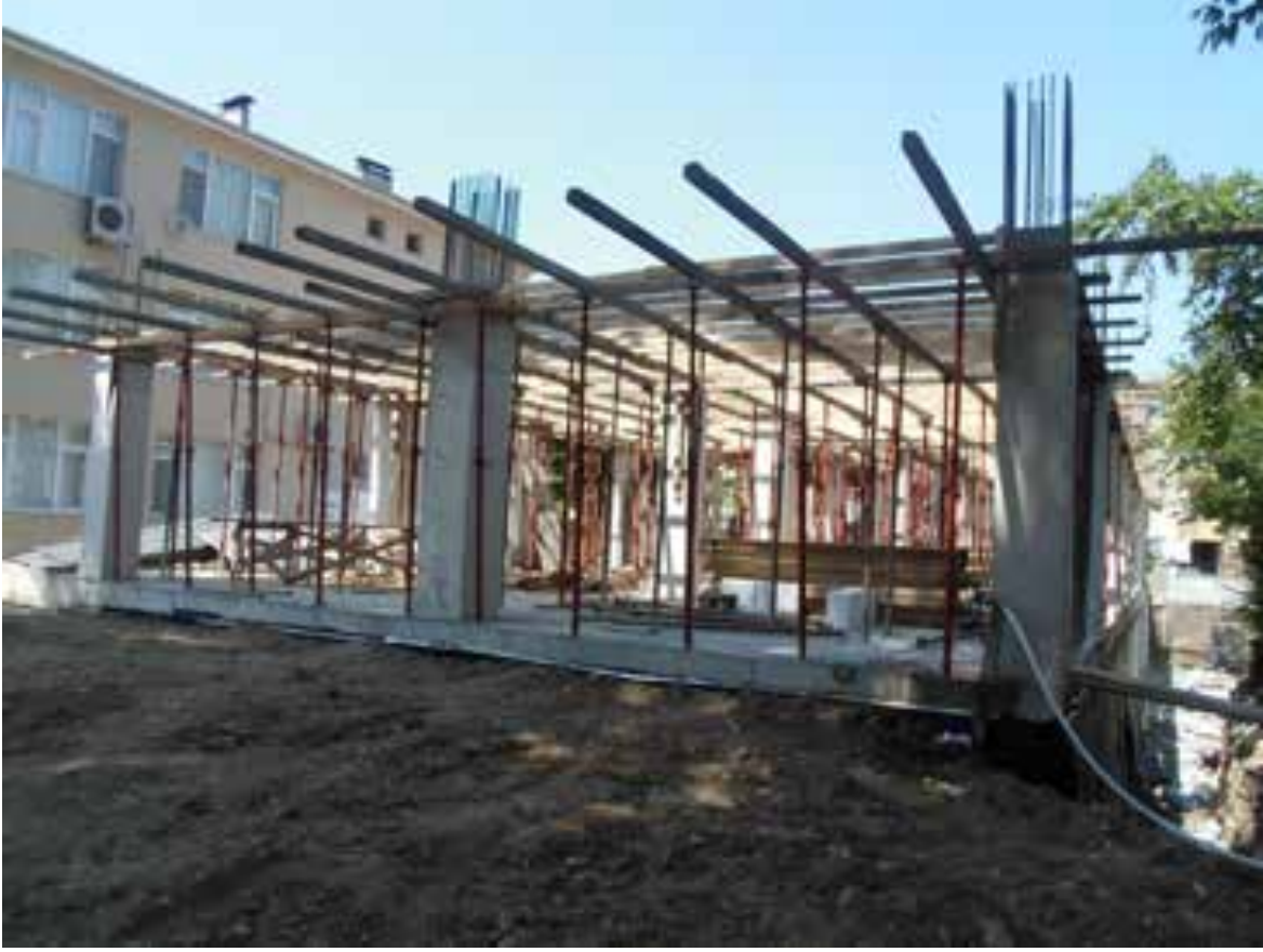
%20 Hakediş seviyes kontrolü yapılmıştır.
