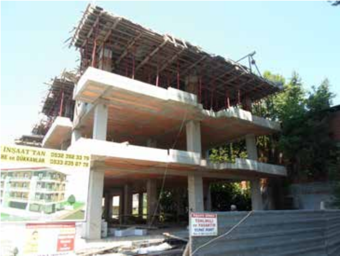
% 40 Yapı kullanım izin belgesi seviye kontrolü yapılmıştır.
