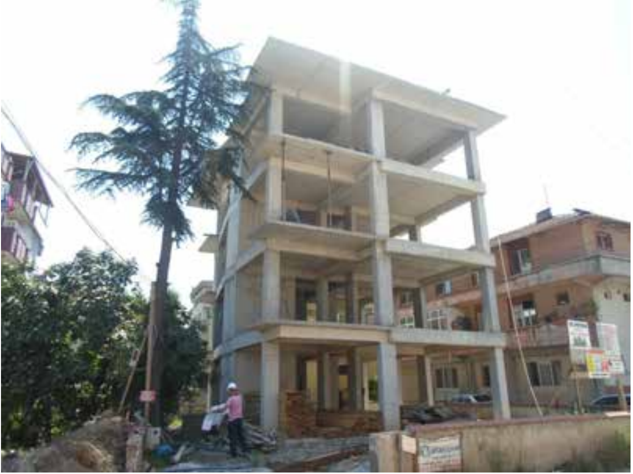
% 60 Hakediş seviye kontrolü yapılmıştır.
