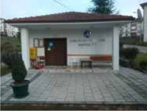
Muhtelif Yerlerde Muhtarlık Hizmet Binası Yapım İşi
