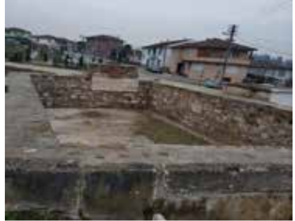
Restorasyon ve Çevre Düzenlemesi İşi(Kilise suyu çeşme)
