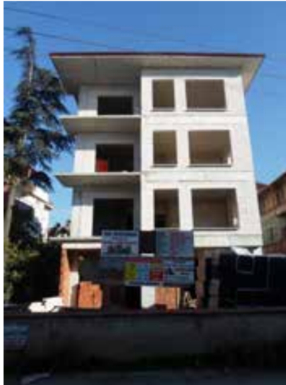
%80 Hakediş seviye kontrolü yapılmıştır.
