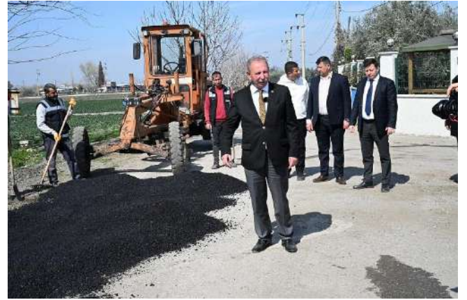
“Yol Yapım Çalışmaları”
