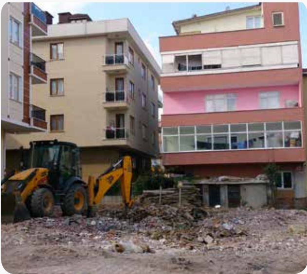
Yıkılan riskli yapı alanı
