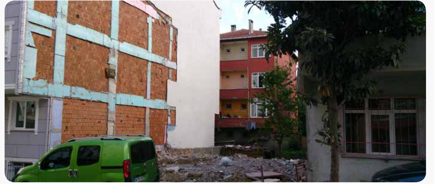
Yıkılan riskli yapı alanı
