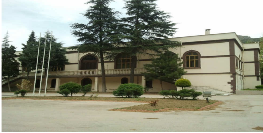
Yapının Onarım öncesi fotoğrafı
