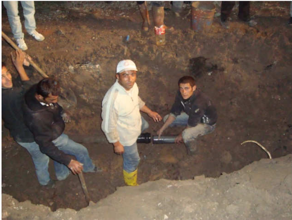
(İçme suyu tamirat çalışması)
