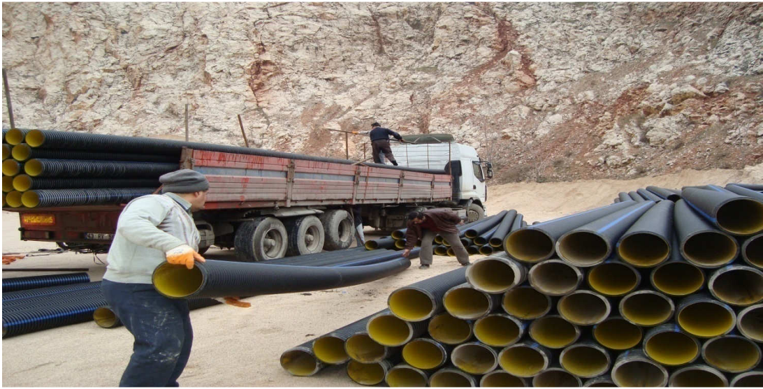
(Kanalizasyon ve yağmur hat yapımında kullanılan borular)
