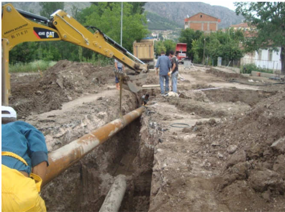
(Akbilek Mah. İçme suyu hat çalışması )
