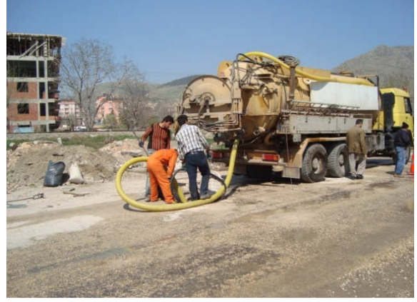
(Şeyhçui Kanalizasyon hat temizliği)
