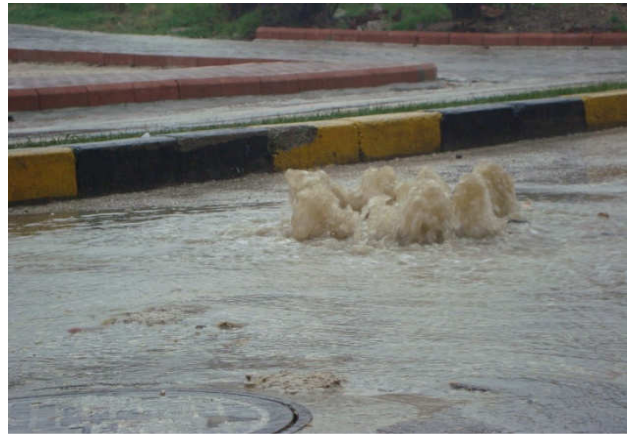
(Kanalizasyon baca tamirâtı)
