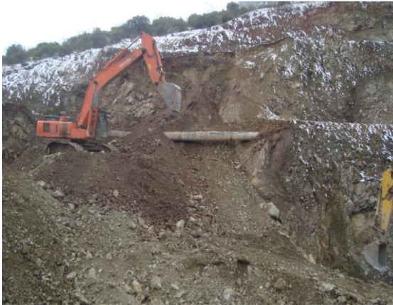
(Yağmur suyu ızgara tamirâtı )
