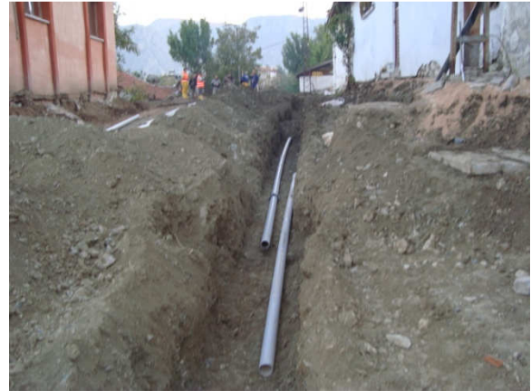
(İçme suyu hat çalışması)
