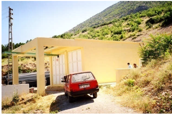
(İçme suyu klor deposu bakım ve onarımı)
