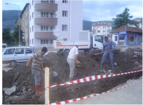
(Şeyhçui Mah. Kanalizasyon çalışması)
