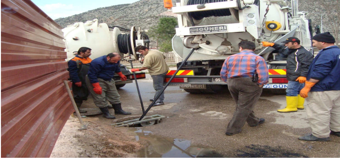
(Kanalizasyon kanal açma vidanjörü)
