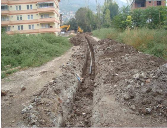
(Hacılar Meydanı Mah. İçme suyu hat çalışması )
