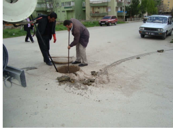
(Hacılar Meydanı Kanalizasyon hat temizliği)
