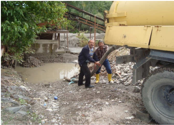
(Kanalizasyon vidanjörle su çekilmesi)
