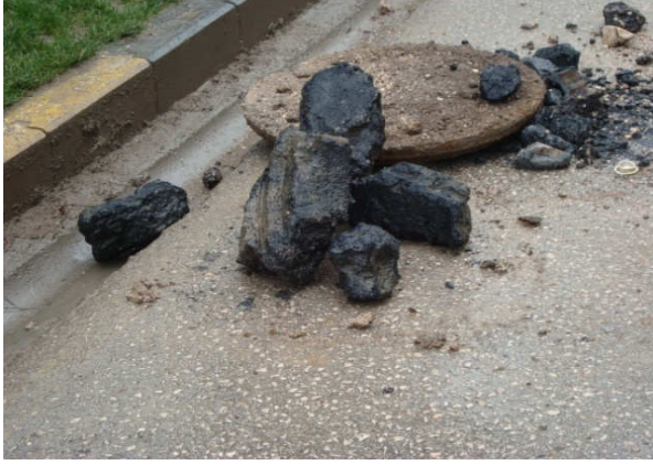
(Kanalizasyon Baca temizliği)
