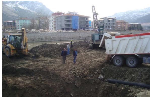
(Akbilek Mah. Kanalizasyon hat çalışması)
