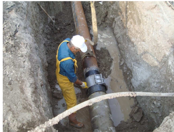
( Akbilek Mah. İçme suyu hat çalışması)
