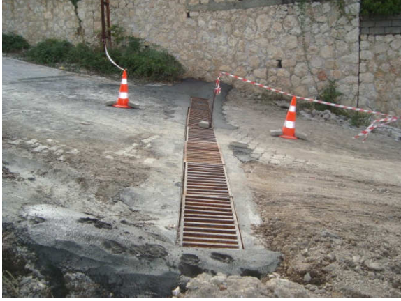
( Yağmur suyu ana ızgara tamirâtı)
