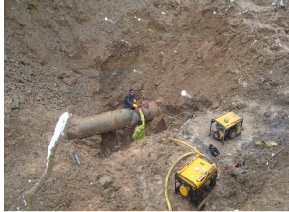
(İçme Suyu tamirâtı)
