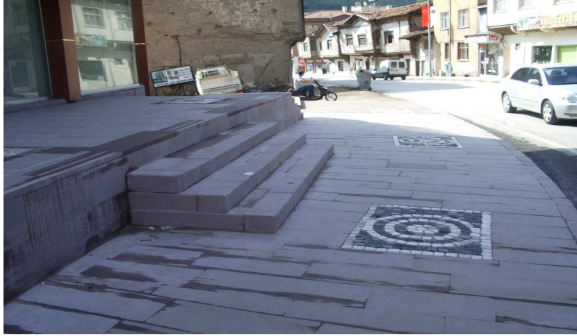
Kaldırım- Tretuvar çalışmaları
