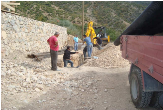
(Şeyhcui Mah. Kanalizasyon hat çalışması )
