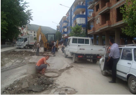
(Hacılar Meydanı Mah. Kanalizasyon çalışması)
