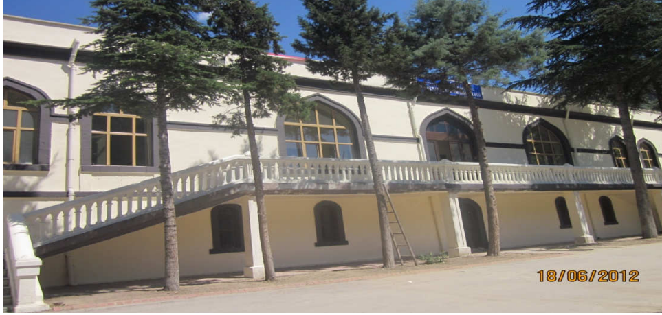
Yapının Onarım sonrası Fotoğrafi
