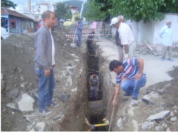
(Şeyhçui Mah. Kanalizasyon çalışması )
