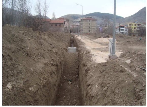
(Hacıarmeydanı Mah.Yağmur suyu hat çalışması)
