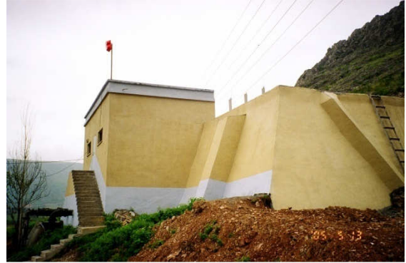
(İçme suyu Depo onarımı)
