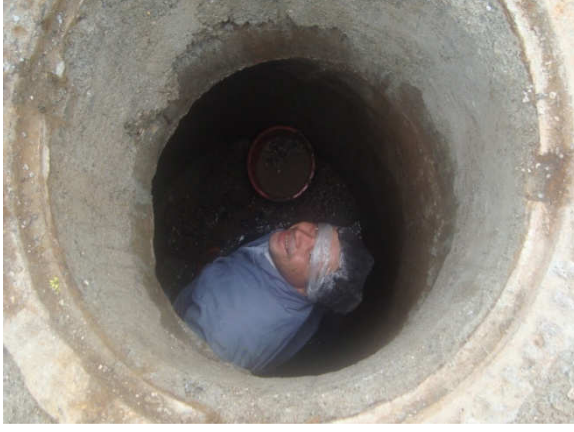
(Kanalizasyon baca temizliği)
