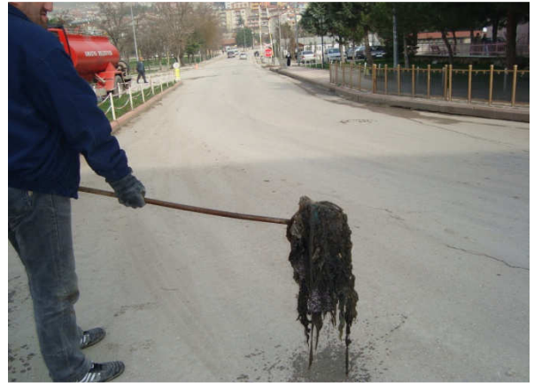
(Kanalizasyon baca temizliği)
