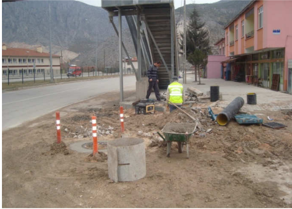
(Kanalizasyon baca tamirâtı)
