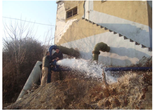
(Şeyhcu Mah. İçme suyu hat çalışması)
