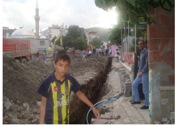
(Şeyhçui Mah. Kanalizasyon çalışması)
