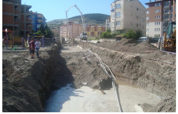
(Şeyhçui Mah. Kanalizasyon hat çalışması)
