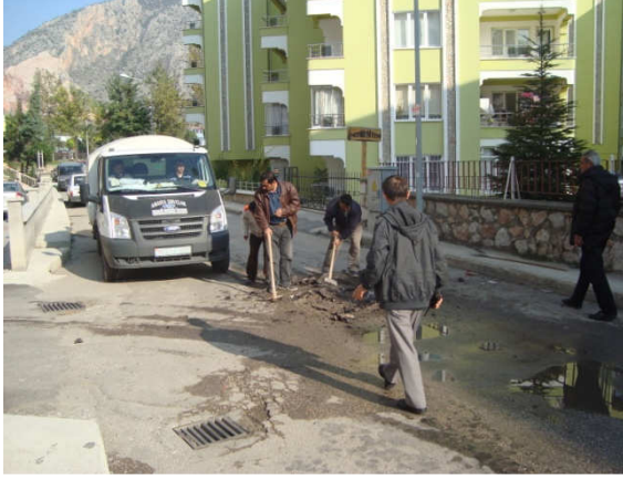
(Ellibeşevler Mah. Yağmur suyu hat çalışması)
