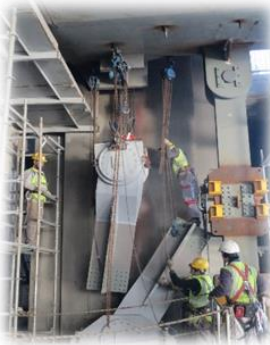
FSM Rocker Link montajı
