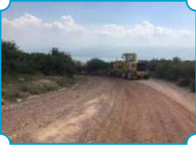
Köyler Yol Açma ve Tesviye Çalışmaları
