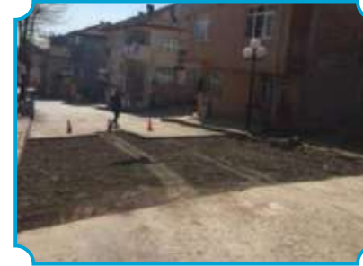
Çenesuyu Caddesi (Eski Hali)
