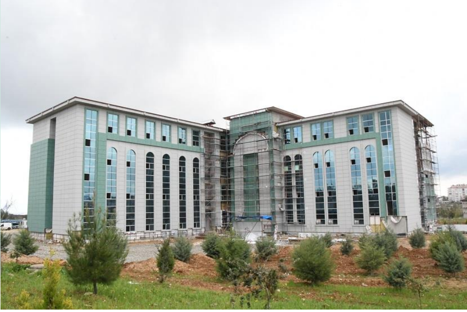
İslami İlimler Fakültesi Binası İnşaatı
