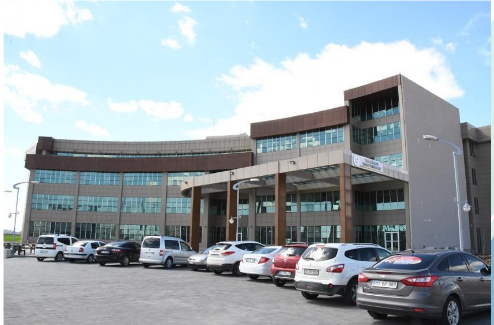
Teknik Bilimler M.Y.O Binası İnşaatı
