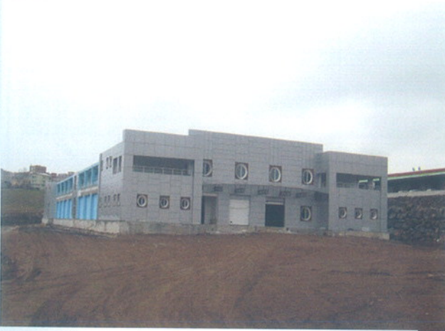
Balık Hali Ön Cephe Görünüşü
