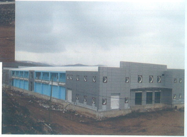
Balık Hali Arka Cephe Görünüşü
