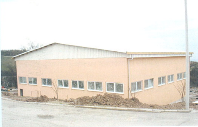
Tıbbi Atık Sterilizasyon Ünitesi Bina İnşaatı İnşaat çalışmaları 10 Aralık 2007 tarihinde başlamıştır.
