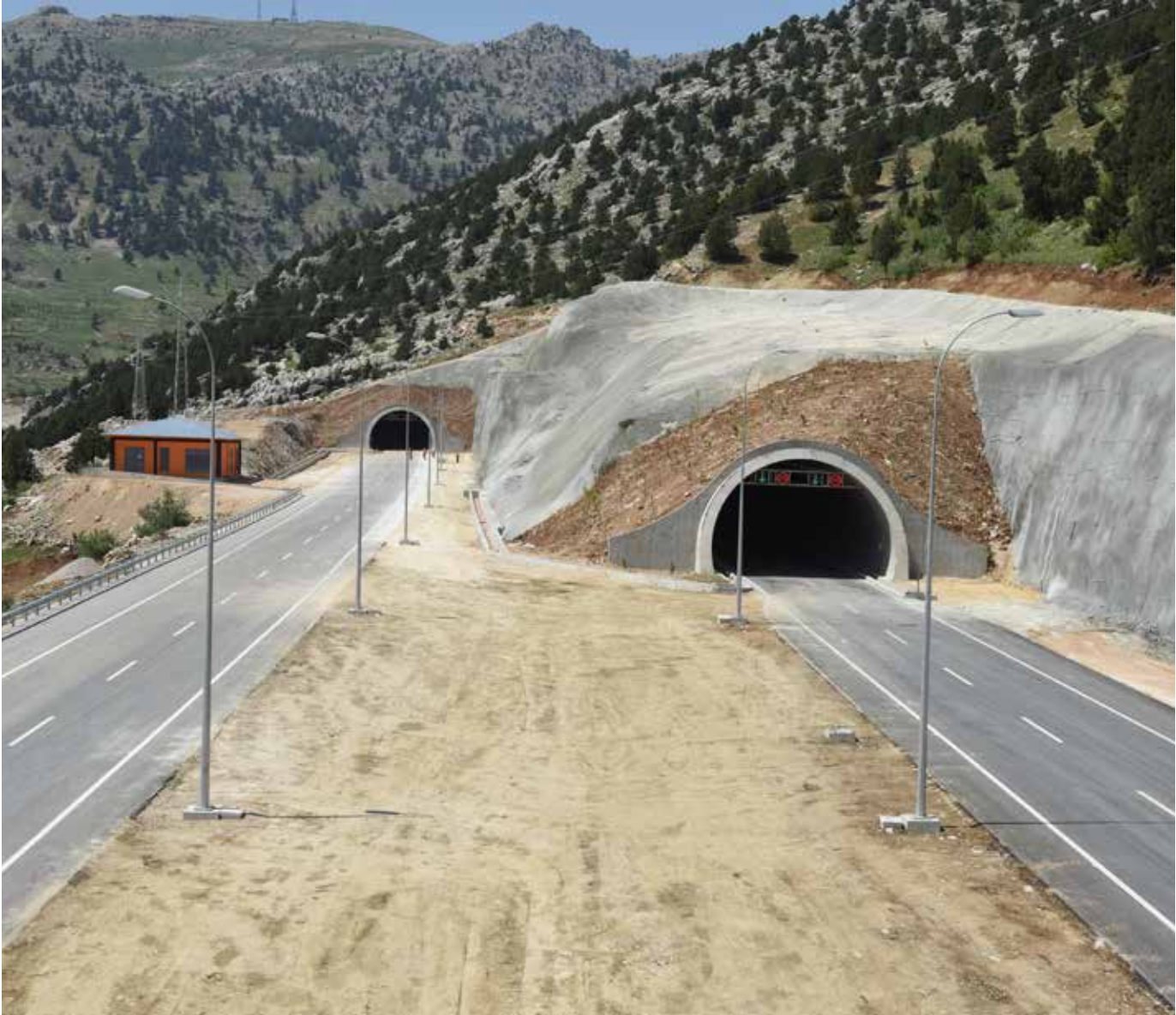
Göksun Tünelleri Kahramanmaraş
