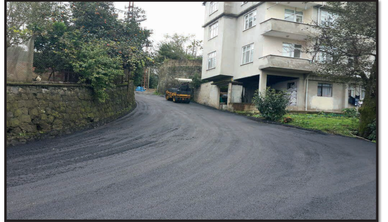
Müftü mahallesi yol düzenleme ve asfalt serim işi;
