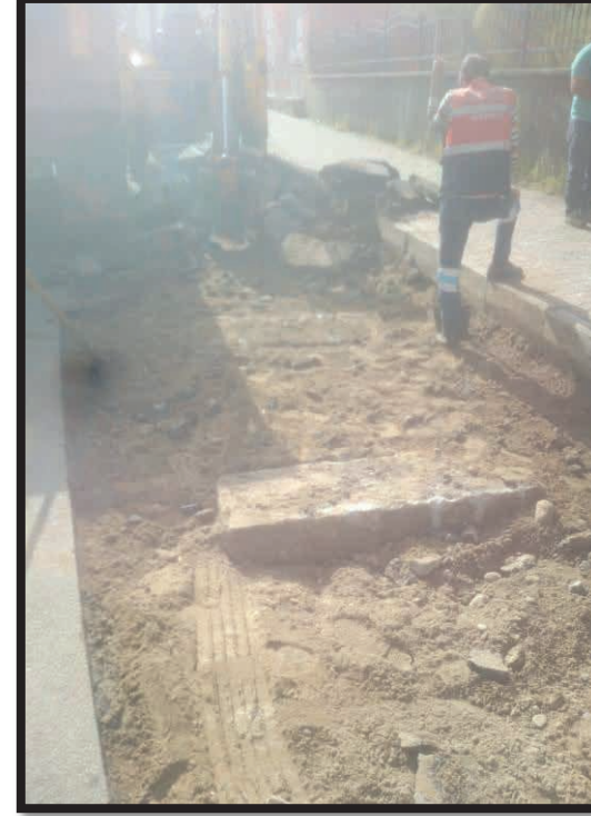
Asfalt yama çalışması
