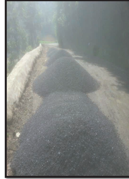
Kaplıca mahallesi yol düzenleme ve asfalt serim işi;
