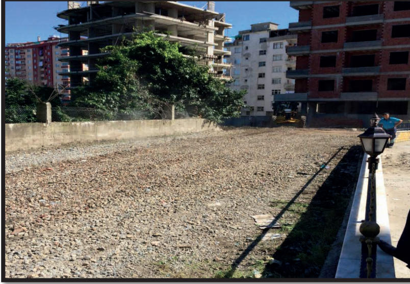
Portakallık mahallesi yol düzenleme ve asfalt serim işi;
