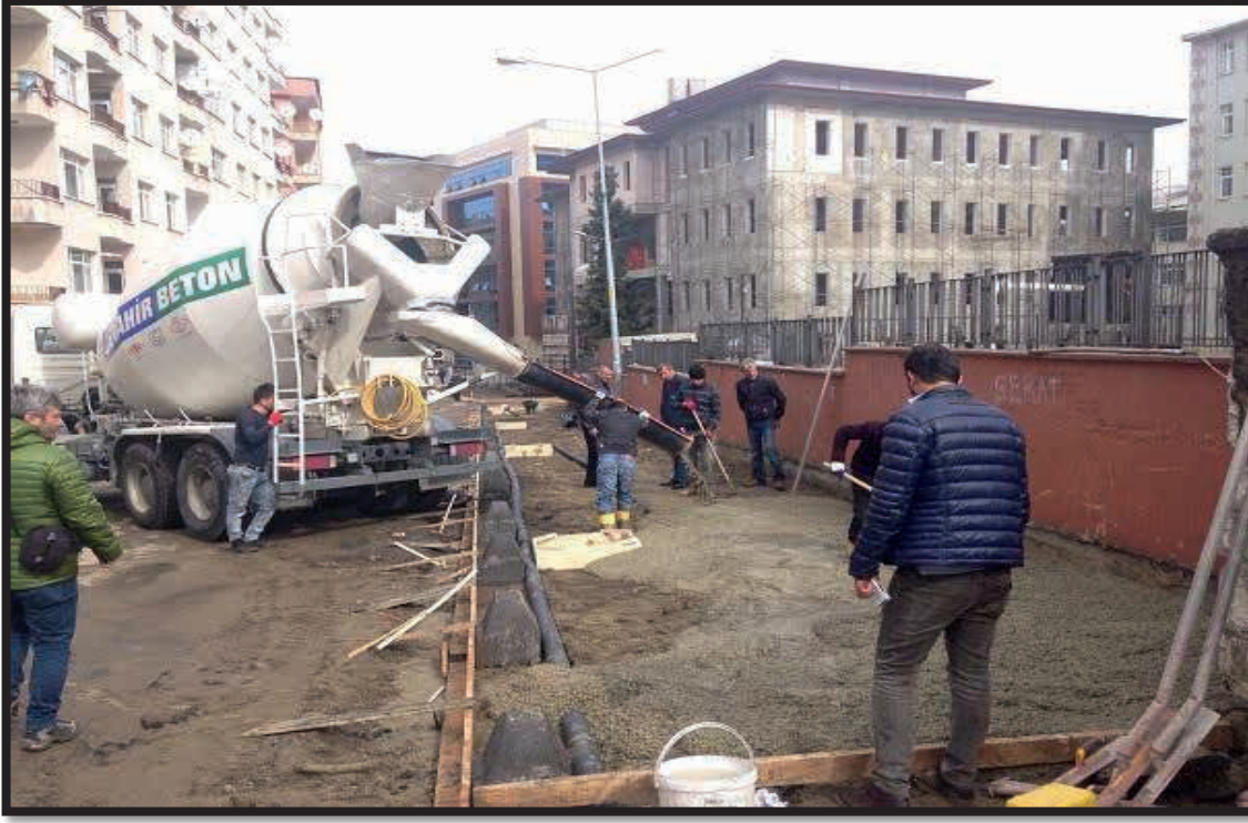
Paşakuyu mah. Zübeyde Hanım cad. ve yavuz Selim sok. ve yol kaldırım yapım işi;
