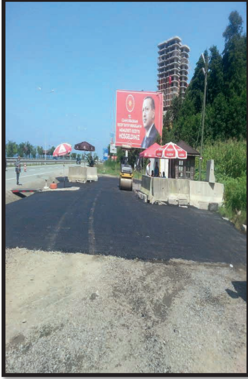
Alipaşa mahallesi yol düzenleme ve asfalt serim işi;
