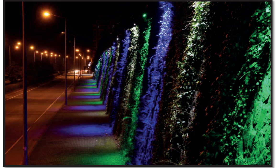
Duvar aydınlatma işi;
