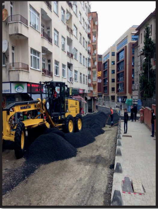
Paşakuyu mahallesi yol düzenleme ve asfalt serim işi;
