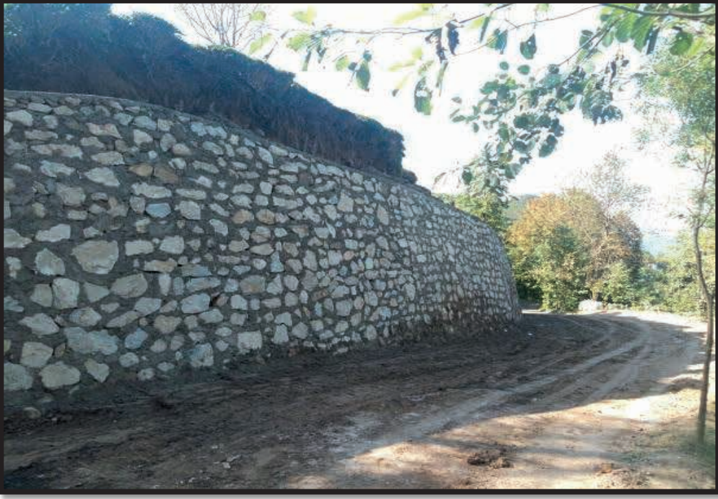
Taş duvar yapım işi:
