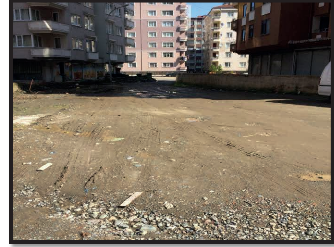
Gülbahar mahallesi yol düzenleme ve asfalt serim işi;
