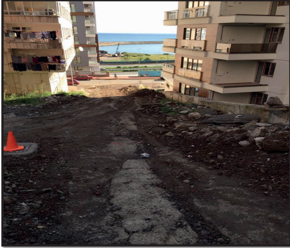
Camiönü mahallesi yol düzenleme ve asfalt serim işi;
