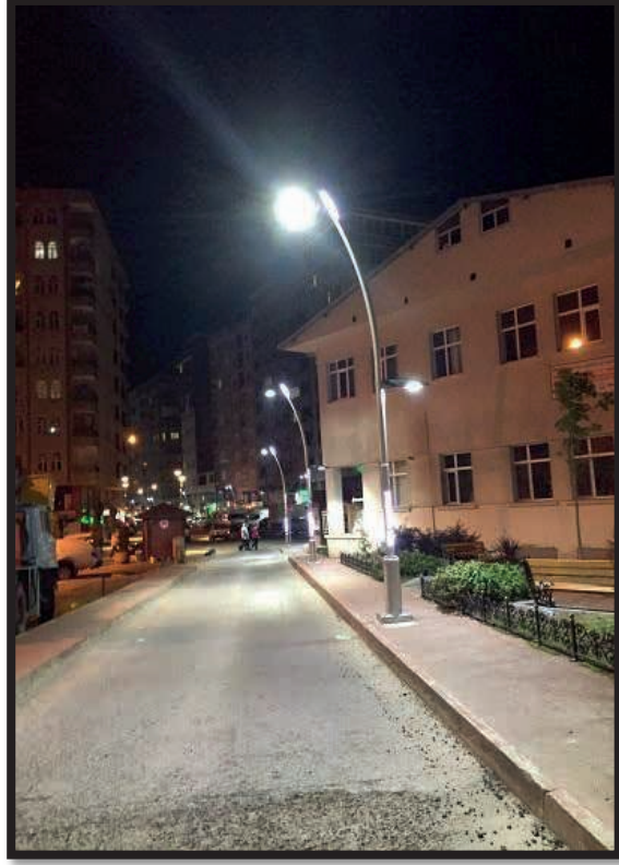
Paşakuyu ve Atmeydanı mahallesi aydınlatma işi yapımı;
