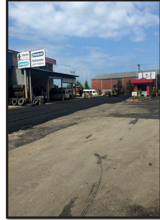
Sanayi sitesi yol düzenleme ve asfalt serim işi;
