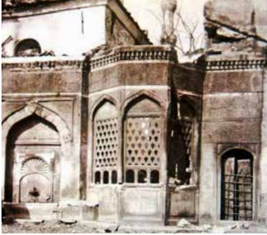
Sultanahmet Külliyesi Sebili
