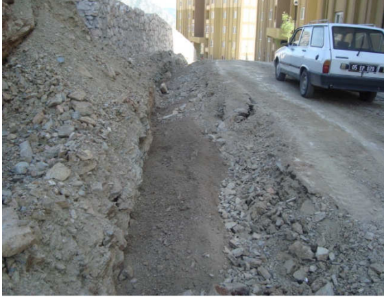
(Hızırpaşa Mah. İçme suyu hat çalışması)
