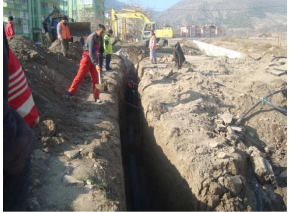
(Yazı Bağları Mah. Kanalizasyon çalışması)
