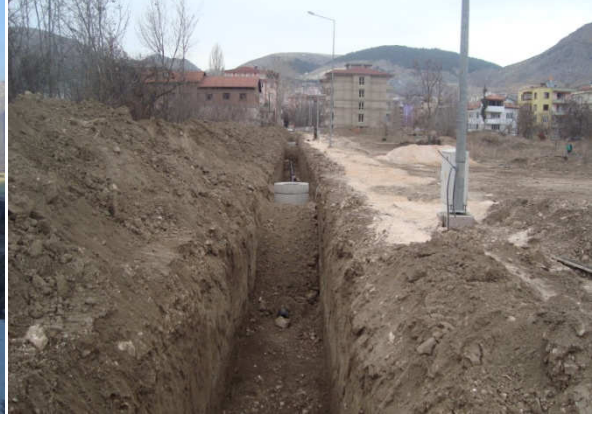
(Hacılar Meydanı Mah. Yağmur suyu hat çalışması)
