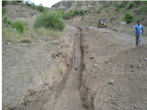
(Göllü Mah. İçme suyu hat çalışması)
