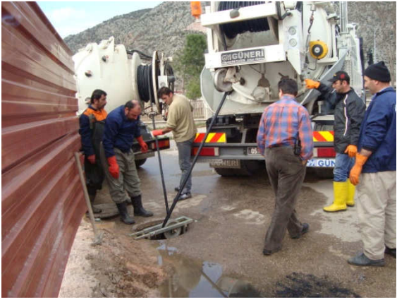
(Hacılar meydanı Kanalizasyon temizliği)
