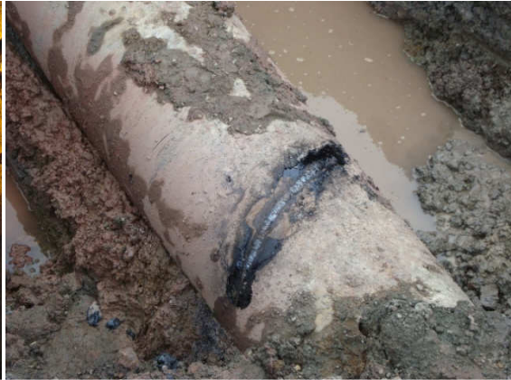
(İçme suyu çelik boru tamirâtı)
