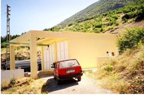
(İçme suyu Klor deposu bakım onarımı)
