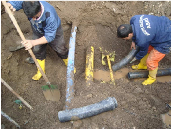
(İçme suyu tamirat çalışması )
