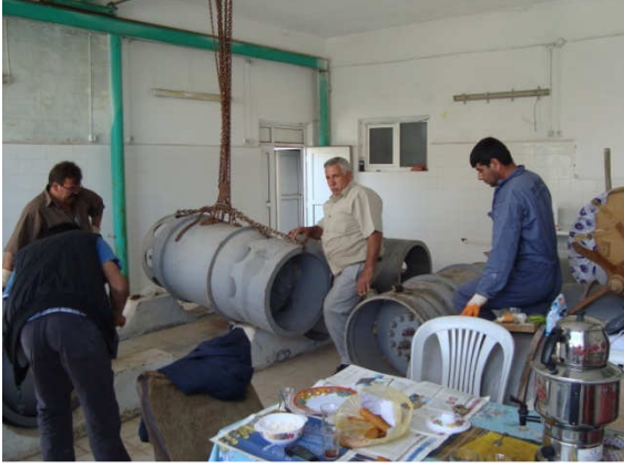
(İçme suyu klor depo bakım onarımı)
