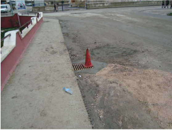
(Yağmur suyu ızgara tamirâtı )
