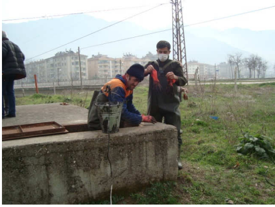
(Kanalizasyon terfi merkezi temizliği)
