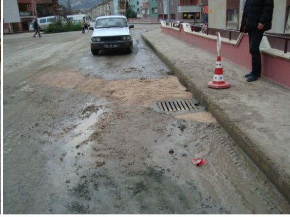
(Yağmur suyu ızgara tamirâtı)
