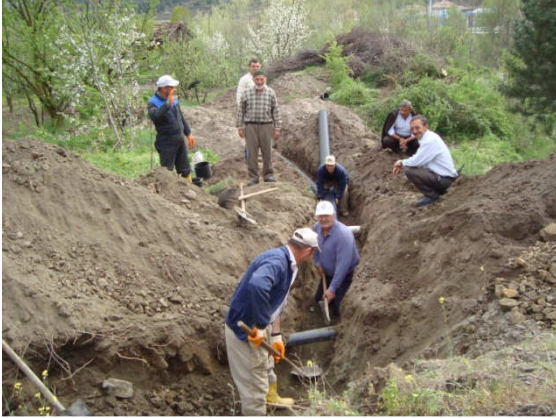
(Göllü Mah. Kanalizasyon hat çalışması)
