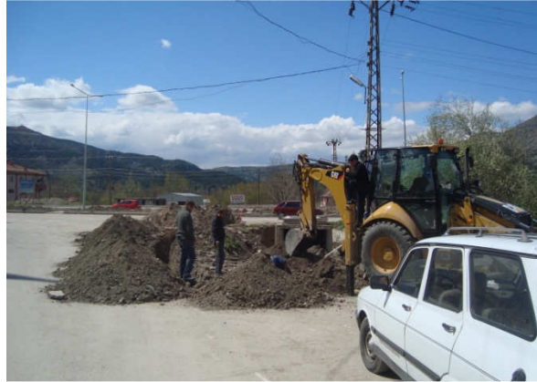
(Ormanbağları Mah. İçme suyu hat çalışması)
