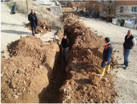
(Hızırpaşa Mah. Yağmur suyu hattı çalışmaları)
