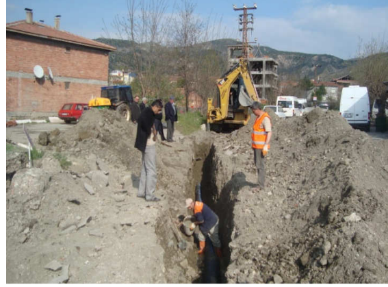
(Hızırpaşa Mah. içme suyu hat çalışması)
