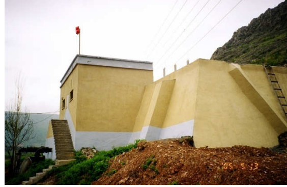
( İçme suyu depo onarımı )
