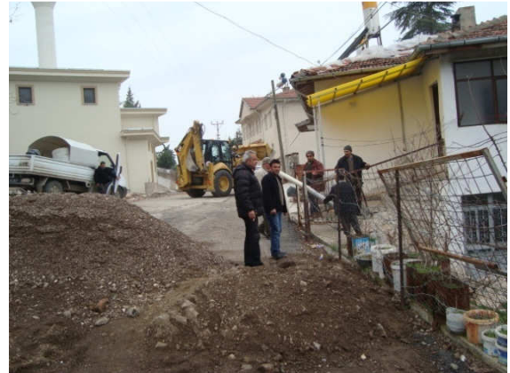
(Su ve Kanalizasyon nakliye aracı )
