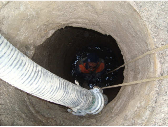
(Kanalizasyon baca temizliği)
