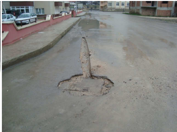
(Yağmur suyu baca onarımı)
