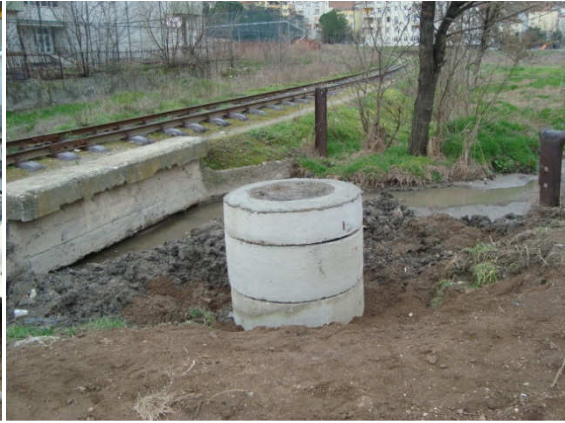
Kanalizasyon baca onarımı
