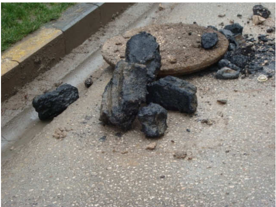
(Kanalizasyon baca temizliği)
