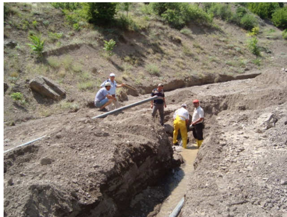
(Göllü Mah. İçme suyu hat çalışması)
