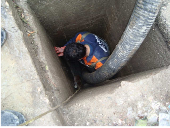
(Kanalizasyon baca temizliği)
