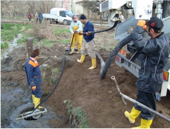
Kanalizasyon hat temizliđi
