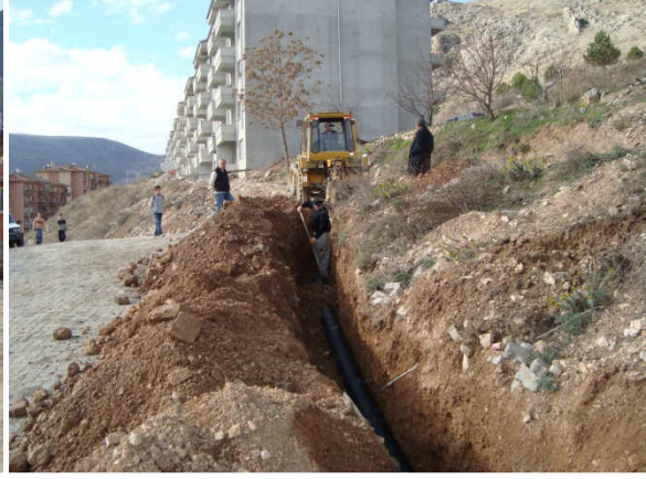
(Şeyhcu Mah. Kanalizasyon hat çalışması)
