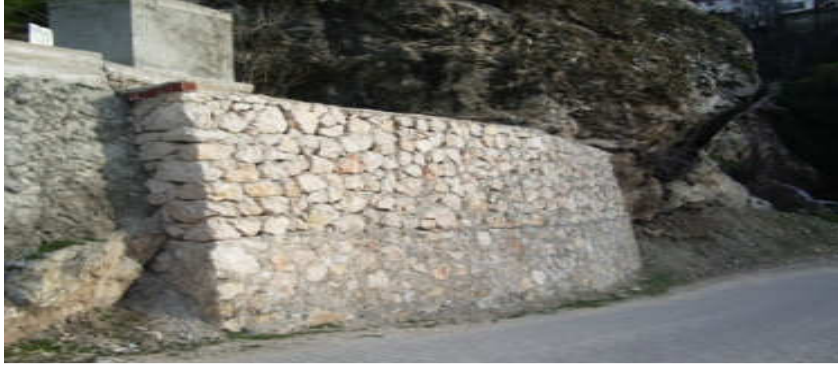
Savadiye taş duvar yapımı
