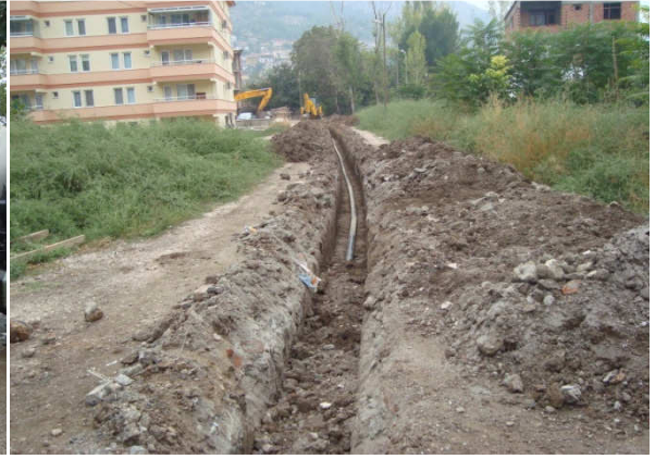
(Hacılar Meydanı Mah. Yağmur suyu hat çalışması)
