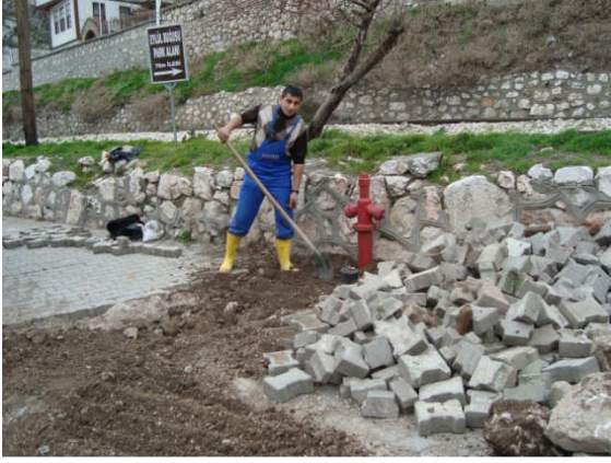
( Yangın vanası yapımı)
