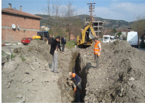
(Ormanbağları Mah. İçme suyu hat çalışması)
