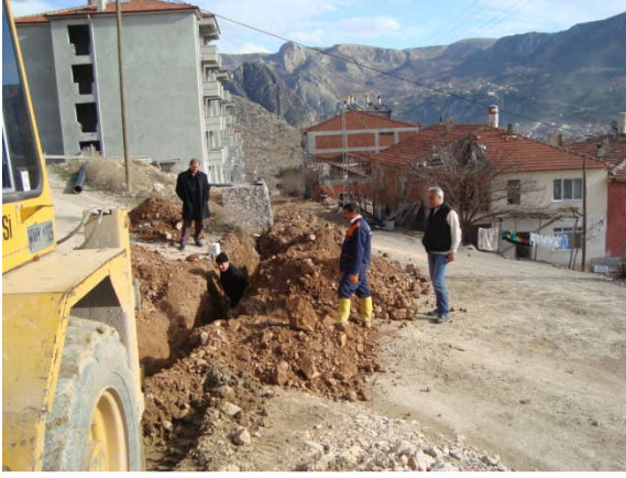
(Şeyhcu Mah. Kanalizasyon hat çalışması )
