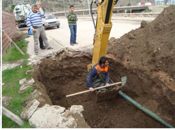
(İçme suyu tamirâtı)
