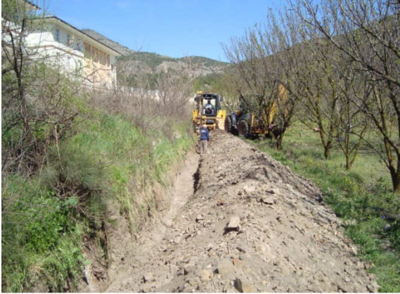
(Göllü Mah. Kanalizasyon hat çalışması )
