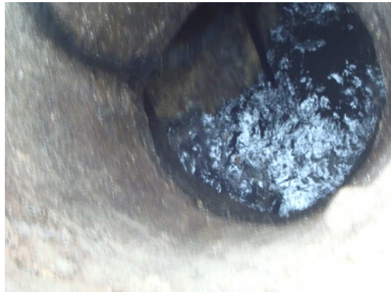
(Kanalizasyon baca temizliği)
