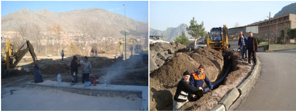
(H.Meydanı Mah. Yağmur suyu hat çalışması) (H.Meydanı Mah.Yağmur suyu hat çalışması)
