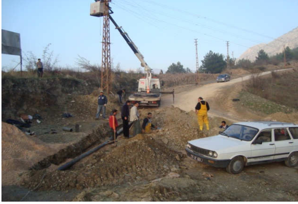
(Göllübağları Mah. içme suyu hat çalışması)
