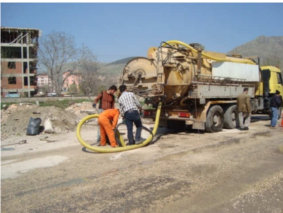
(Şeyhcu Mah.Kanalizasyon hat temizliği)
