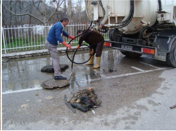
(Kanalizasyon hat temizliđi)
