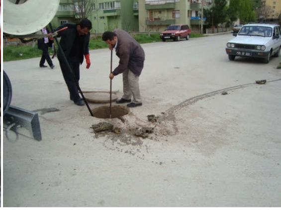
(HacılarMeydanı Kanalizasyon hat temizliği)
