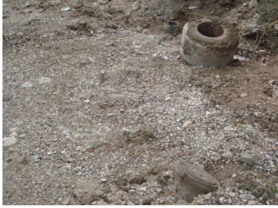
(İçme suyu vana tamirati)
