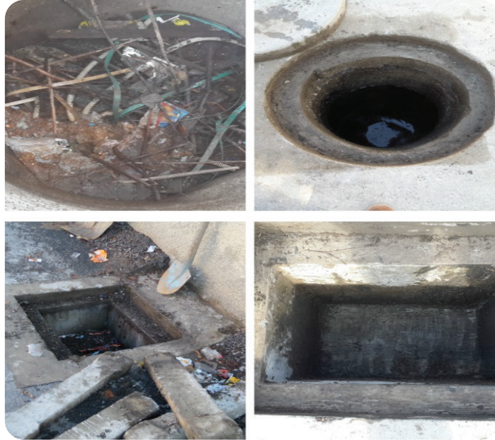
Yapılan ızgara ve baca temizlik çalışmaları
