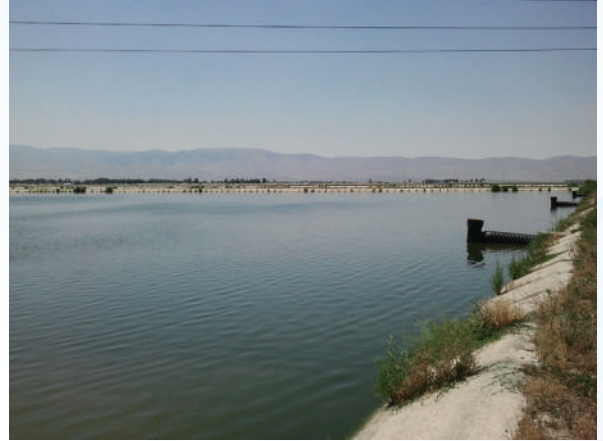
Anaerobik havuz boşaltılmış hali
