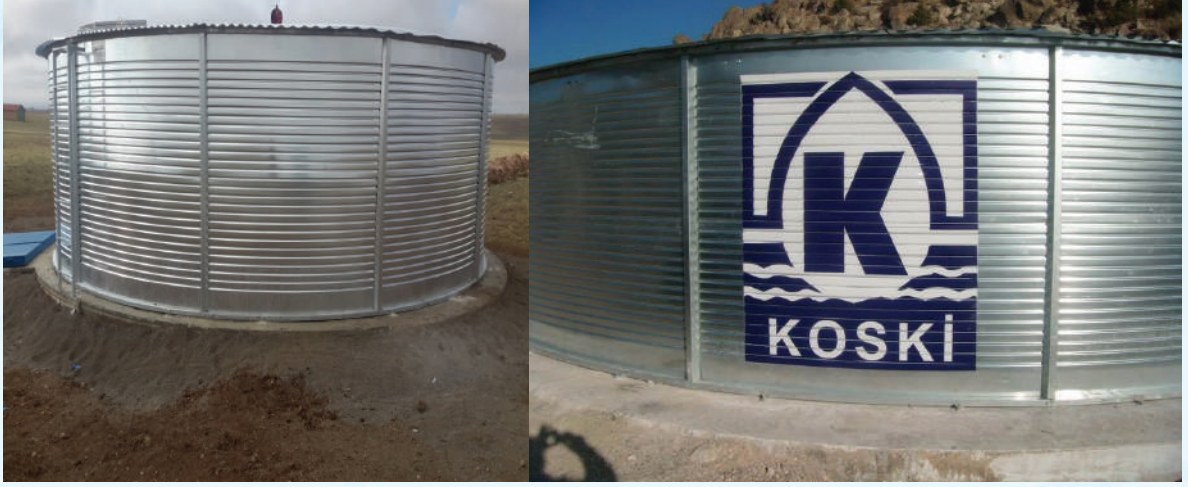
Membran depo yapılması işi.
