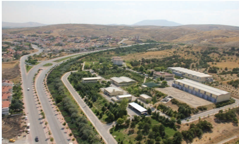
Şekil 3. Konya İçme Suyu Arıtma Tesisi
