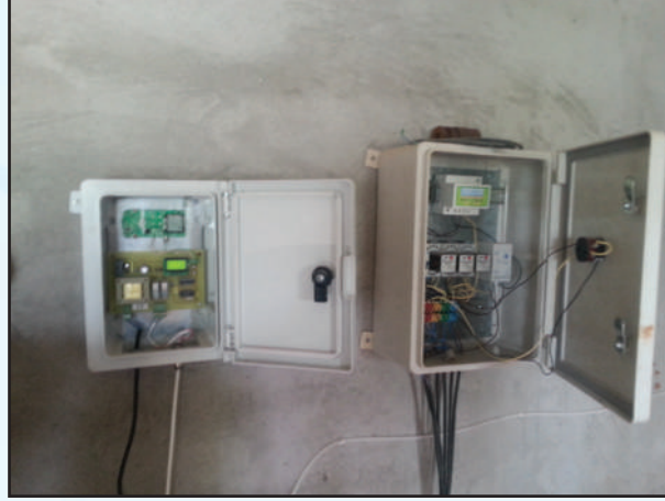
Bakımı Tamamlanıp Devreye Alınan Telemetri Cihazı
