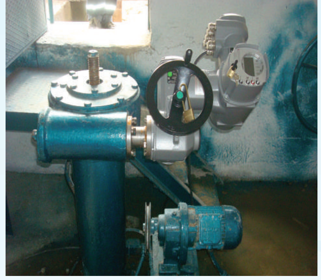
Resim 1-2. İçme suyu vanası auma motor montajı.
