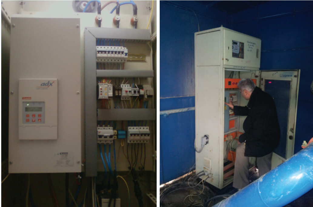
Soft Starter ve Frekans Konvertörü Panoları
