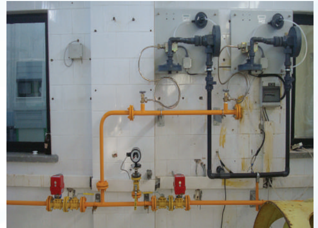
Resim 4. Klor binası yeni hali.
