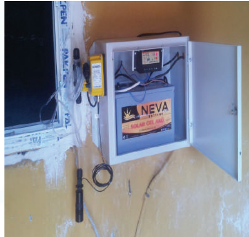
Resim 3-4. Güneş Panelli Depo( 12 V) Otomatik Klorlama Sistemi
