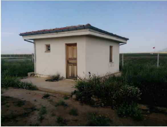
İdari bina eski hali
