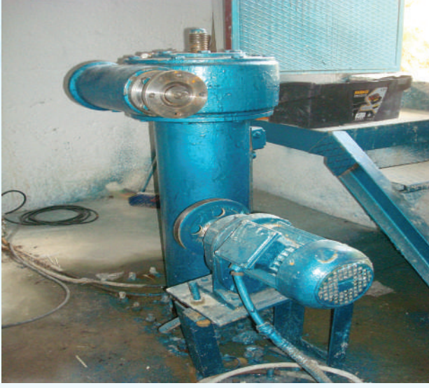
Resim 1-2. İçme suyu vanası auma motor montajı.
