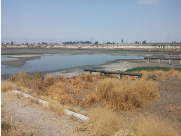
Anaerobik havuz dolu hali
