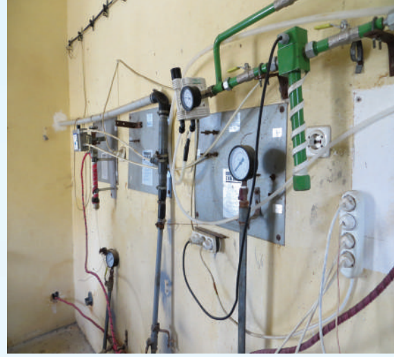
Resim 5-6. Beyşehir içme suyu gaz klorlama arızası görüntüleri.
