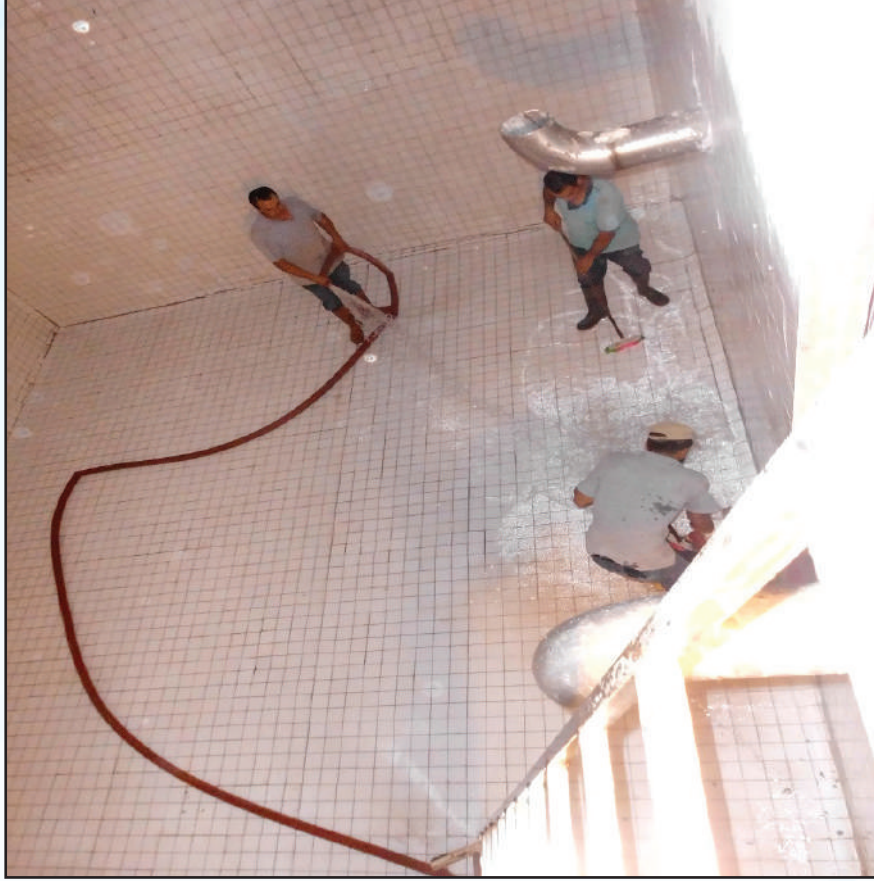
Resim 3. Merkezde ve İlçelerde su deposu temizlik ve dezenfeksiyon çalışması
