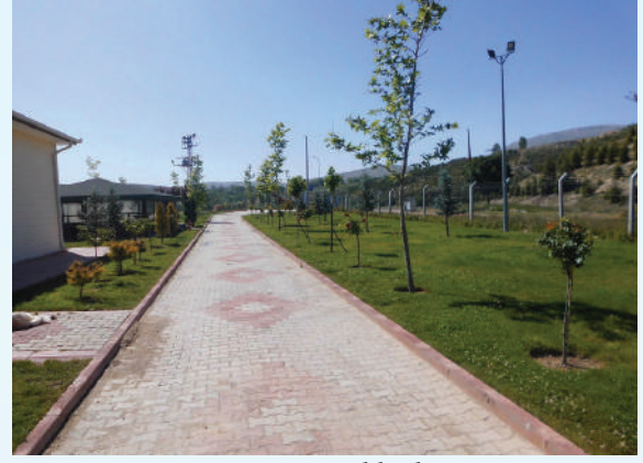
Resim 11. Baraj güvenlik işletme tesisi
