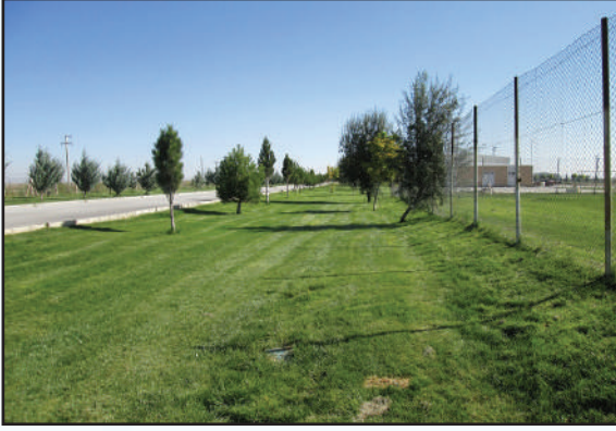
Resim 6. Atıksu arıtma tesisi
