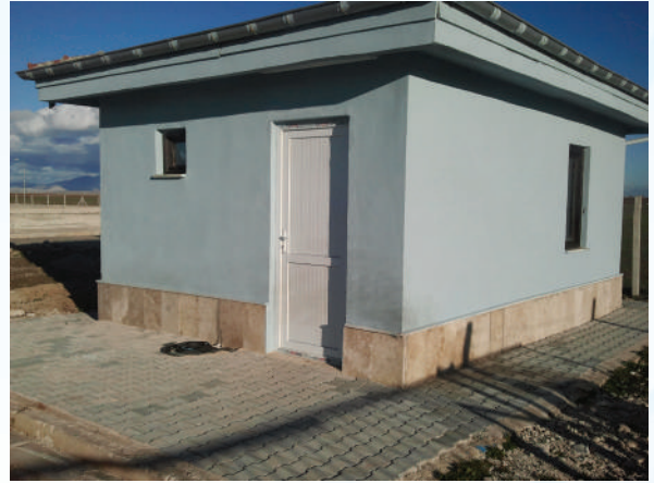
İdari bina yeni hali
