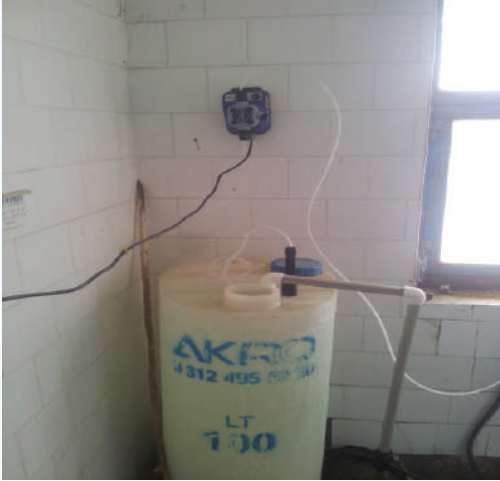
Resim 1. Kuyu (220 V) Otomatik Klorlama Sistemi
