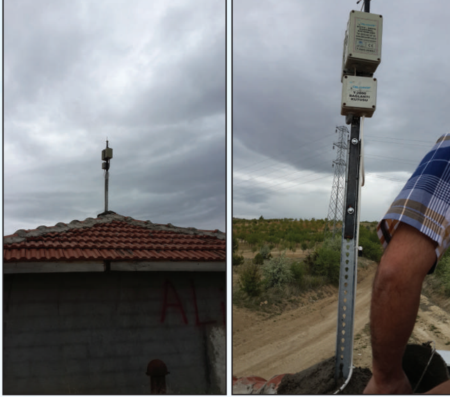
Beyşehir Ecirli Depo Kuyu Telemetri Montajı
