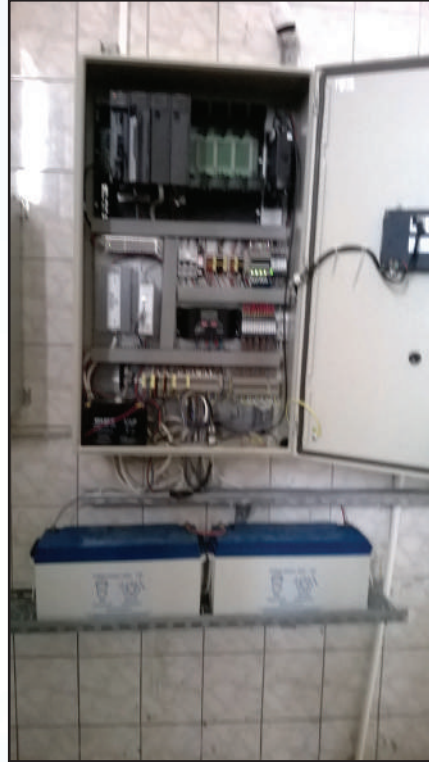
Karadiğın Kaynak Terfi RTU Panosu ve GP Aküleri
