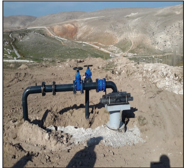
Yeni açılan kuyu'ya de montaj yapılması.
