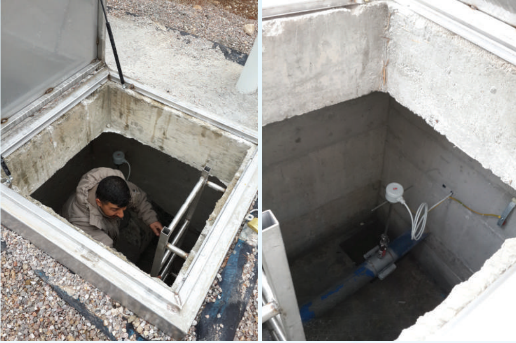
Pompa İstasyonu ve Depolarımızda Daldırma Tip Debimetre Montajı ve Devreye Alınması
