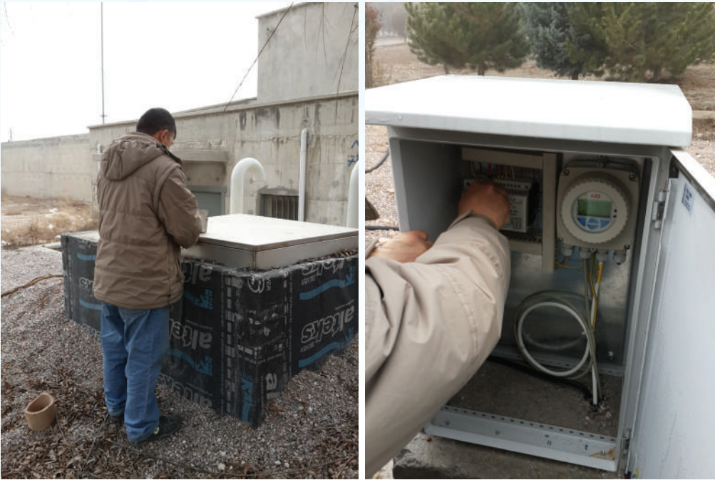
Pompa İstasyonu ve Depolarımızda Daldırma Tip Debimetre Montajı ve Devreye Alınması
