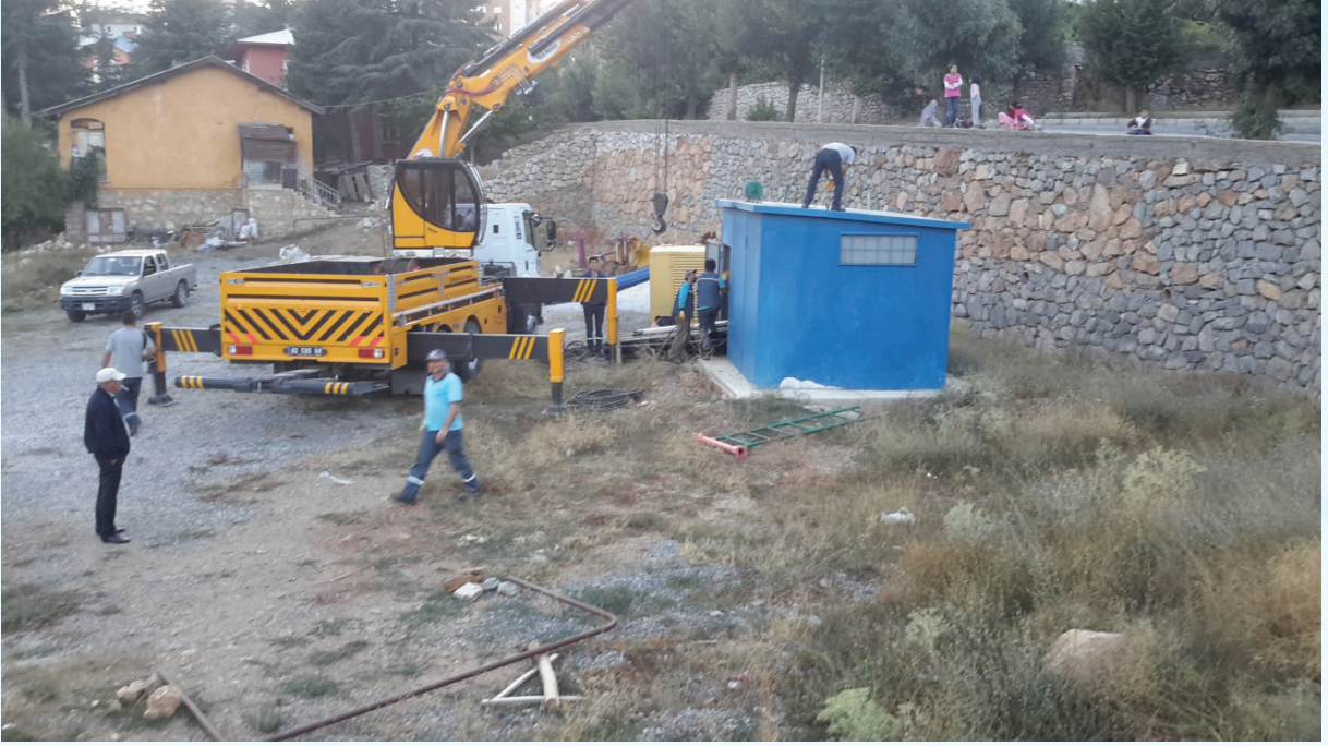
İçmesuyu kuyusu üzerine koruma amaçlı kuyu kabini indirilmesi.
