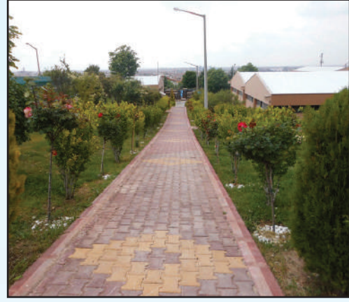
Resim 5. İçme suyu arıtma tesisi
