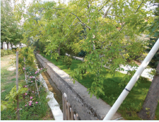
Resim 11. Çevre sulama işletme tesisi
