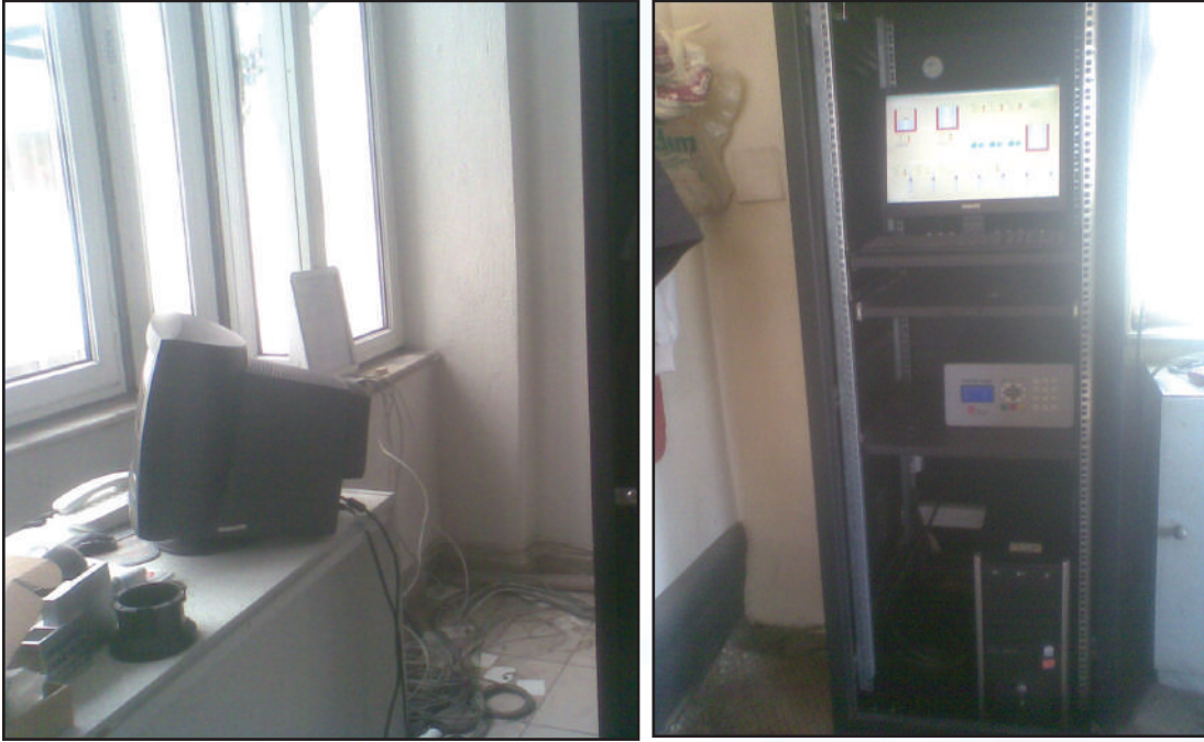
Beyşehir SCADA Odası Aktarımı ve Devreye Alma
