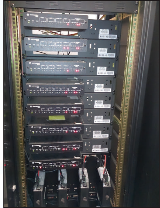
Merkez SCADA Sisteminde Eski Server ve Gateway Cihazları
