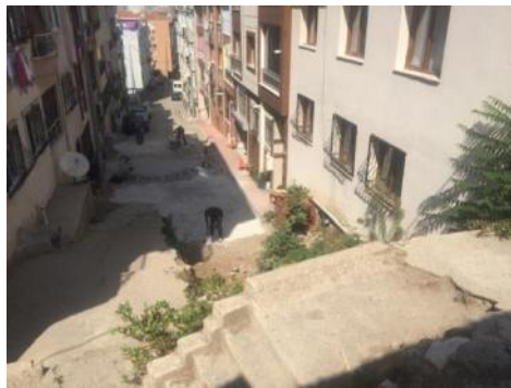
Kaldırım Parke Taşı Döşeme İşi Kontrolü
