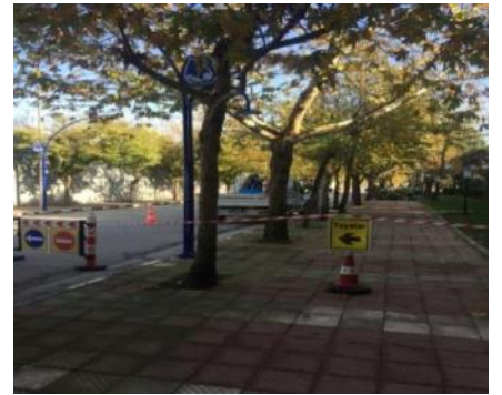
Asfalt Yama İşi Kontrolü
