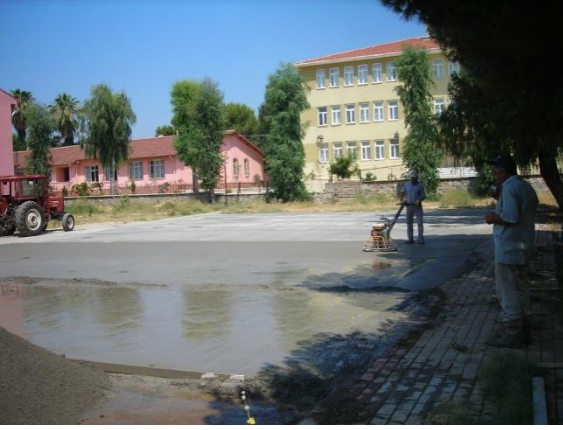
İnönü İlköğretim Okulu saha betonu
