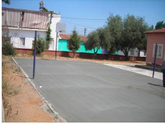
Ilıcabaşı İlköğretim Okulu basket sahası betonu
