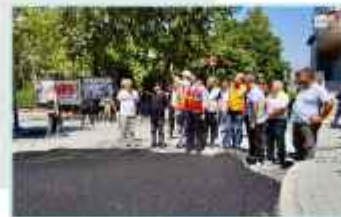
Merkez Mahallesi Menekşe Sokak'ta asfalt serimi çalışmalarını yerinde inceledik.
