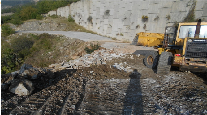
15- Sarıseki mahallesi çevre yolu otoban menfez çıkışında selden dolayı oluşan hafriyat dolum ve betonlama çalışması yapılmış olup, yol açılarak kullanılır hale getirilmiştir.
