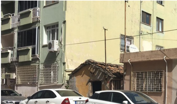
• Yenişehir Mahallesinde bulunan metruk bina
