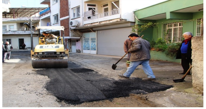
39-İlçemiz Dumlupınar mahallesinde bozulan ve tahrip olan asfaltın bakım onarımı Fen İşleri Müdürlüğümüze bağlı ekipler tarafından asfalt yama yapılmıştır.
