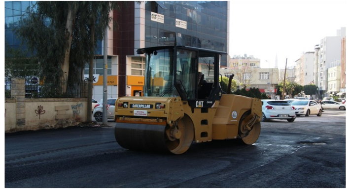
40-Fen işleri Müdürlüğüne bağlı ekiplerimiz tarafından İlçemiz Çay mahallesinde çeşitli nedenlerle bozulan tahrip olan yollar sıcak asfalt ile kaplama yapılmıştır.
