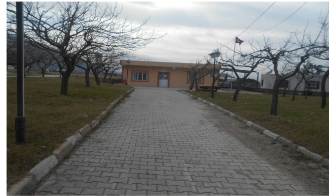
10- Çınarlı mahallesi muhtarlık binası tamirat tadilatı yapılmıştır.
