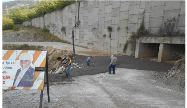
15- Sarıseki mahallesi çevre yolu otoban menfez çıkışında selden dolayı oluşan hafriyat dolum ve betonlama çalışması yapılmış olup, yol açılarak kullanılır hale getirilmiştir.
