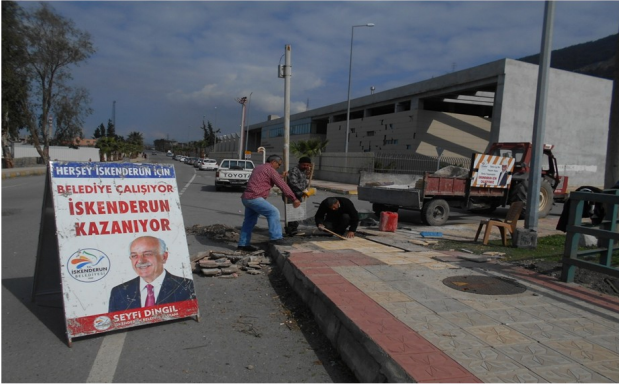
24- Sarseki mahallesinde Tayfun Sökmen caddesi üzerinde bulunan Meslek lisesi okulu kaldırımında hava şartların dandolayı bozulan deforme olan kaldırımında engelli rampası yapılmıştır
