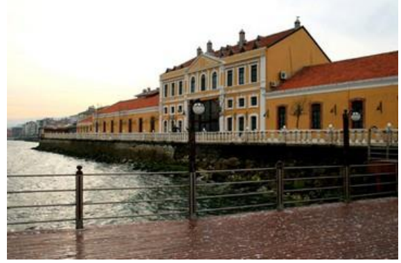
Fotoğraf: Montania Hotel (Gar Binası)
