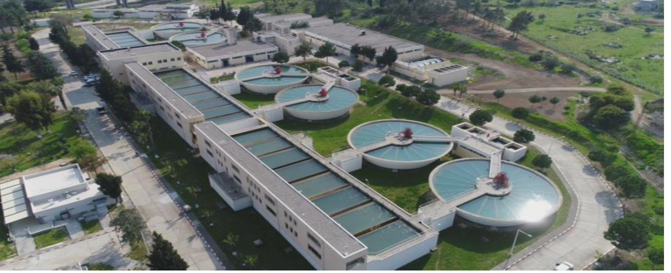
Tarsus Berdan İçme Suyu Arıtma Tesisi
