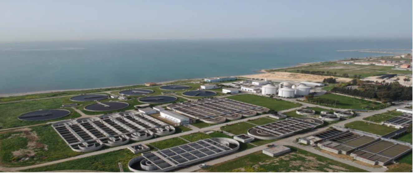
Mersin Merkez Karaduvar Atıksu Arıtma Tesisi
