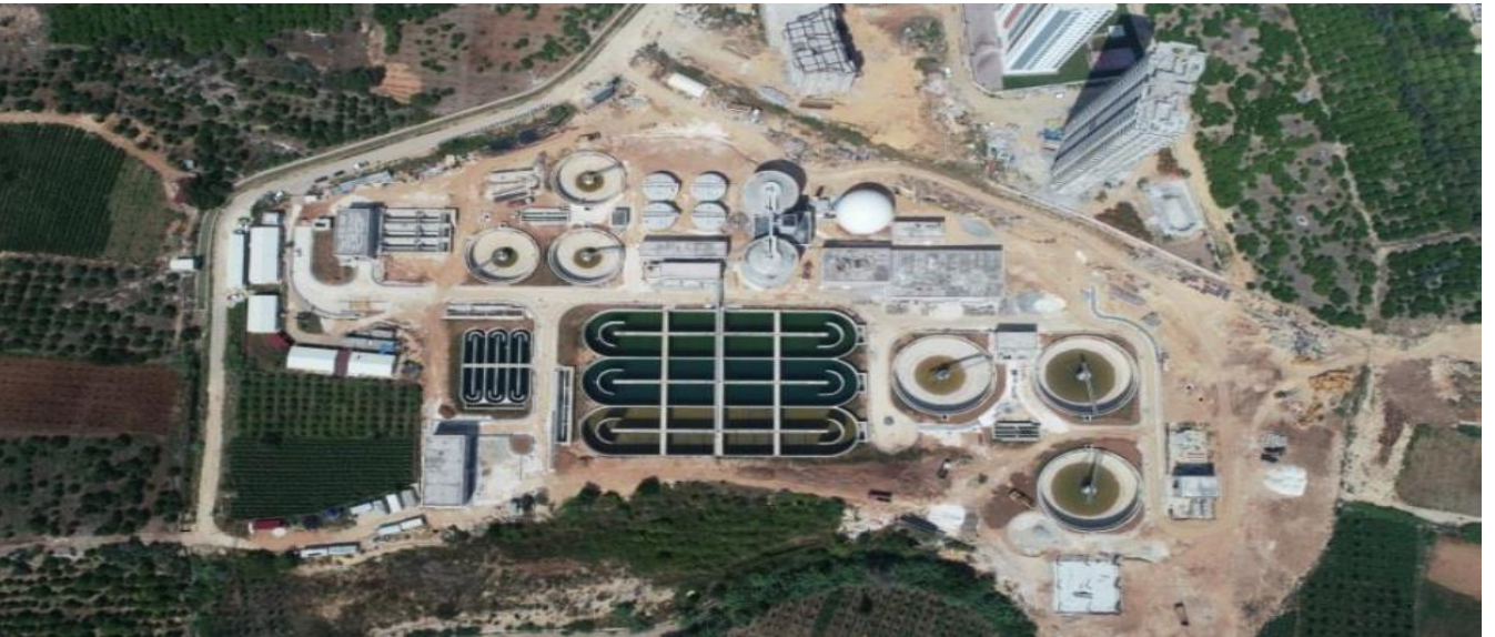
Mezitli Atıksu Arıtma Tesisi
