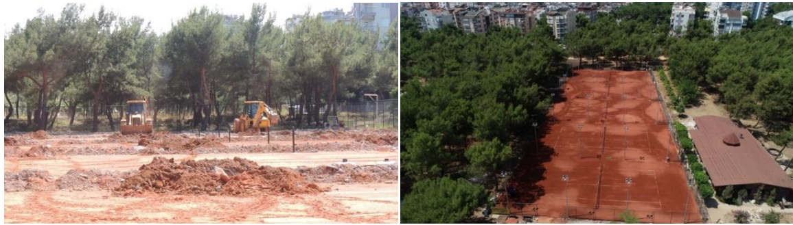
Tenis kortları alt yapı çalışması ve son hali
