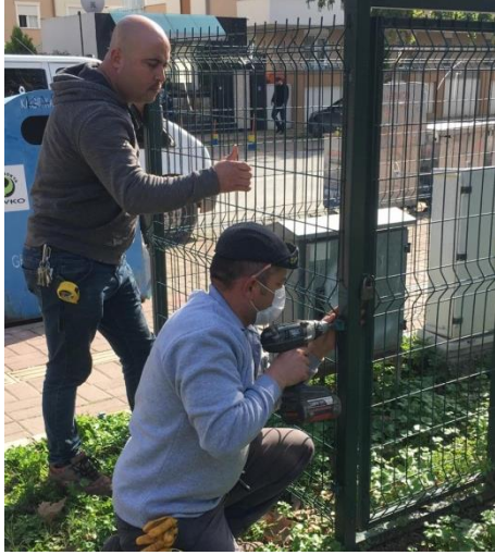
Panel çit uygulaması
