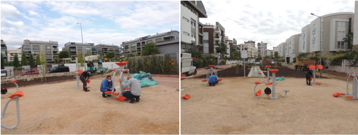
Park yapım çalışmaları
