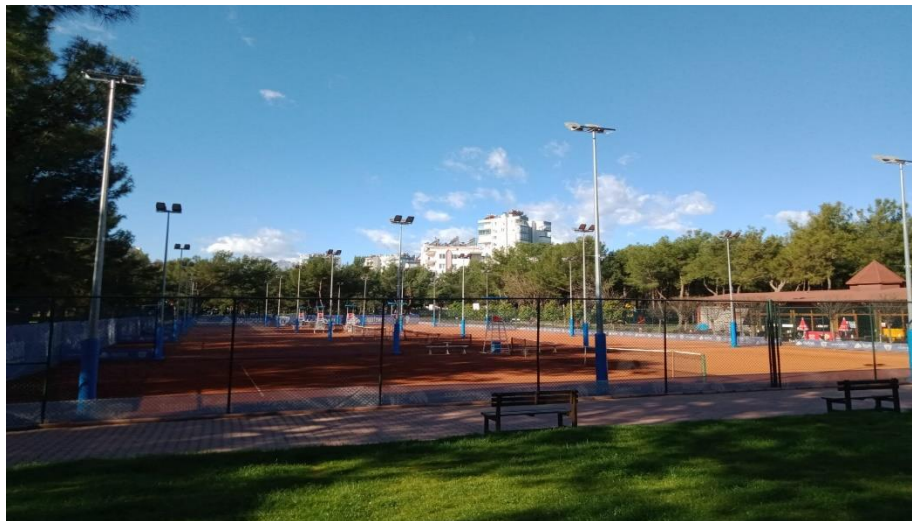
Resim 6 - Tenis Kortları Aydınlatılmasında kullanılan 8 metrelik galvaniz direkler ve 200W 4000K Led Projektörler
