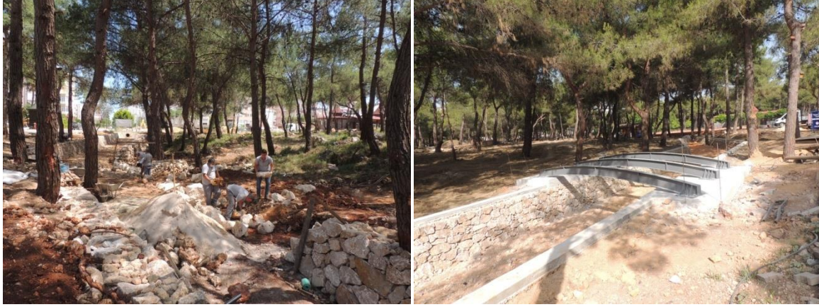
Dere duvarı ve köprü yapımı
