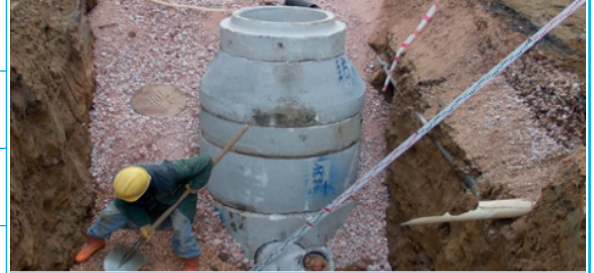
Yağmur Suyu ve Kanalizasyon Hattı İnşaatı
