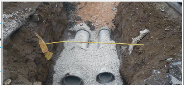
Altyapı Bakım Onarım Çalışması
