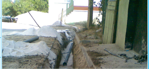
Altyapı Bakım Onarım Çalışması
