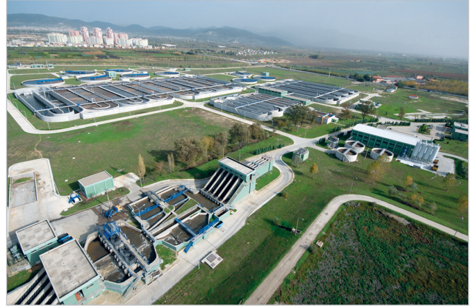
Doğu Atık Su Arıtma Tesisleri
