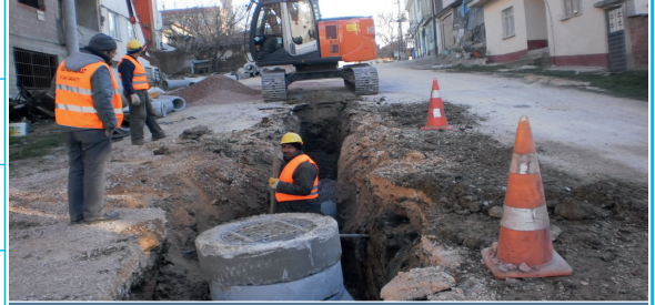
Acil Kanal Yapım İşİ
