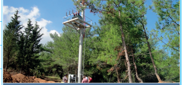
Enerji Nakil Hattı Yapımı
