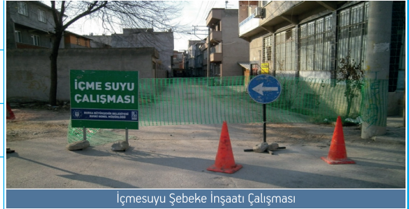
İçmesuyu Şebeke İnşaatı Çalışması
