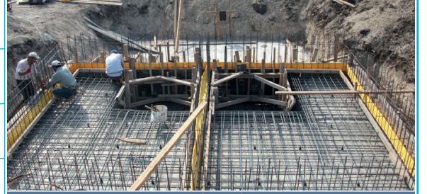
Depo İnşaatı İşi
