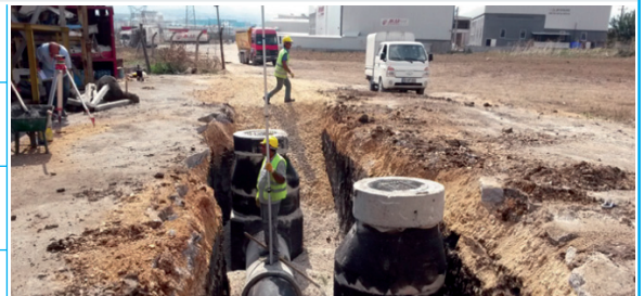
Yağmur Suyu ve Kanalizasyon Hattı İnşaatı
