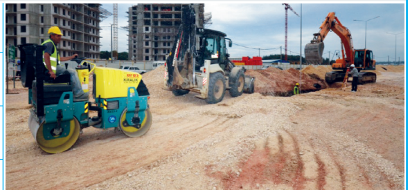
Yağmur Suyu ve Kanalizasyon Hattı İnşaatı
