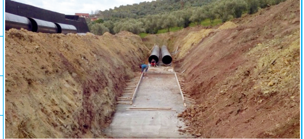
Betonarme Kutu Kesit İnşaatı
