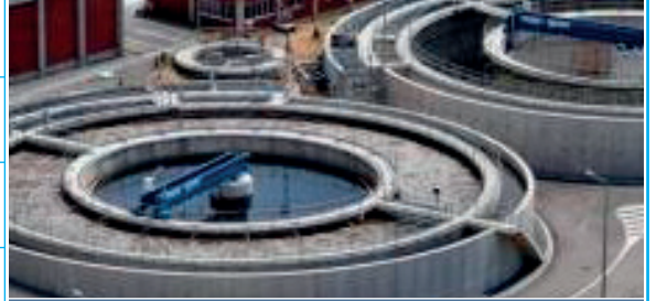
Atık Su Arıtma Tesis
