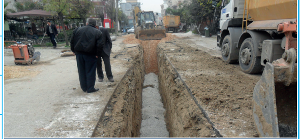
Yağmur Suyu ve Kanalizasyon Hattı İnşaatı
