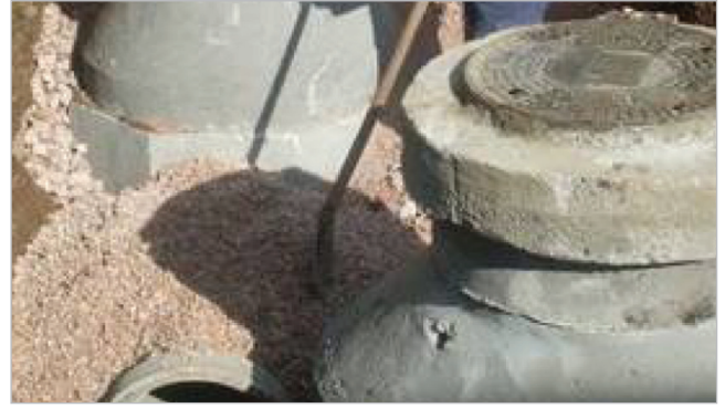
Kanalizasyon Hattı Çalışması
