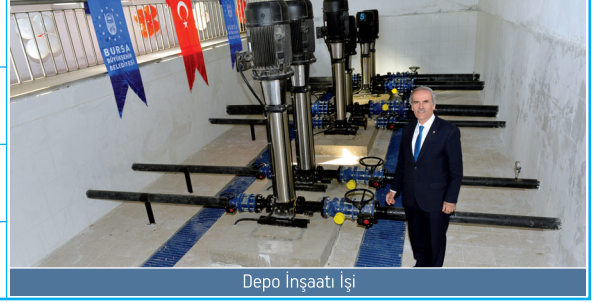
Depo İnşaatı İşi
