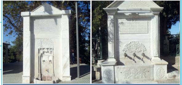
Onarılan Beşir Ağa Çeşmesi - Fatma Hanım Çeşmesi
