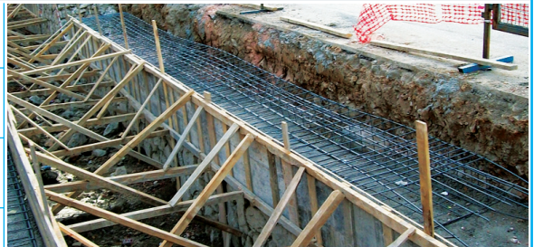
Yağmur Suyu ve Kanalizasyon Hattı İnşaatı
