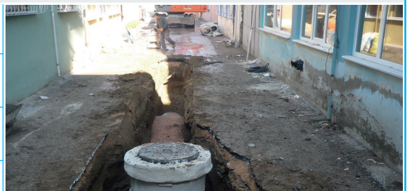
Acil Kanal Yapım İşİ
