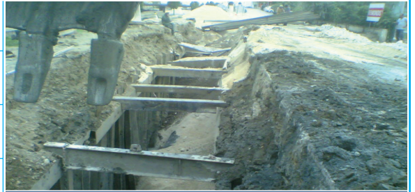
Altyapı Bakım Onarım Çalışması
