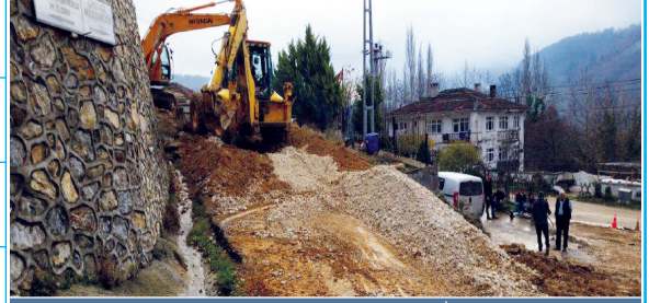
Yağmur Suyu ve Kanalizasyon Hattı İnşaatı
