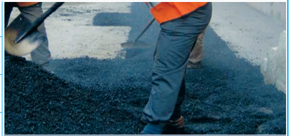
Asfalt Yapım Bakım Onarım Çalışması
