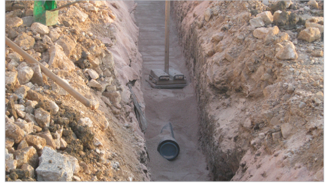
İçme Suyu İnşaatı
