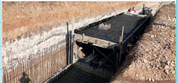
Kutu Kesit ve Box Yapım İşi
