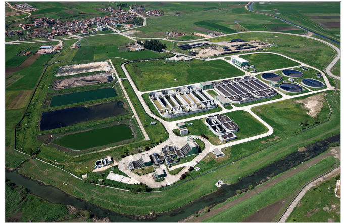
Batı (Özlüce) Atık Su Arıtma Tesisleri
