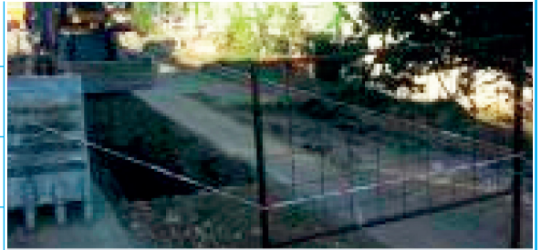
Acil Kanal Yapım İşİ
