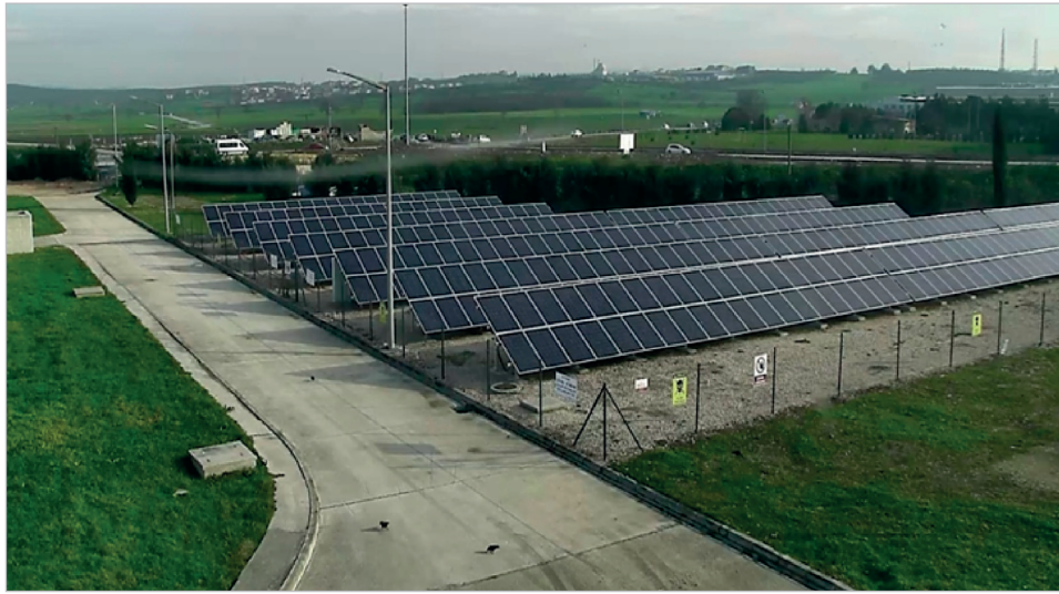
Batı AAT Güneş Enerjisi Sistemi
