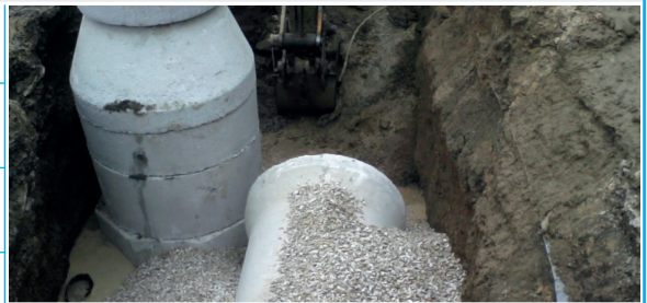
Altyapı Bakım Onarım İnşaatı Yapım İşİ
