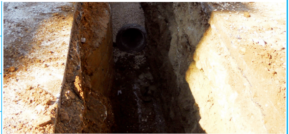
Altyapı Bakım Onarım Yapım İşi
