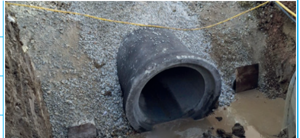
Yağmur Suyu ve Kanalizasyon Hattı İnşaatı
