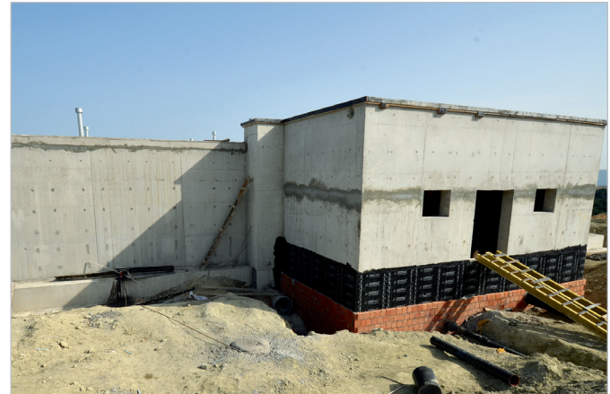
Su Deposu İnşaatı
