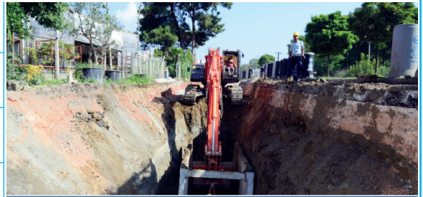
Yağmur Suyu ve Kanalizasyon Hattı İnşaatı
