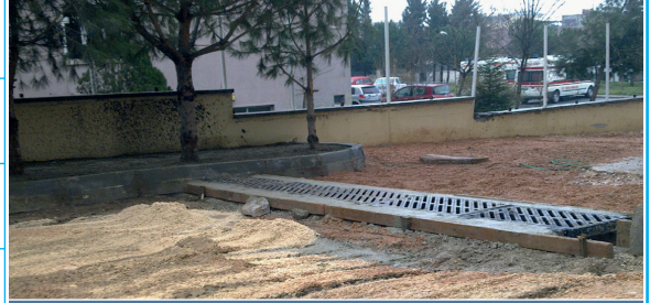
Izgara Ve Bağlantılarının Yapılması Çalışması
