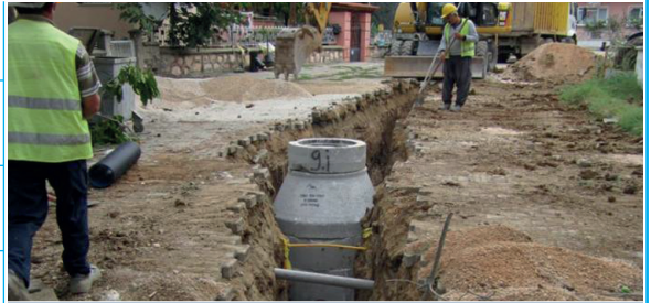
Kanalizasyon Hattı İnşaatı
