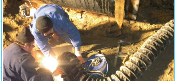
Yağmur Suyu ve Kanalizasyon Hattı İnşaatı
