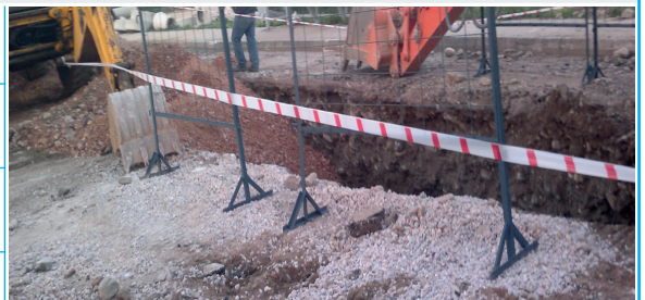
Acil Kanal Yapım İşİ
