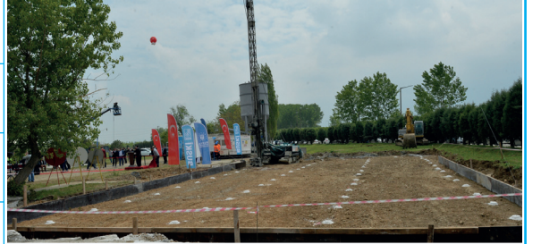
Çamur Yakma Tesis İnşaatı
