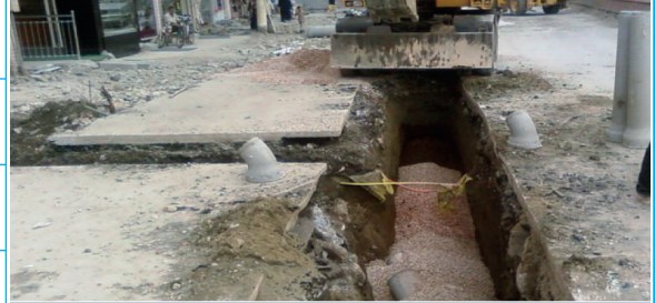
Yağmur Suyu ve Kanalizasyon Hattı İnşaatı
