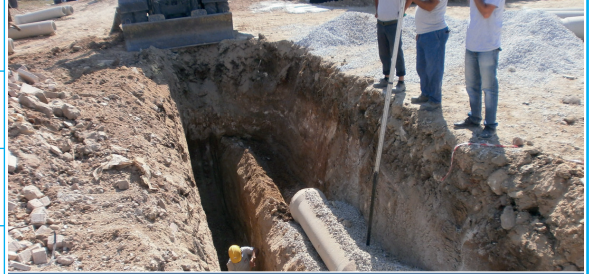
Acil Kanal Yapım İşİ
