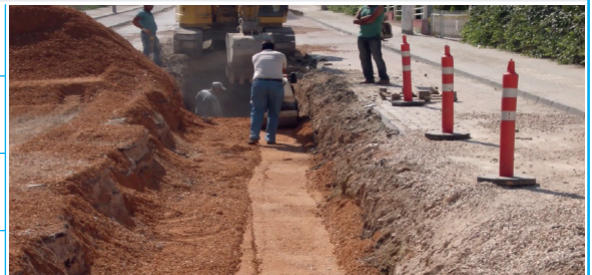
Yağmur Suyu ve Kanalizasyon Hattı İnşaatı
