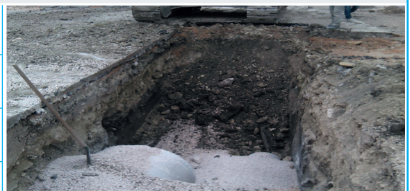
Yağmur Suyu ve Kanalizasyon Hattı İnşaatı
