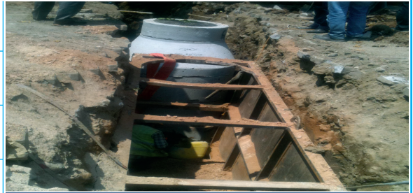
Acil Kanal Yapım İşİ
