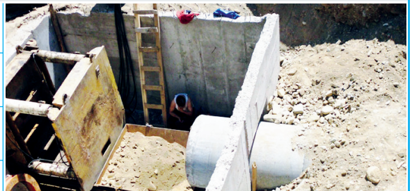
Yatay Delgi İnşaatı
