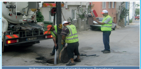
Yağmursuyu Hatları Görüntüleme ve Temizleme
