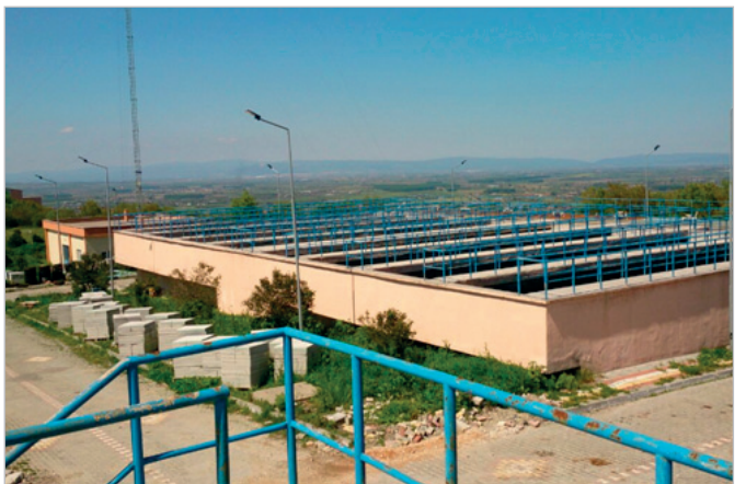
İnegöl Alayunt İçmesuyu Arıtma Tesisleri
