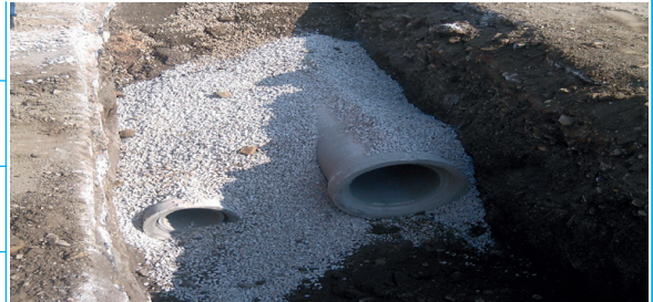
Yağmur Suyu ve Kanalizasyon Hattı İnşaatı
