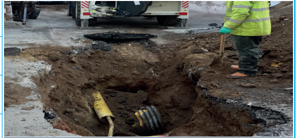
Altyapı Bakım Onarım Çalışması
