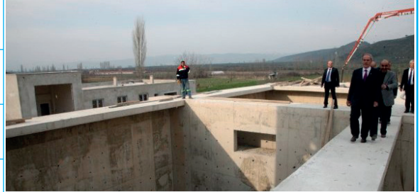
Arıtma Tesisi İnşaatı
