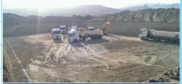
Su Deposu İnşaatı
