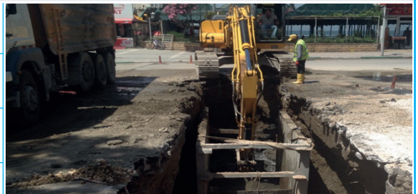
Yağmur Suyu ve Kanalizasyon Hattı İnşaatı
