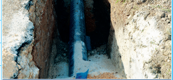
Altyapı Bakım Onarım Çalışması
