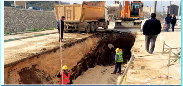
Yağmur Suyu ve Kanalizasyon Hattı İnşaatı
