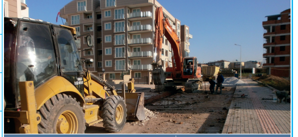
Acil Kanal Yapım İşİ
