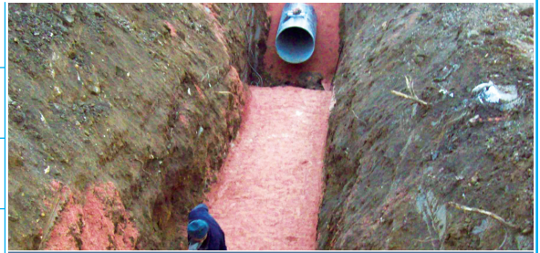
İçmesuyu Şebeke ve İsale Hattı İnşaatı
