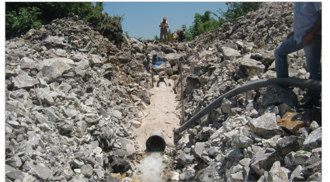
Yeraltı Suyu İnşaatı
