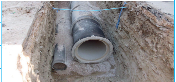
Yağmur Suyu ve Kanalizasyon Hattı İnşaatı
