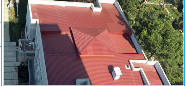
BUSKİ Abone İşleri Binası Çatı Onarımı
