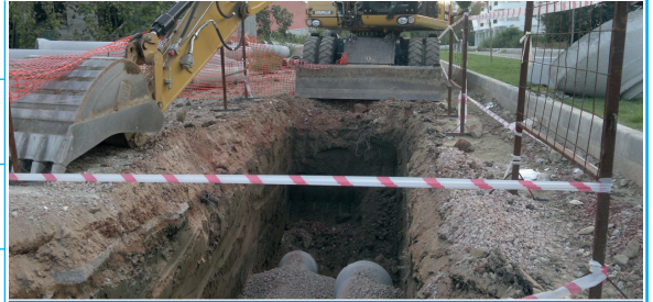
Acil Kanal Yapım İşİ
