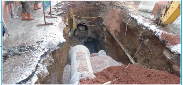
Yağmur Suyu ve Kanalizasyon Hattı İnşaatı
