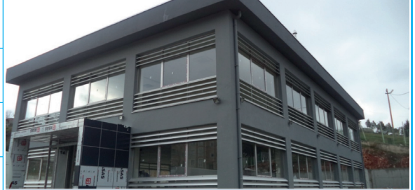
Kestel Hizmet Binası İnşaatı
