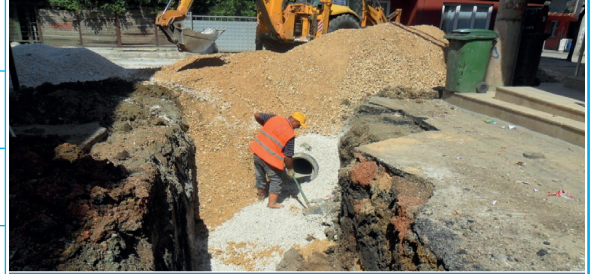
Yağmur Suyu ve Kanalizasyon Hattı İnşaatı
