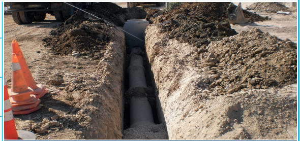
Kanal Yapım İşİ
