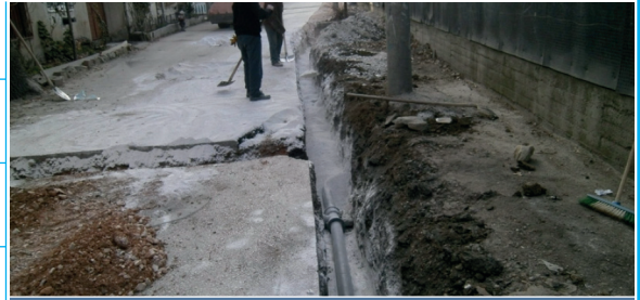
İçmesuyu Şebeke İnşaatı Çalışması
