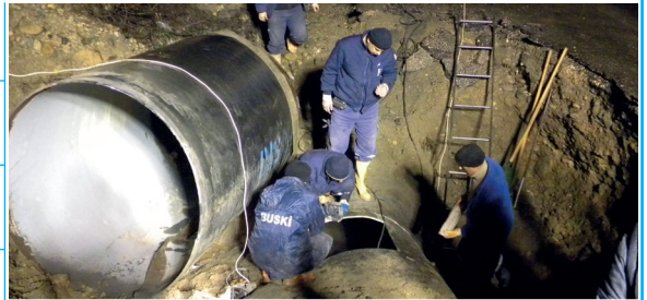
Yağmur Suyu ve Kanalizasyon Hattı İnşaatı
