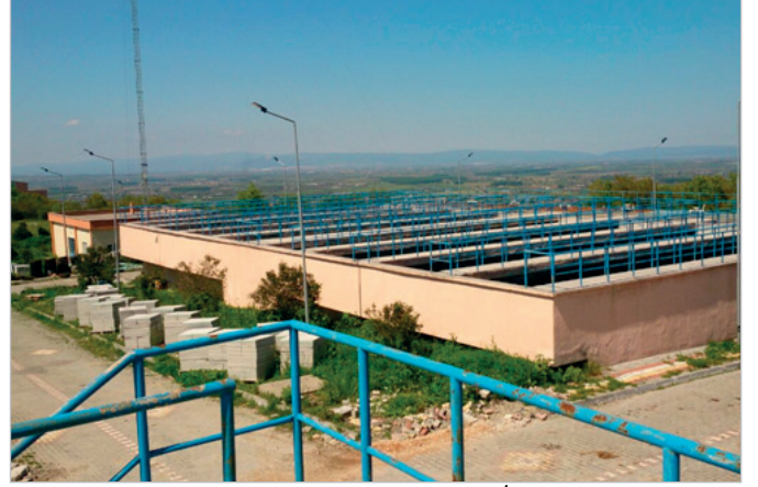
Mustafakemalpaşa Çan Deresi İçmesuyu Arıtma Tesisi
