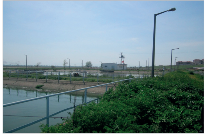
Karacabey Atık Su Arıtma Tesisi
