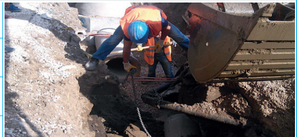
Yağmur Suyu ve Kanalizasyon Hattı İnşaatı
