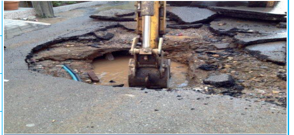
İçme Suyu Arızaları Yapım İşİ
