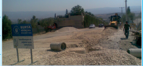
Yağmur Suyu ve Kanalizasyon Hattı İnşaatı
