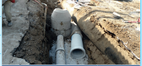
Yağmur Suyu ve Kanalizasyon Hattı İnşaatı
