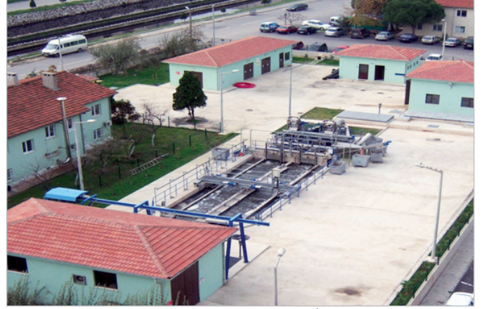
Gemlik-Nacaklı İçme Suyu Arıtma Tesisi
