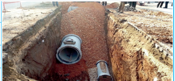
Kanalizasyon Hattı İnşaatı
