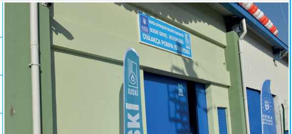
Depo İnşaatı İşi
