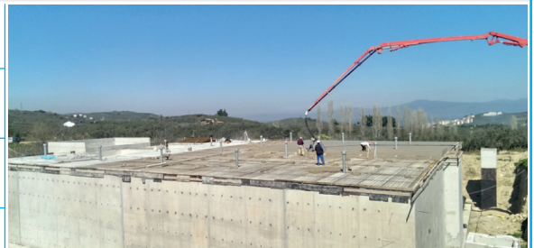
Su Deposu İnşaatı
