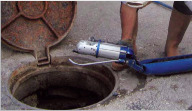
Kanal Görüntüleme Çalışmaları
