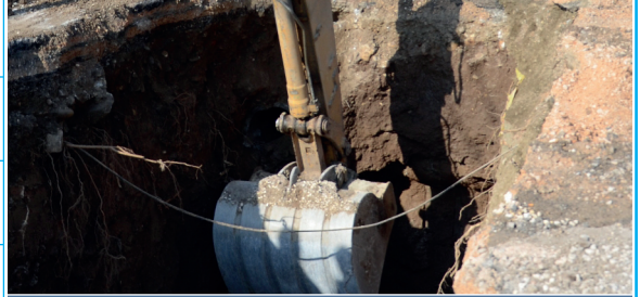
Kanalizasyon Hattı İnşaatı
