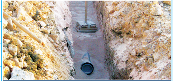
İçmesuyu Şebeke ve İsale Hattı İnşaatı
