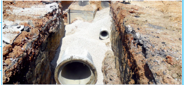
Yağmur Suyu ve Kanalizasyon Hattı İnşaatı
