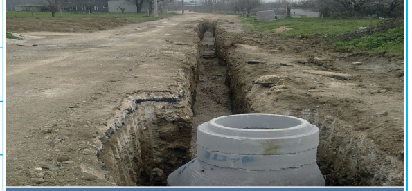
Altyapı Bakım Onarım Çalışması
