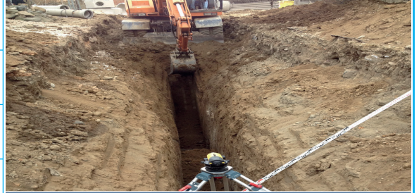
Altyapı Bakım Onarım Çalışması
