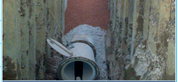
Acil Kanal Yapım İşİ
