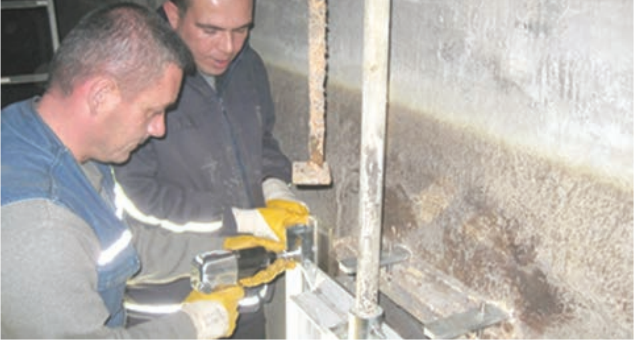
Filtre Ünitesi Ø 500 Kapak Tamiri ve Bakımı
