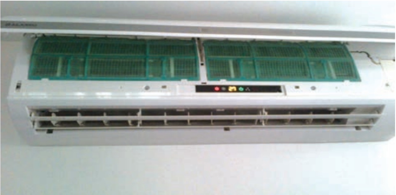
Filtreleri Temizlenmekte Olan Duvar Tipi Klima
