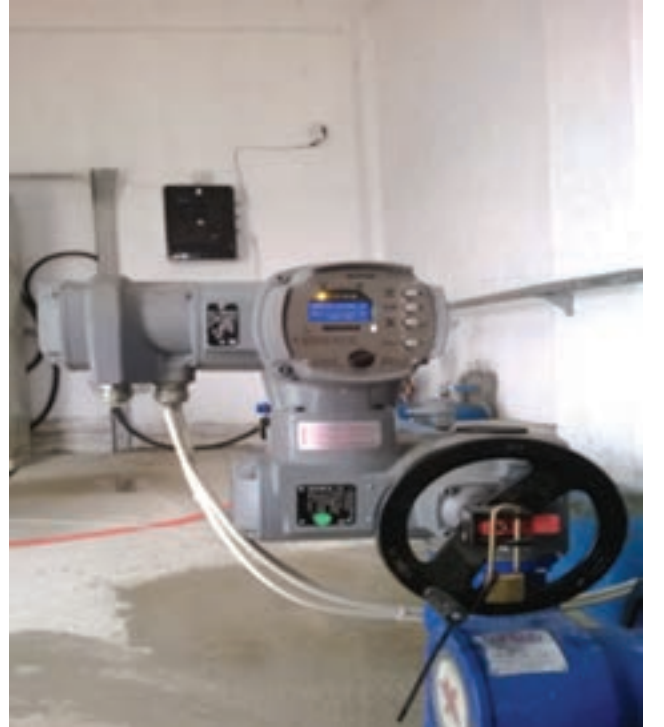
İstasyonlardaki Actuatörlü Giriş-Çıkış Vanaları
