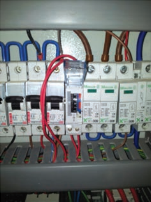
Zaman Ayarlı V Otomat Montajı Yapılmış Pano
