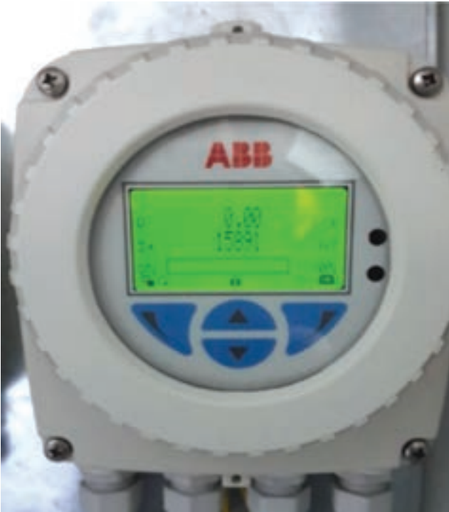
Optukuplör Montaj Sonrasında Debimetre Transmitter Ekran Görüntüleri
