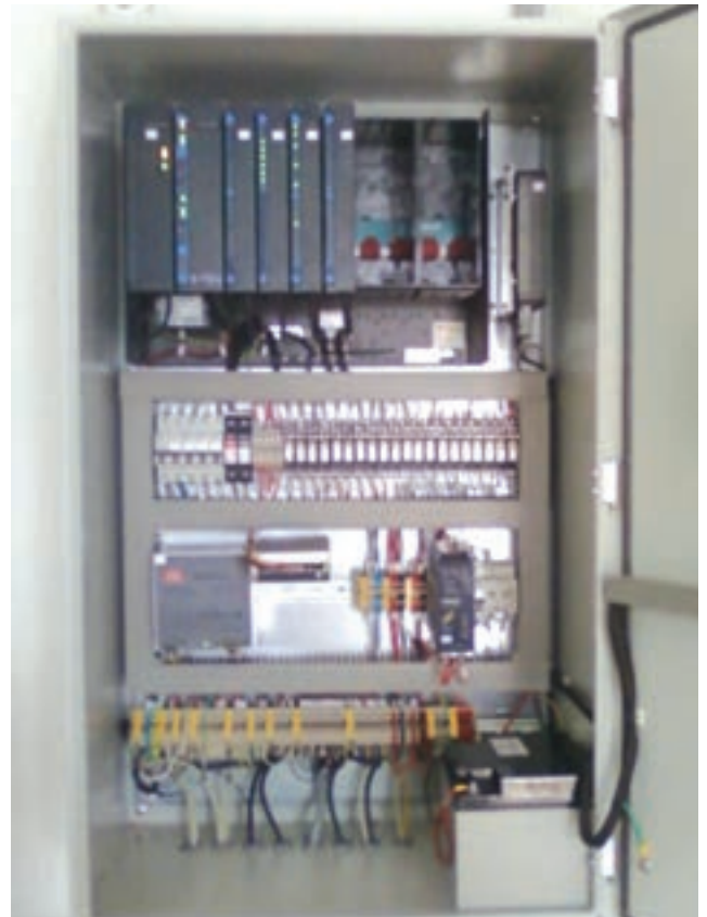
TOKİ Terfi İstasyonu Softstarter ve RTU Panosu
