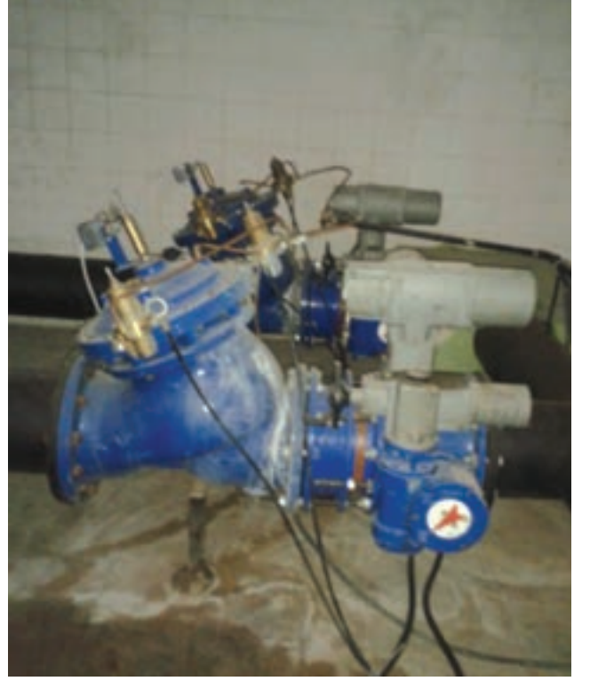
Yazır Pompa İstasyonu Actuatör Takılmış Koç Darbe Vanaları
