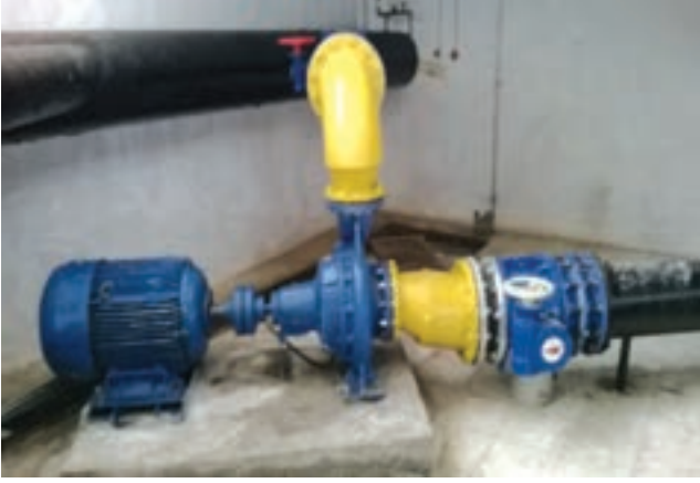
Dedekorkut Pompa İstasyonuna İlave Edilen 5.Motor ve Softstarter
