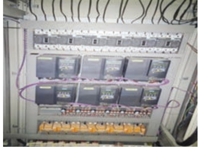
Resim 3. Yoğun çamur pompaları frekans konvertörü
