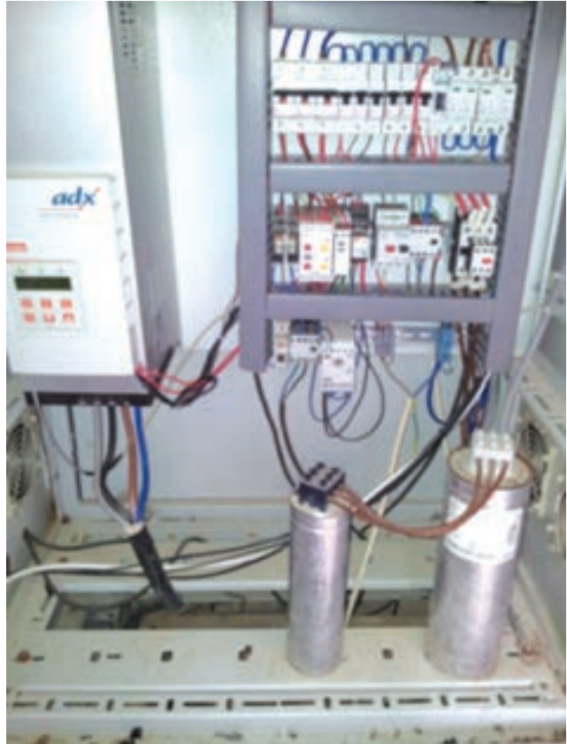
Zaman Ayarlı V Otomat Montajı Yapılmış Pano
