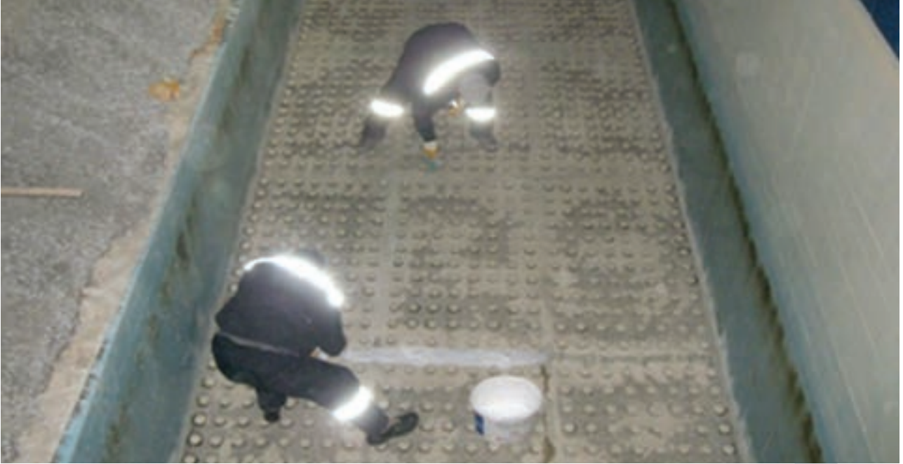
Filtre Ünitesi 4 Nolu Havuz Bakımı
