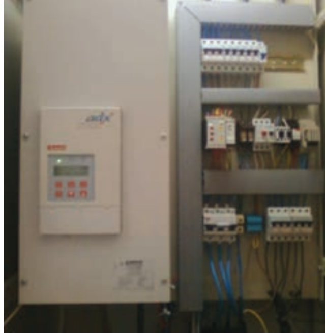
Dedekorkut Pompa İstasyonuna İlave Edilen 5.Motor ve Softstarter
