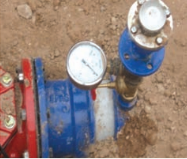
Şebeke hat üzerine basınç kırıcı montaj
