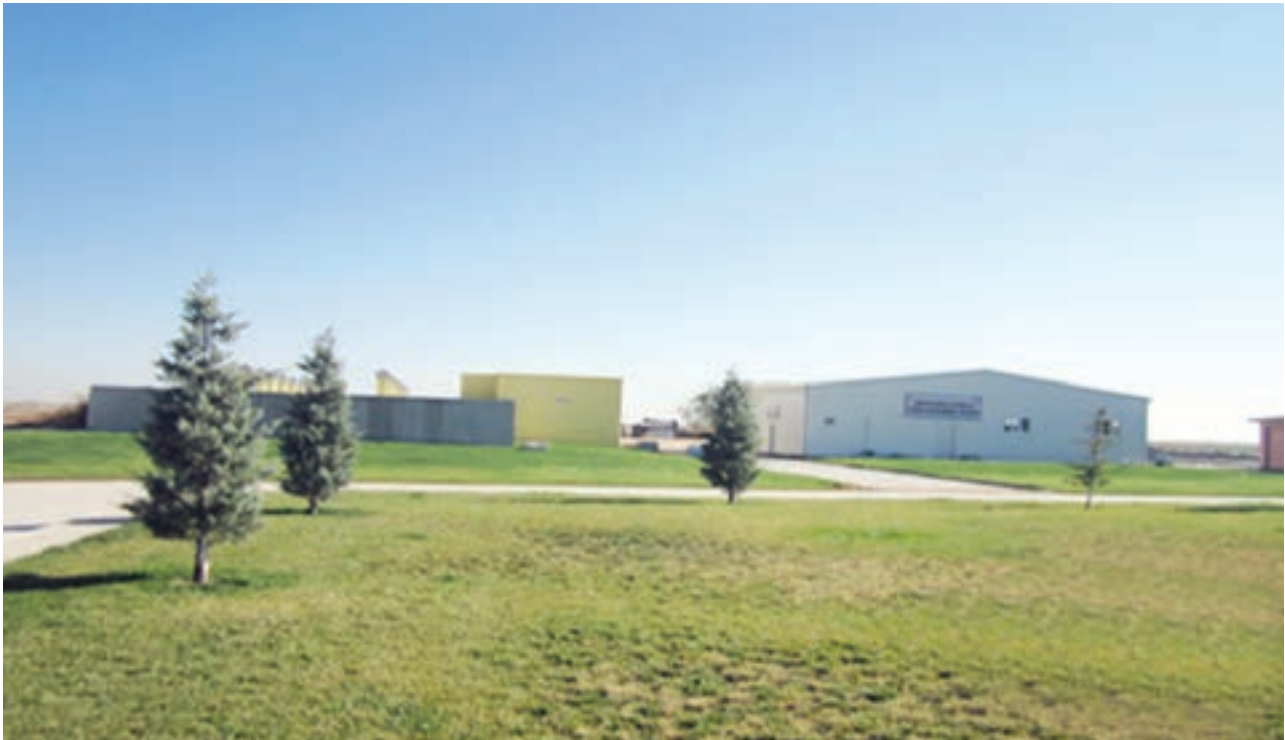
Resim 2. Arıtılmış Atıksu Geri Kazanım Tesisi
