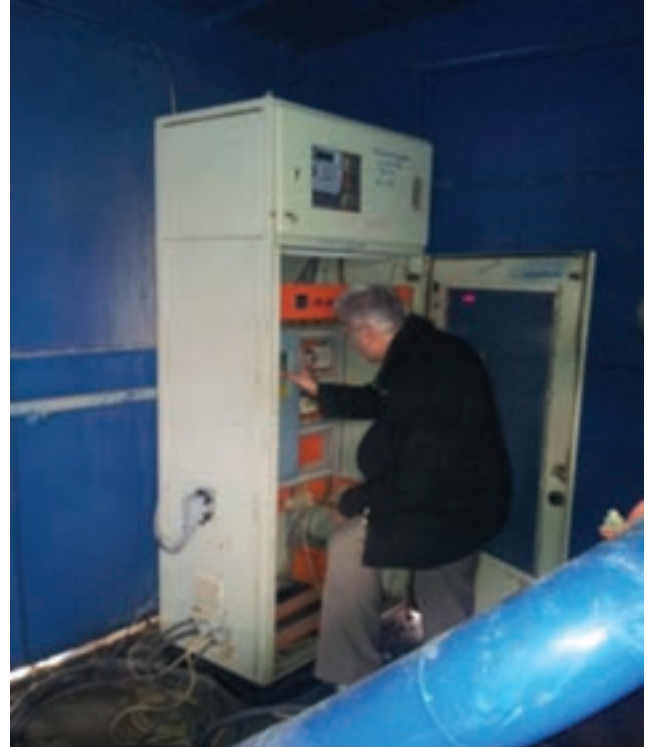
Softstarter ve Frekans Konvertörü
