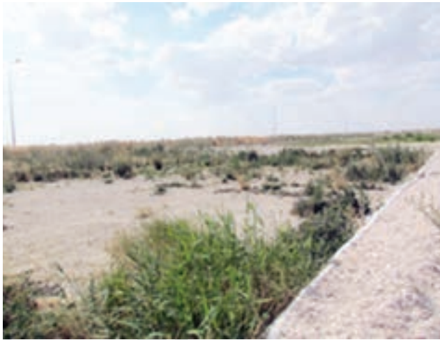
Resim 15. Altnekin AAT (Doğal Arıtma)
