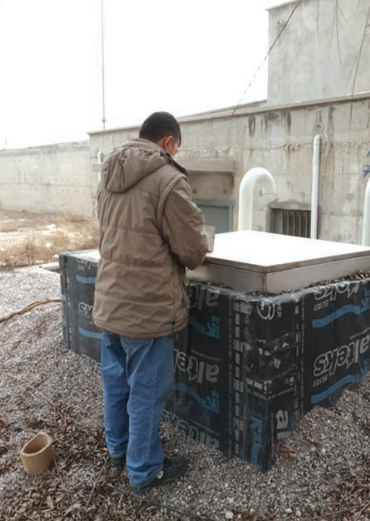
Tamamlanmıř ve Hazır Hale Getirilmıř Debimetre Menhol
