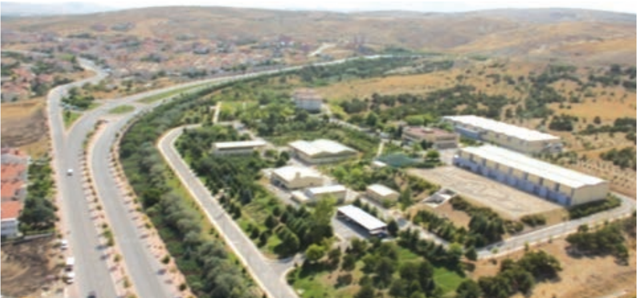
Konya İçme Suyu Arıtma Tesisi
