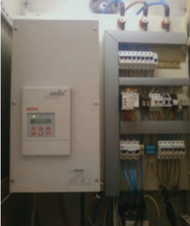
Softstarter ve Frekans Konvertörü
