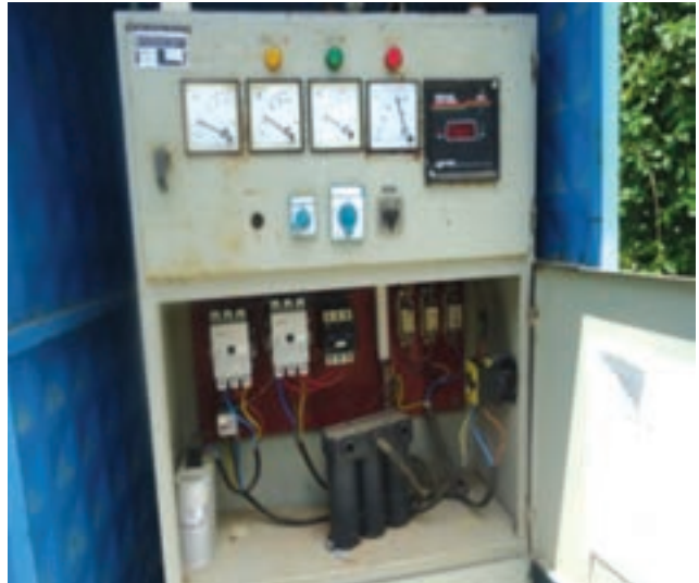
İçme ve kullanma su kuyusunun RST kablo bağlantısı, yeni yol verici pano montajı
