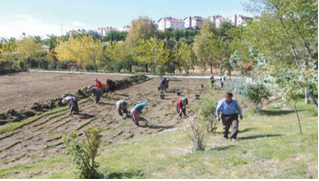
İçme Suyu Arıtma Tesisi çim saha tanzim çalışması
