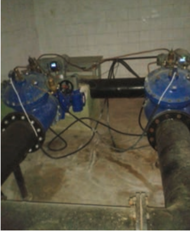
Yazır Pompa İstasyonu Actuatör Takılmış Koç Darbe Vanaları
