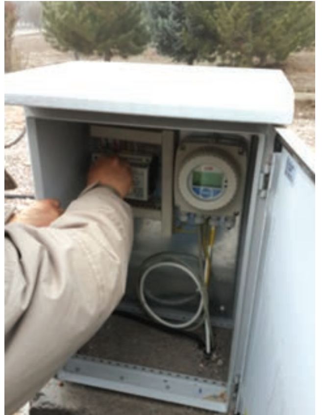
Pompa İstasyonu ve Depo Çıkışları Debimetre Montajı ve Devreye Alınması
