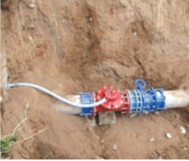
Su deposu girişine seviye kontrol vanası montajı
