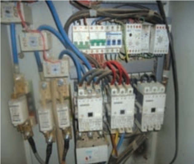
İçme ve kullanma su kuyusunun RST kablo bağlantısı, yeni yol verici pano montajı
