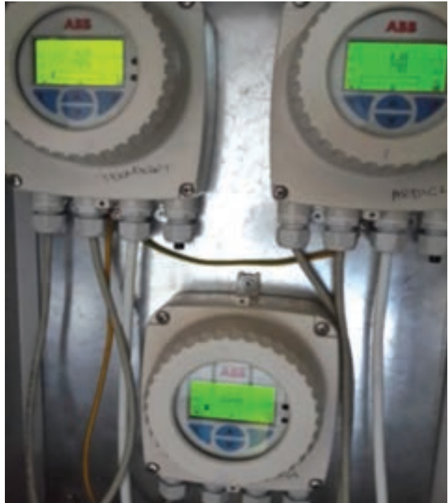
Optukuplör Montaj Sonrasında Debimetre Transmitter Ekran Görüntüleri
