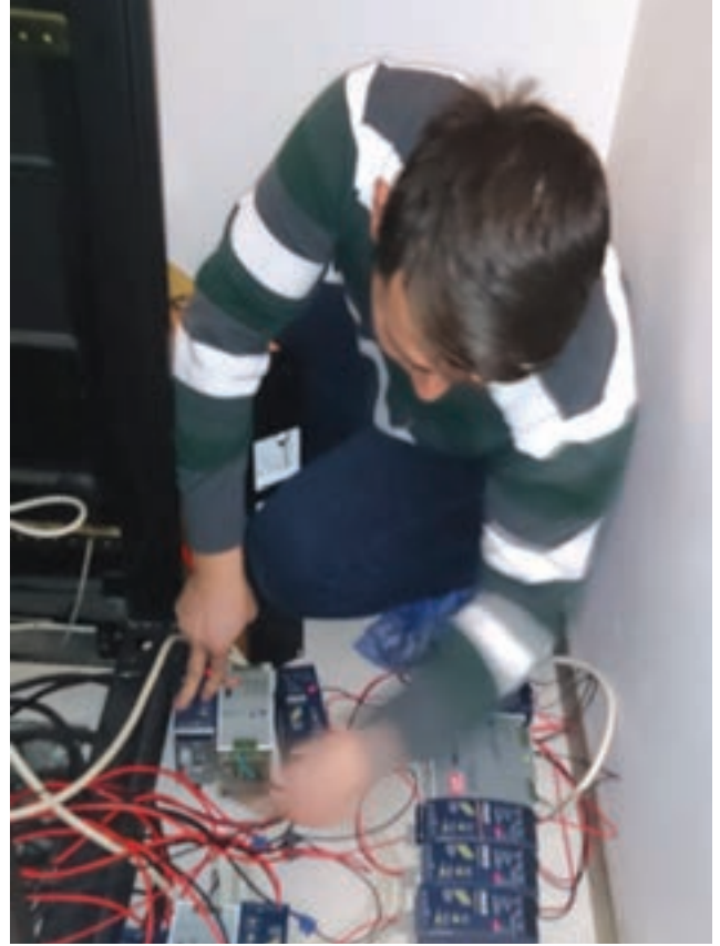
Arızalı Redresörün De Montajı ve Yeni Redresörlerin hazır hale getirilmesi
