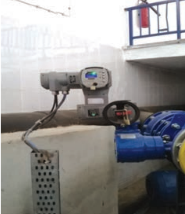
İstasyonlardaki Actuatörlü Giriş-Çıkış Vanaları
