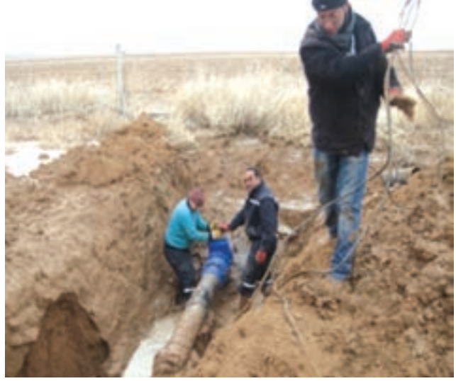
Su deposu girişine seviye kontrol vanası montajı
