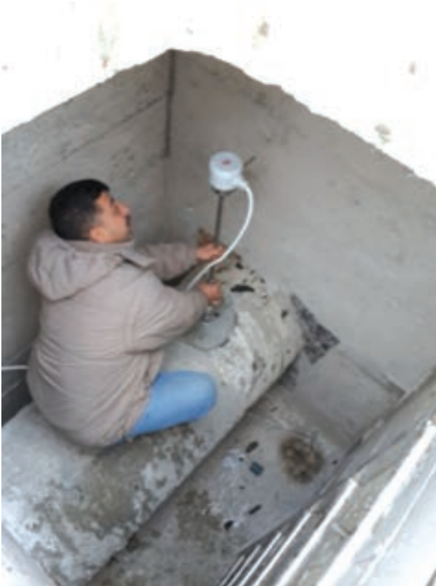
Pompa İstasyonu ve Depo Çıkışları Debimetre Montajı ve Devreye Alınması
