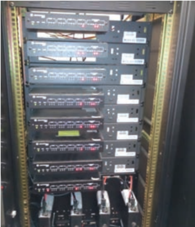
Merkez SCADA Sisteminde Server ve Telsizler
