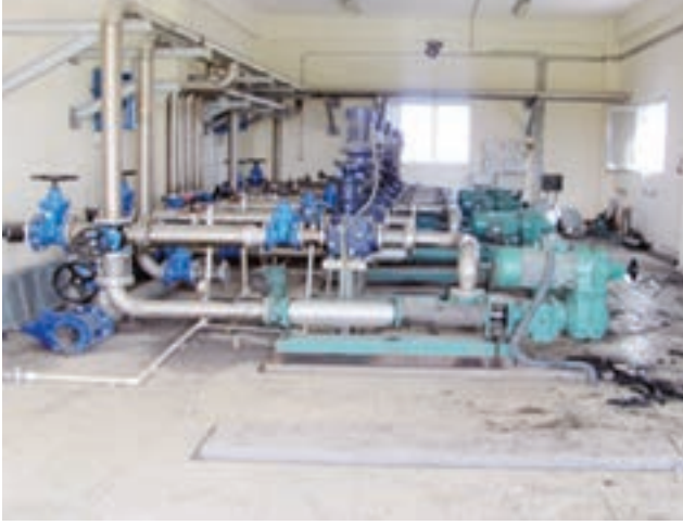
Resim 3. Yoğun çamur pompaları frekans konvertörü
