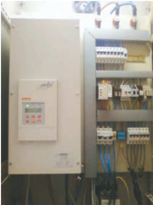
TOKİ Terfi İstasyonu Softstarter ve RTU Panosu
