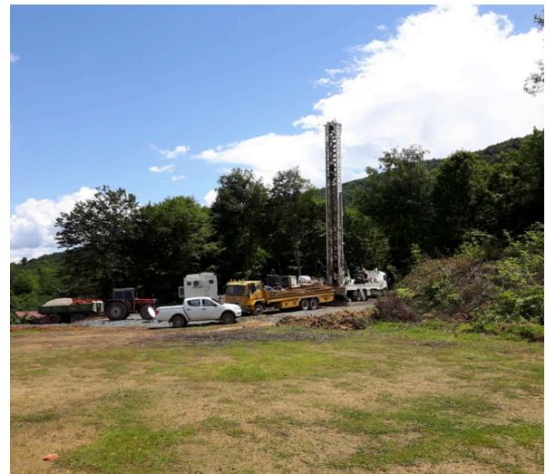
AKY-1 No'lu (Akyazı-Harunusta) Jeotermal Sondaj Kuyusu
