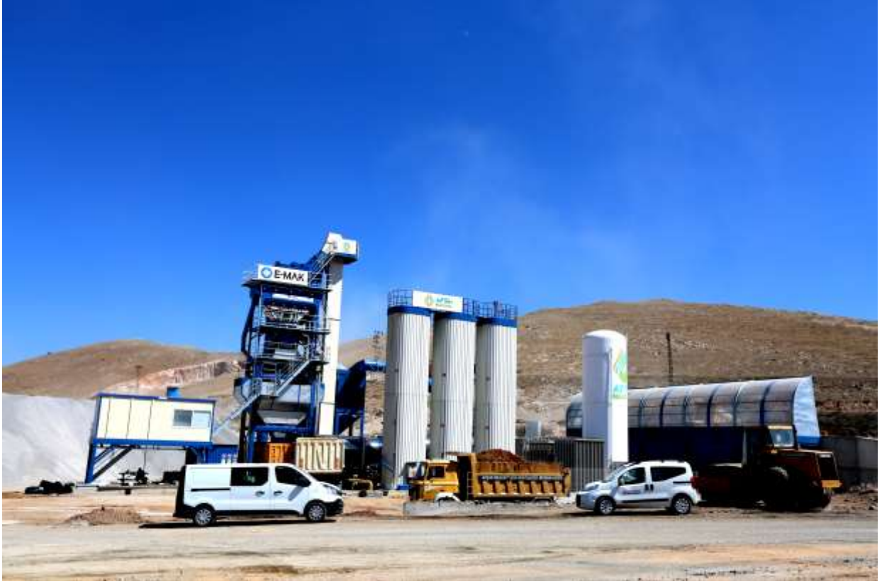
-Afşin'e Kazandırdığımız 160 Ton Üretim Kapasitesine Sahip Asfalt Plenti-
