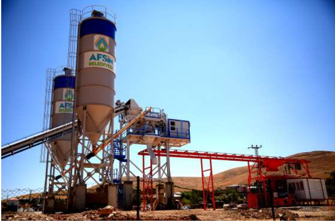
-Afşin'e Kazandırdığımız Beton Elemanları Üretim Tesisi-
