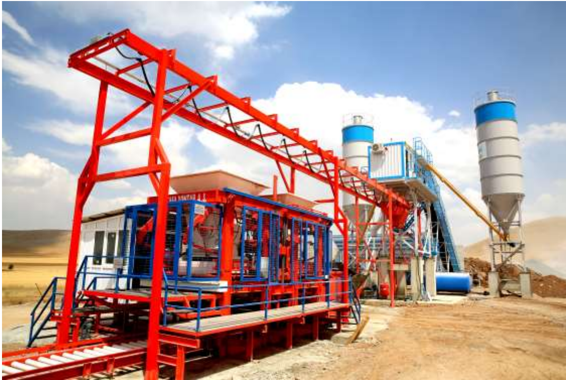
-Afşin'e Kazandırdığımız Beton Elemanları Üretim Tesisi-
