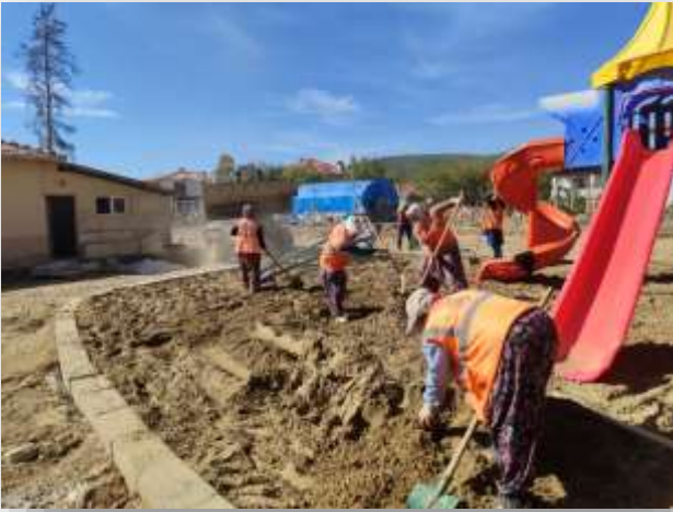
Pınaryazı mahallesi çocuk oyun grubu alanının zeminde mil serim çalışması, güvenlik sınırlarının bordürle çekilmesi işlemleri
