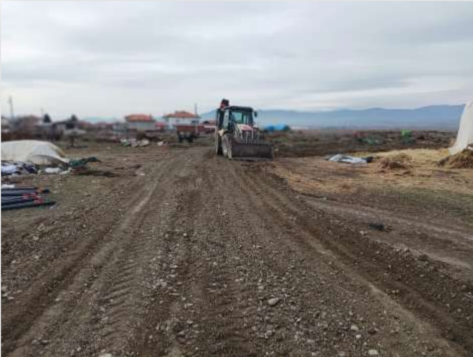
Yol Kumlamaları İçin Güney Mahallesiindeki Belediye Arazisinden Kum Yükleme
