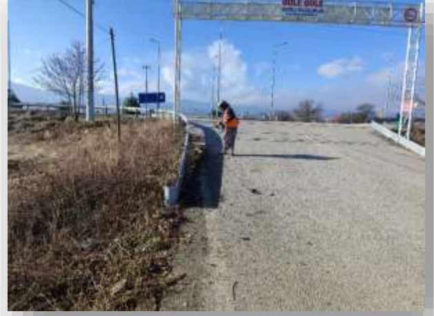
Kırca mahallesi yol temizlik çalışması
