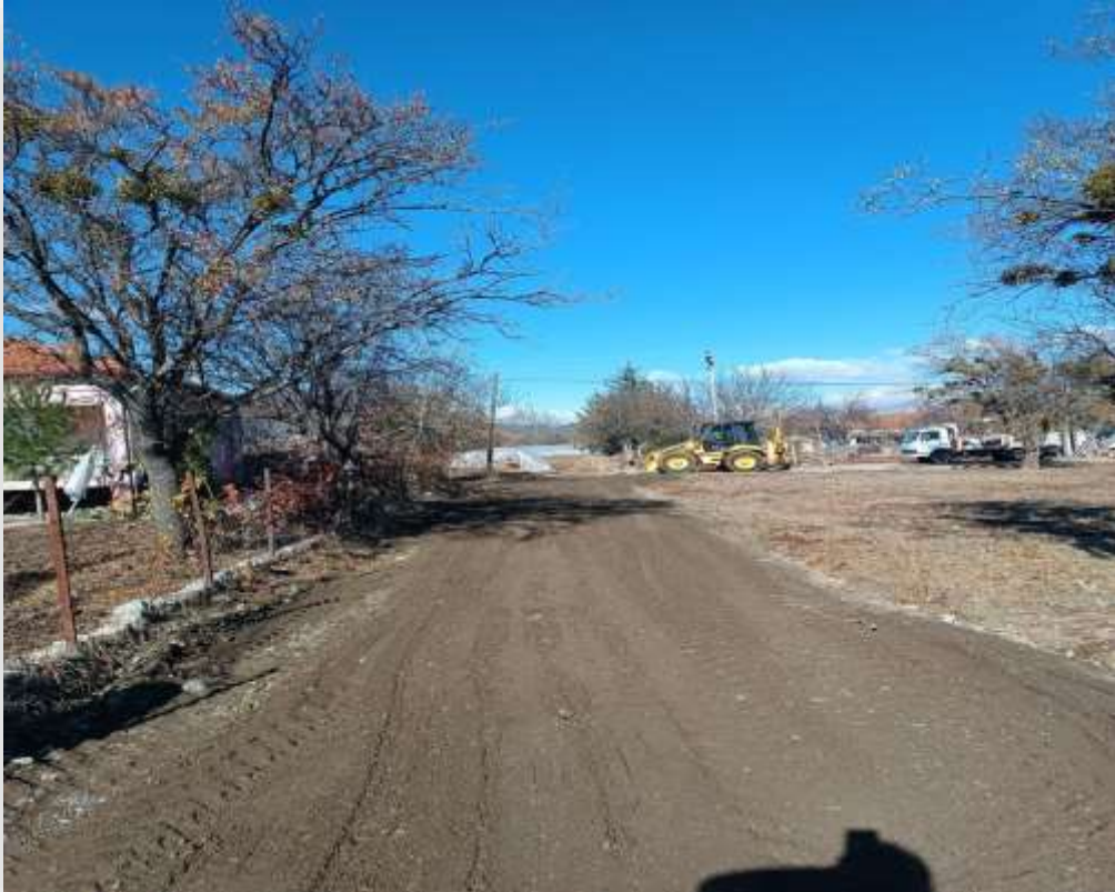
Oğuz Mahallesi İmar Yolu Açılması
