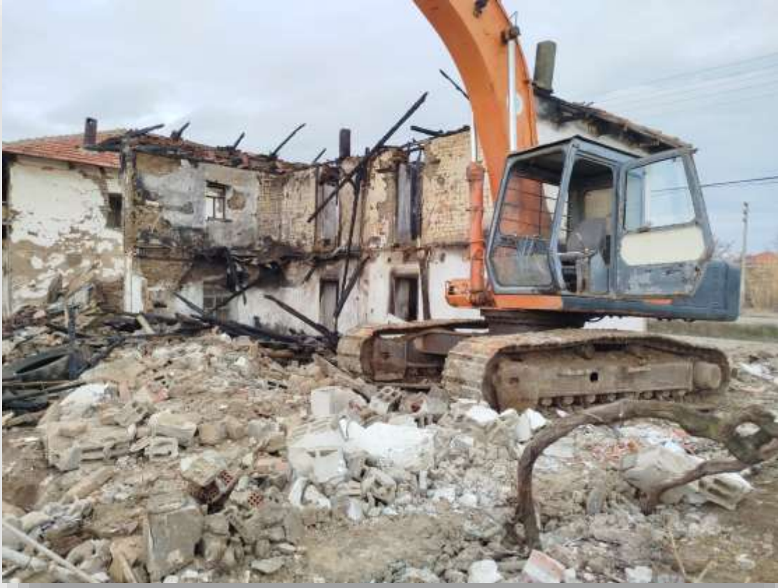
Yassihöyük Mahallesi Deprem Hasarlı Evlerin Yıkımı
