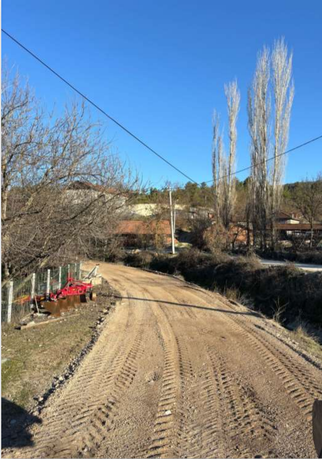
Akşar Mahallesi Yol Kumlama Çalışmaları
