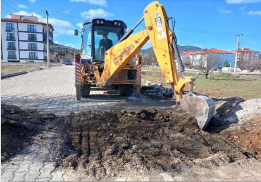
Sandalcık Mahallesi Taş Döşenmesi
