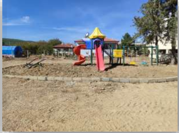
Pınaryazı mahallesi çocuk oyun grubu alanının zeminde mil serim çalışması, güvenlik sınırlarının bordürle çekilmesi işlemleri
