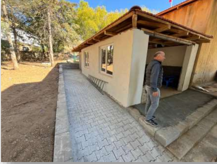
Corum Mahallesi Sosyal Tesis Mutfak ve Tuvaleti
