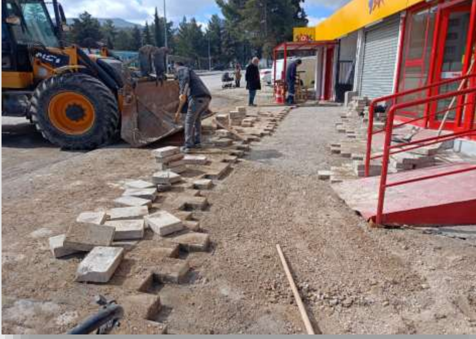
Çamlık Mahallesi Taş Döşenmesi
