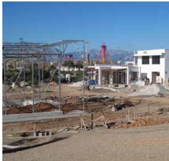
Güneş Evi İnşaatı
