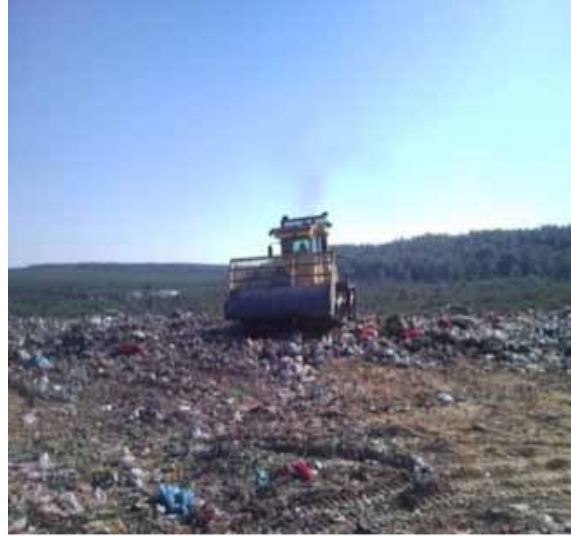
Kompaktör ile Atığın sıkıştırılması işi
