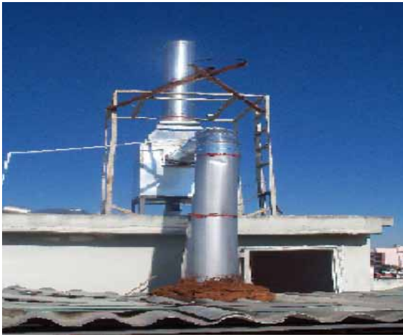
Tüketim Noktalarında Baca Gazı Arıtma Sistemi Montaj Faaliyetleri
