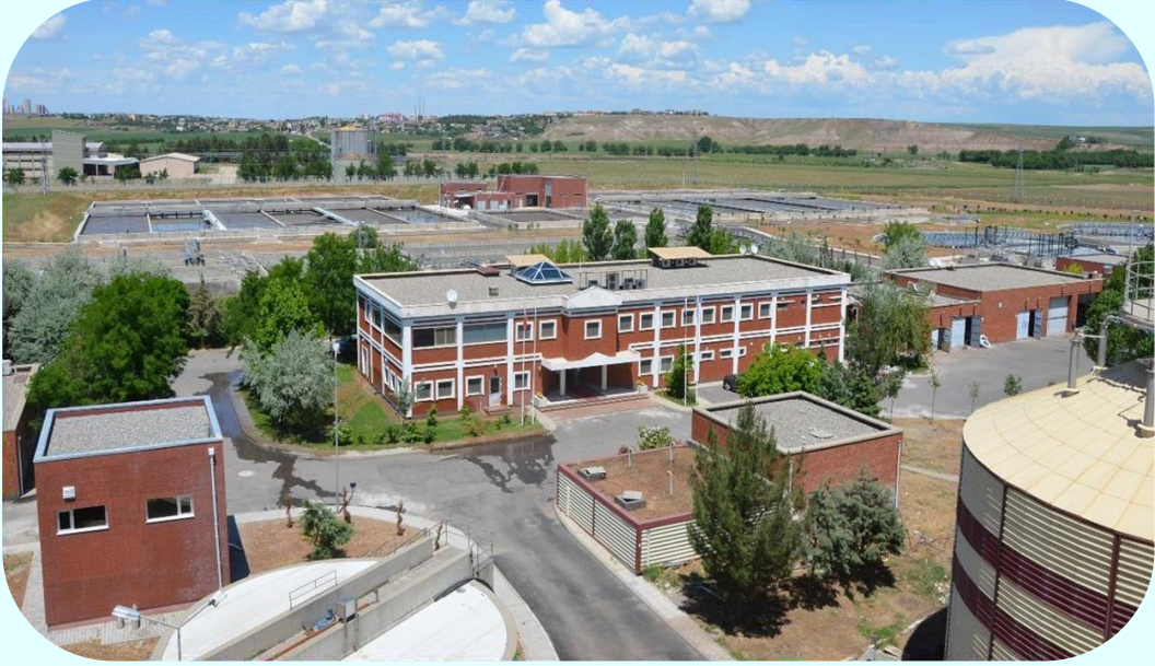
İleri Biyolojik Atık Su Arıtma Tesisi
