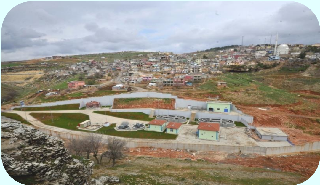
Eğil Biyolojik Atık Su Arıtma Tesisi
