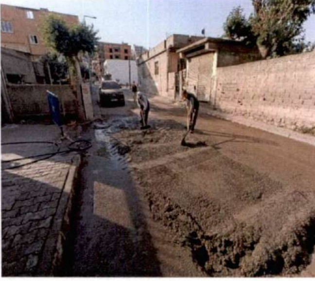
3-Hazır Beton Yama Çalışması: 745 m 2
