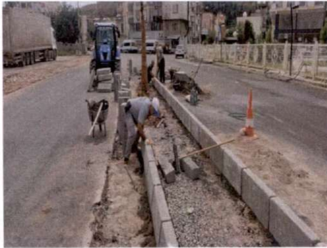
4-Orta Refüj Bordür Taşı Döşemesi Çalışması
