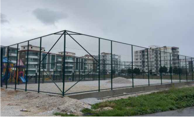
7 Eylül Mahallesi- Halı Saha Yapım Çalışmaları
