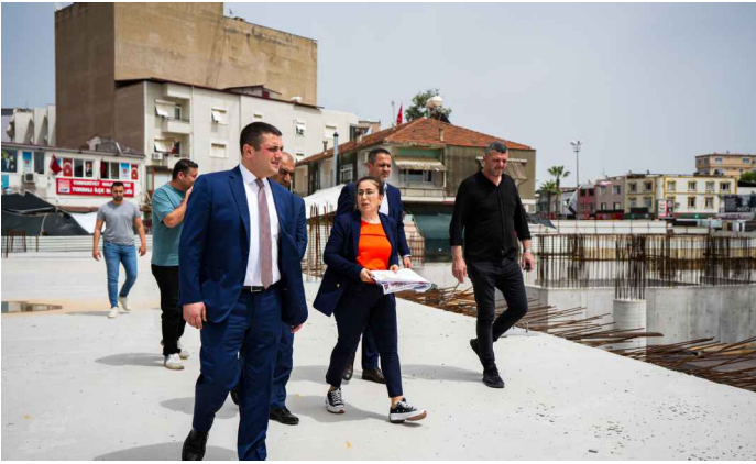
Devam etmekte olan Belediye Meydan Projesi kapsamında yerinde denetim ve incelemeler yapıldı.
