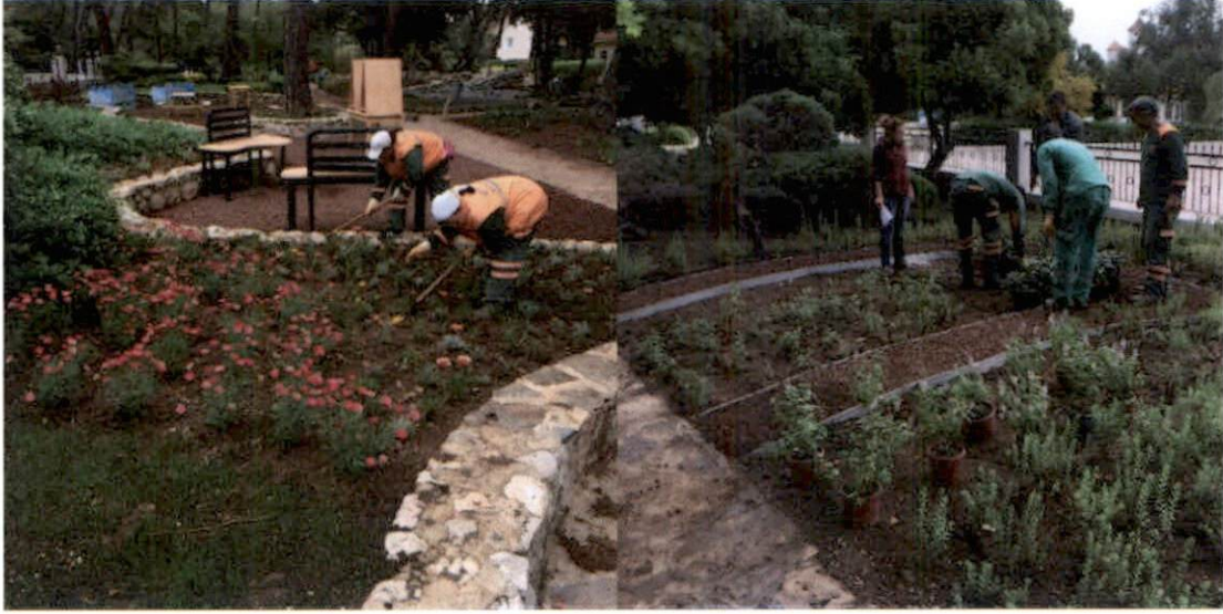
Revizyon çalışmaları / Bilimsel dış mekan ürünleri montajı
