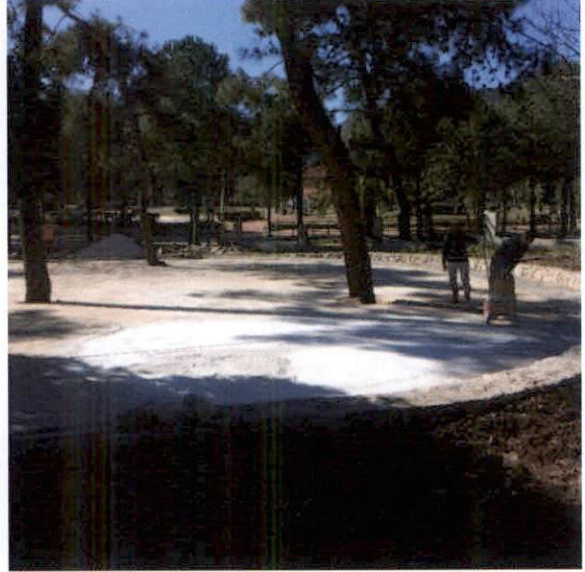
Revizyon çalışmaları / Peyzaj Projesine uygun beton dökümü ve silme uygulaması
