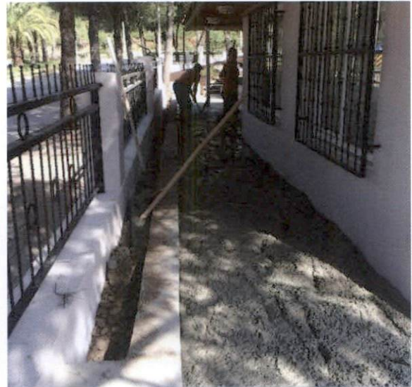
Revizyon çalışmaları / Peyzaj Projesine uygun beton dökümü ve yama çalışmaları
