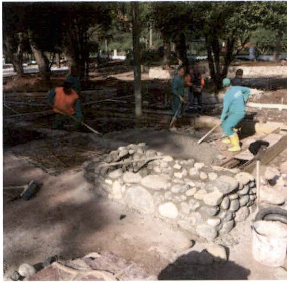
Revizyon çalışmaları / Peyzaj Projesine uygun beton dökümü ve silme uygulaması
