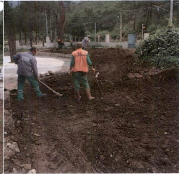
Revizyon çalışmaları / Doğal kaya yerleştirme, toprak nakli ve arazi biçimlendirme
