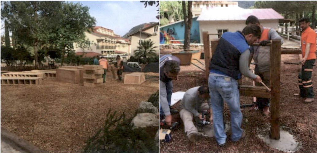
Revizyon çalışmaları / Ahşap ürünlerin yerleştirilmesi ve montajı
