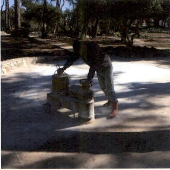
Revizyon çalışmaları / Peyzaj Projesine uygun beton dökümü ve silme uygulaması
