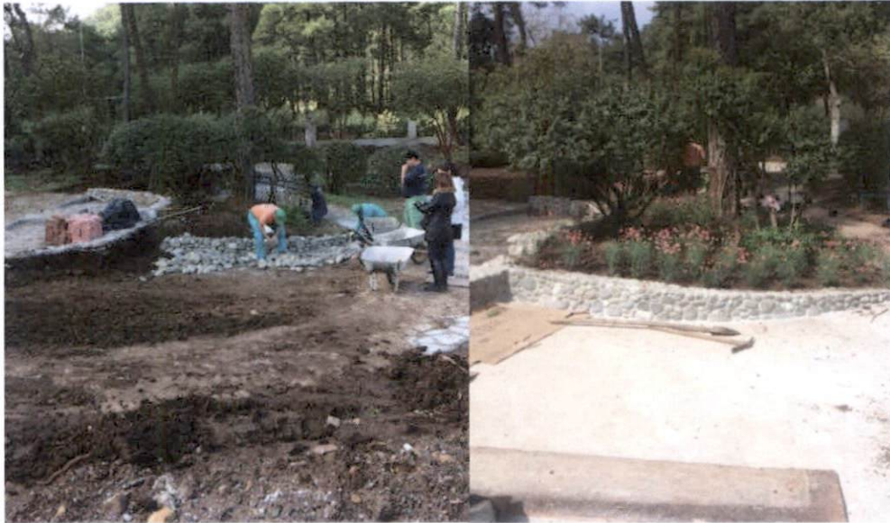
Revizyon çalışmaları / Duvar Yapımı
