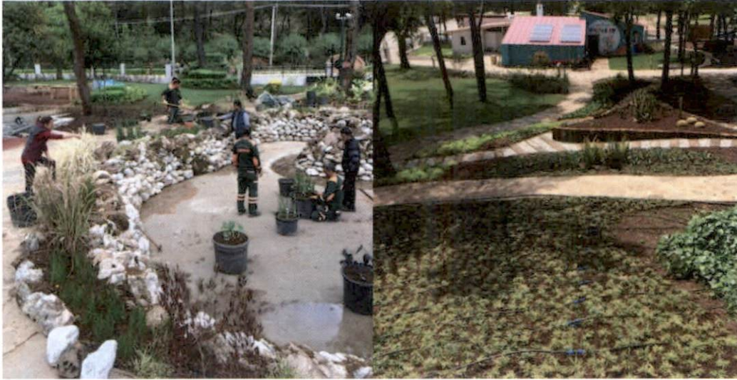
Revizyon çalışmaları / Bina cephe boyama, bina cephe tasarım çalışmaları, bahçe tabelaları tasarım ve montajı, bitkilendirme
