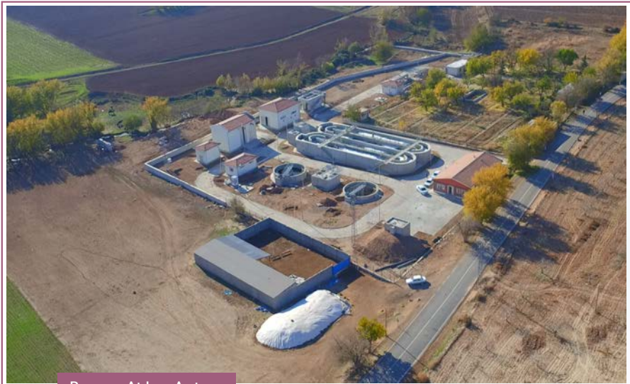
Bozova Atıksu Arıtma
