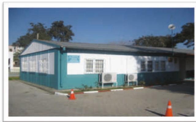
Resim 1. TASKİ Kanalizasyon ve Drenaj İşleri Yöneticiliği
