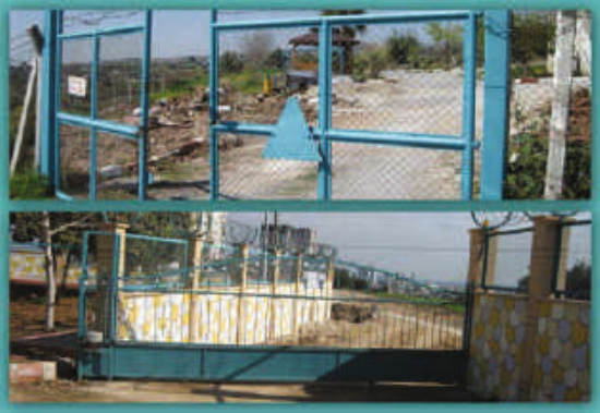
Resim:20 DY3 İçme Su Deposu Otomatik Ferforce Kapı( Önce-Sonra)
