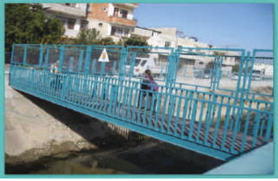
Resim:24 Yeni Mahalle yaya geçiş köprüsü
