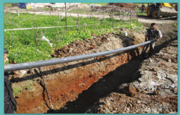
Resim:9 – Pvc İçme Suyu Borusu Döşenmesi Resim No: 10 – Pvc İçme Suyu Borusu Döşenmesi
