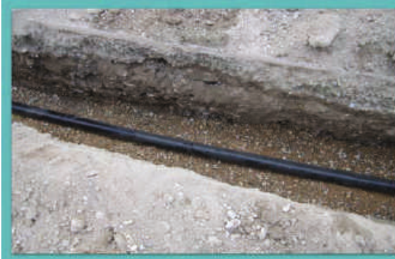
Resim:9 – Pvc İçme Suyu Borusu Döşenmesi Resim No: 10 – Pvc İçme Suyu Borusu Döşenmesi
