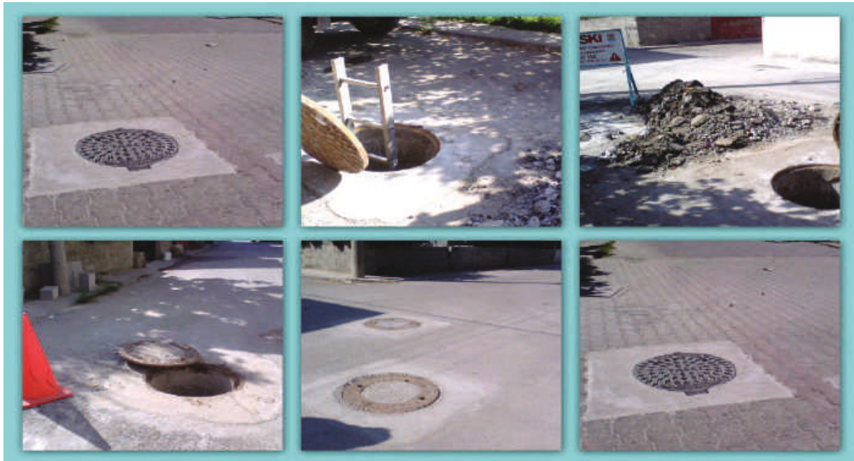
Resim 4. Kanalizasyon Baca Kapaklarının Yükseltilmesi ve Yenilenmesi
