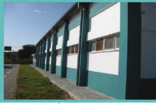
Resim:23 Pompa İstasyonundan Görünüm
