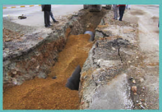
Resim:7 Ø 900 Duktıl İçme Suyu Hattı Döşenmesi Resim:8 Ø 900 Duktıl İçme Suyu Hattı Döşenmesi
