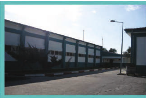
Resim:21 Alo Pompa İstasyonu
