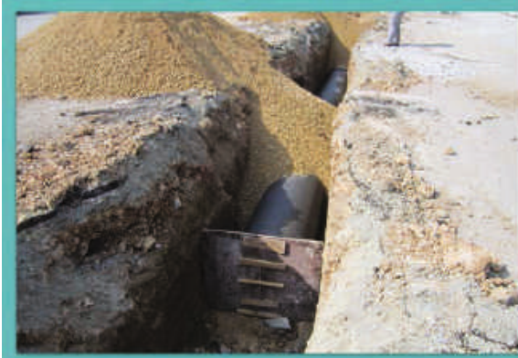
Resim:7 Ø 900 Duktıl İçme Suyu Hattı Döşenmesi Resim:8 Ø 900 Duktıl İçme Suyu Hattı Döşenmesi
