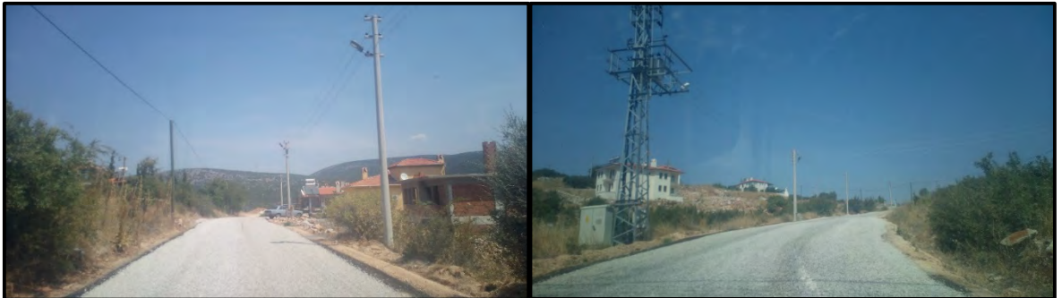
Asfalt Sathi Kaplama İşi (8.161 M2)
