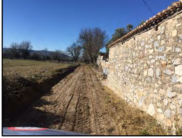
Yol Tesviye Çalışmaları Yapıldı
