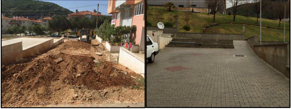
Kapalı Havuz Önü Merdiven Çalışmaları Yapıldı
