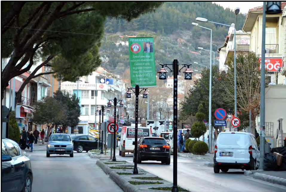
İsmet İnönü Cad. Kaldırım Düzenleme ve Aydınlatma Çalışmaları Yapıldı
