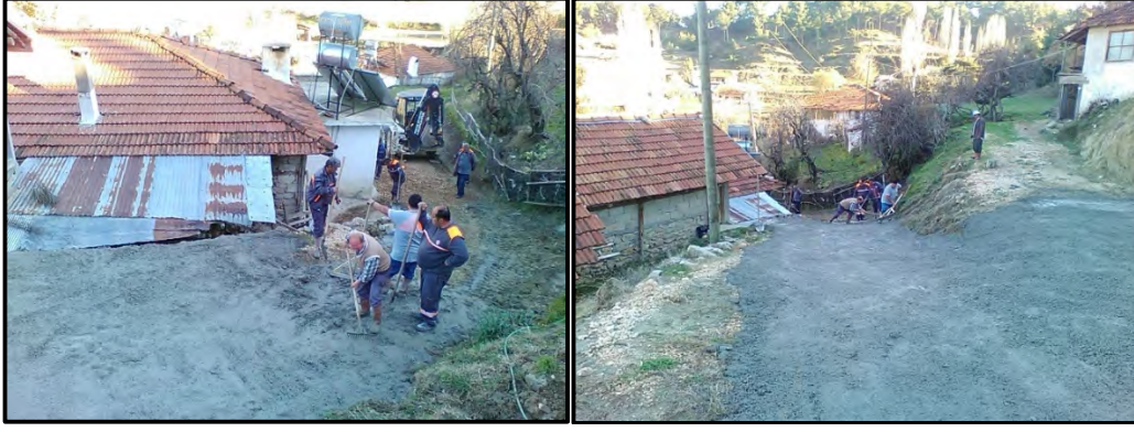
40 Mt Uzunluğunda Ulaşım Açık Olmayan Yol, Açılıp Kaplanarak Vatandaşların Hizmetine Sunulmuştur
