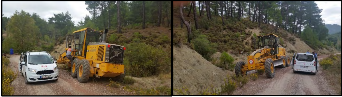
Greyder İle Yol Tesviye Çalışmaları Yapılmıştır
