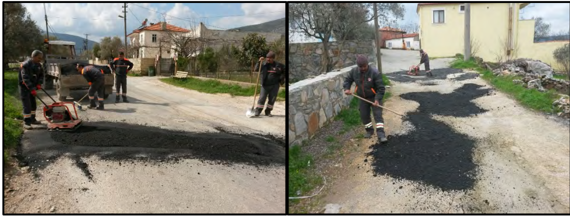
Rodmiks İle Yol Bakım, Onarım ve Tamirat Çalışmaları Yapıldı
