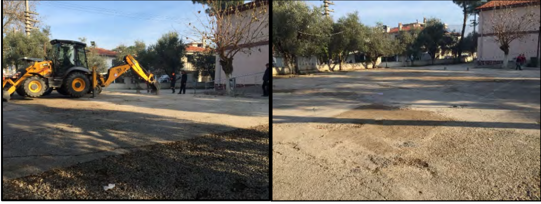
Yeşilyurt Ortaokulu basketbol Saha düzenlemesi, pota yerleştirme ve Beton Döküm İşi Yapıldı
