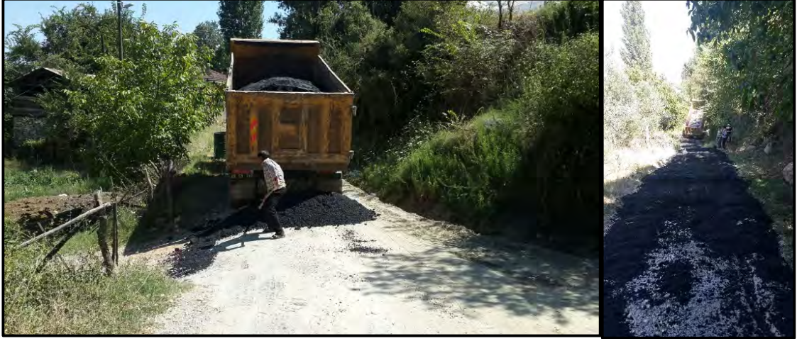
Rodmiks İle Yol Bakım, Onarım ve Tamirat Çalışmaları Yapıldı
