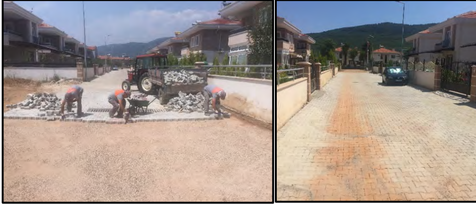
Ortaköy Parke Yol Kaplama ve Izgara Su Drenaj Çalışmaları Yapıldı
