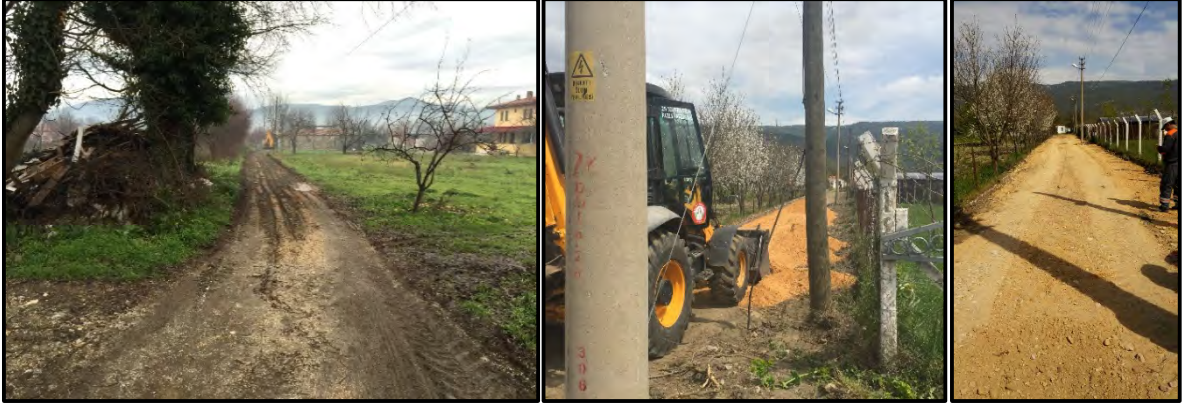
Yol Çakıllama İşleri Yapıldı
