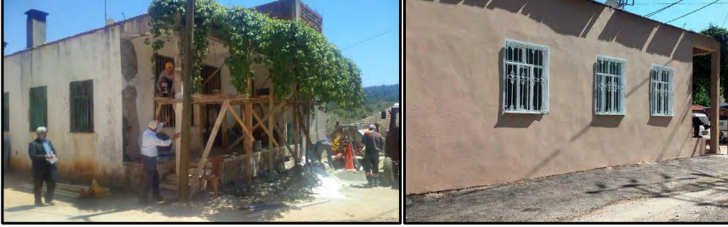
Köy Kahvesi Sıva ve Boya İşleri Yapıldı
