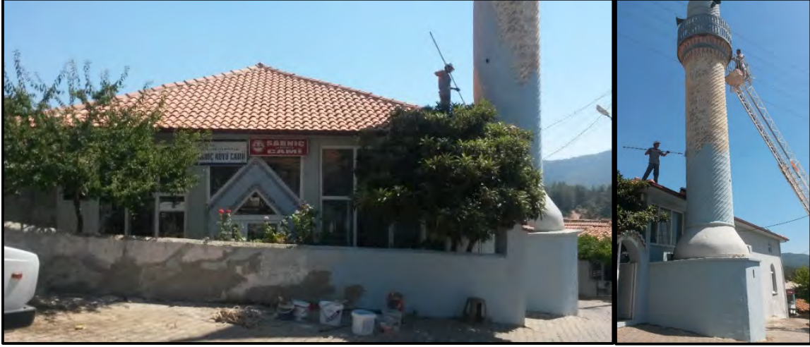
Cami Boya İşleri Yapıldı
