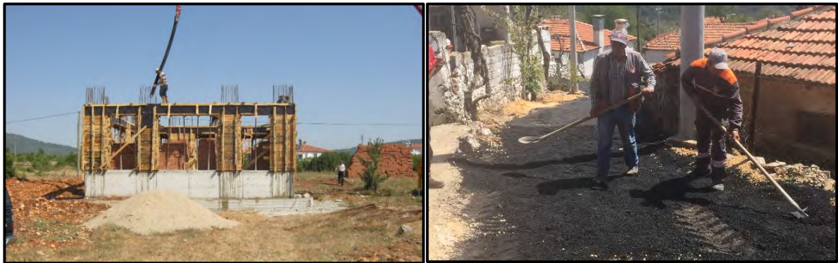
Cami Cami Yolu Yapıldı, Bahçe Düzenlemesi, Rotmiks İle Yol Kaplama Çalışmaları Yapıldı ve Beton İşleri Yapıldı
