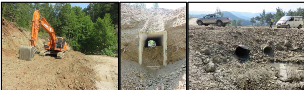
Kutu Menfez ve Drenaj Boruları Yerleřtirilerek Yol Geniřletildi.
