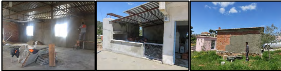
Düğün Salonu Sıva Boya Bakım Onarımı Yapıldı
