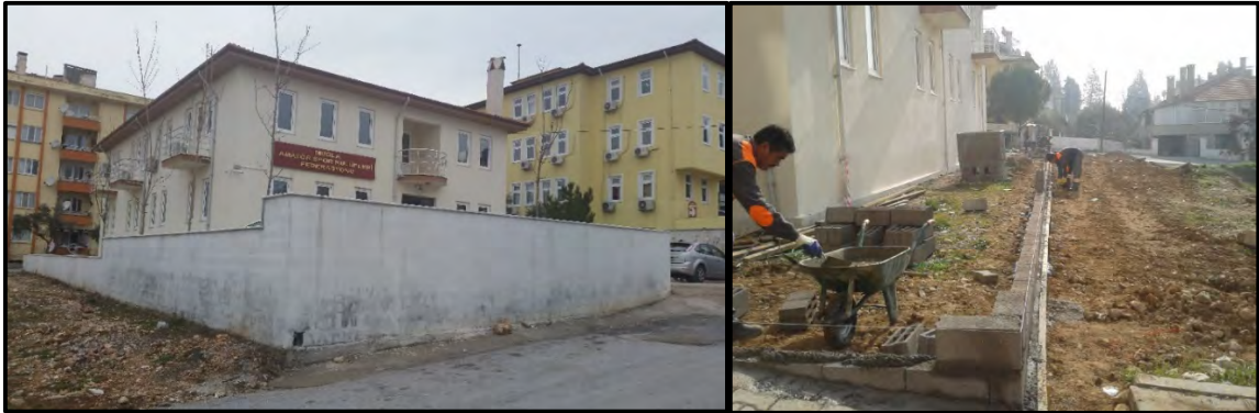
Amatör Spor Klüpleri Federasyonu Çevre Düzenlemesi ve Duvar Yapımı
