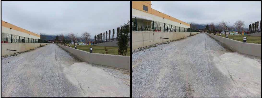
Menteşe Bilim Parkı Yanı Servis Yolu Sıcak Asfalt Çalışmaları Yapıldı
