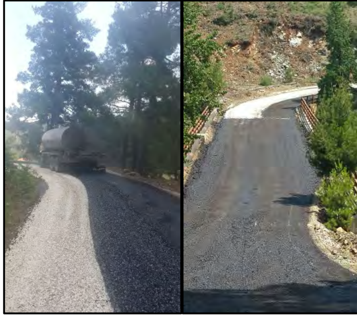
Stablize Yolun Asfalt Kaplanması Yapıldı (4.089 M2).
