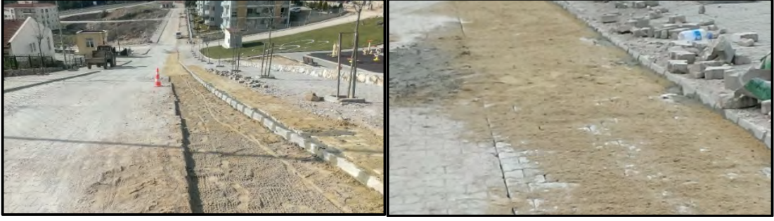
42., 11. ve 9. Sokaklarda Yol ve Kaldırım Düzenleme İşleri Yapıldı
