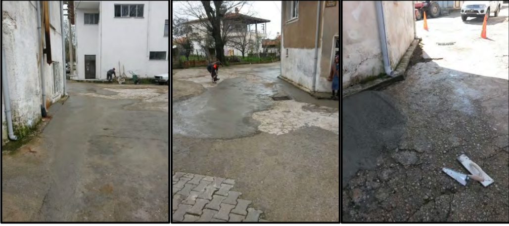
Beton Yol Tamirat Yapıldı
