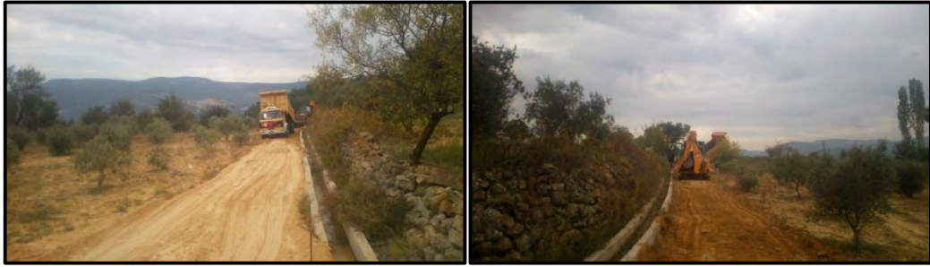
Yol Tesviye ve Çakıllama İşleri Yapıldı
