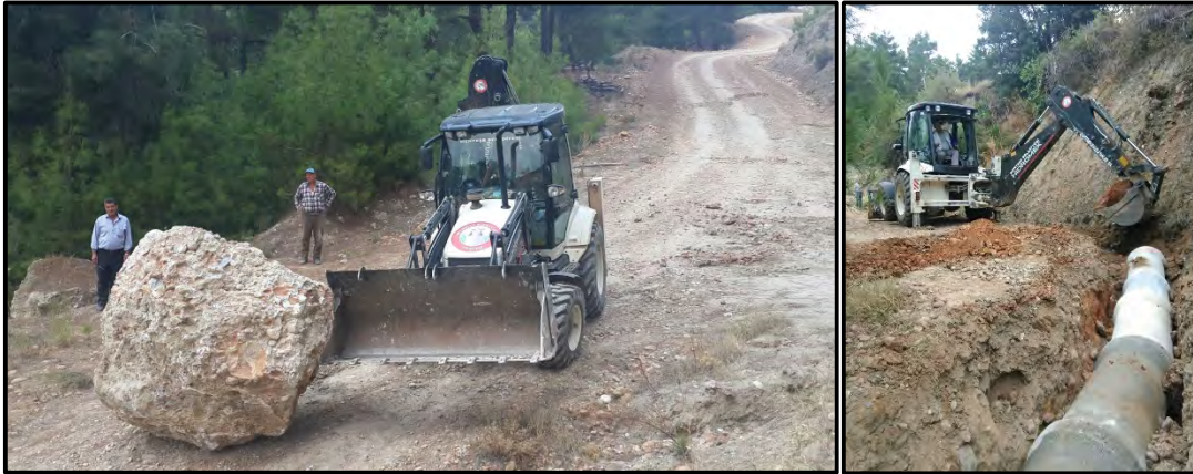
İş Makinaları İle Yol Çalışmaları
