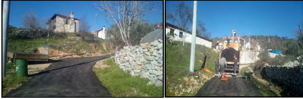
Rodmiks İle Yol Kaplama Çalışmaları
