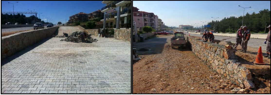
12. Sokakta Taş duvar Örüldü
