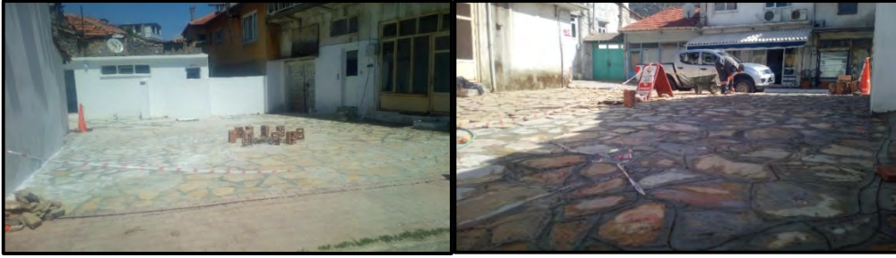
Kayrak Taşı Döşeme İşi
