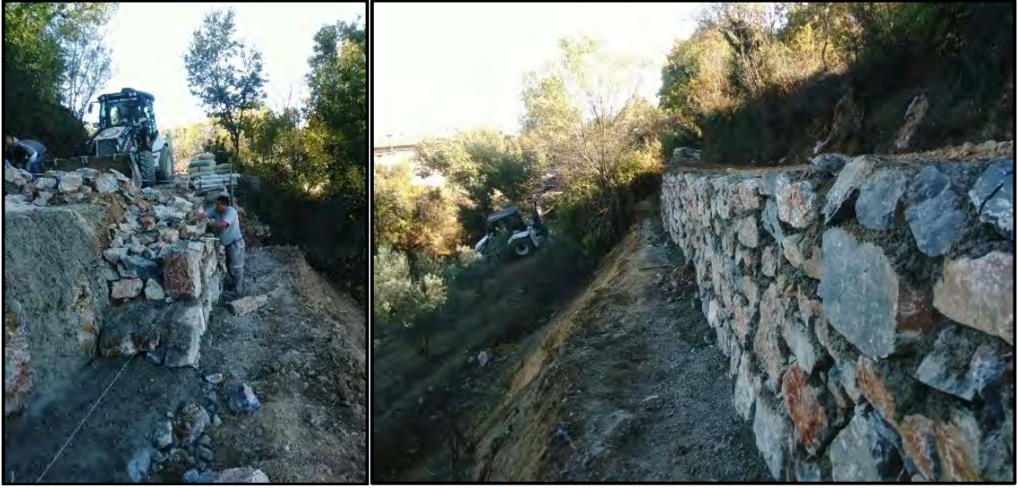
Heyelan Meydana Gelen Yolda 25mt Uzunluğunda İstinat Duvarı Yapılarak Ulaşımın Açılmıştır
