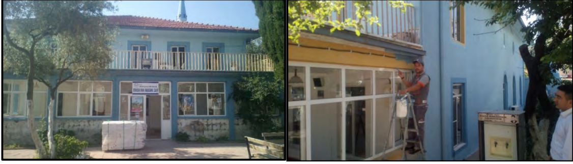
Menteşe Cami Duvar Tamirat ve Sıva Çalışmaları
