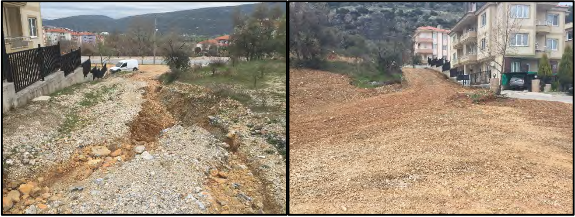
Menteşe Merkez Polis Kademesi Altı Yol Tesviye İşi
