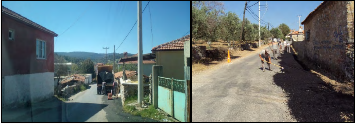
Rodmiks İle Yol Bakım, Onarım ve Tamirat Çalışmaları Yapıldı
