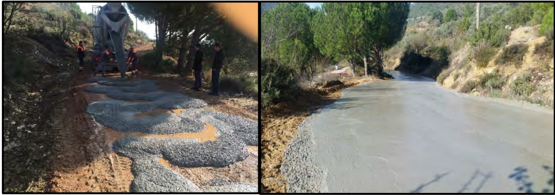
Kafaca Beton Yol Kaplama
