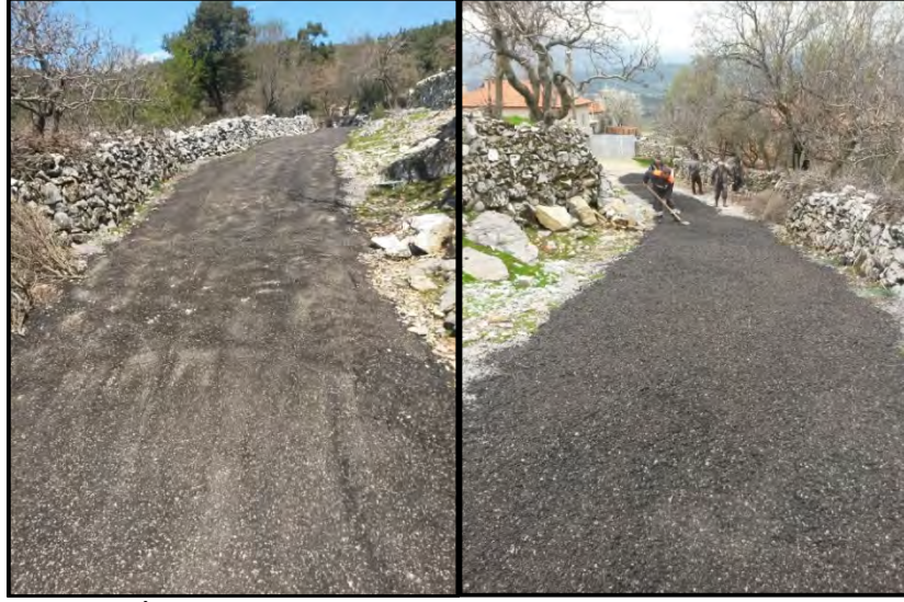
Rodmiks İle Yol Bakım, Onarım ve Tamirat Çalışmaları Yapıldı
