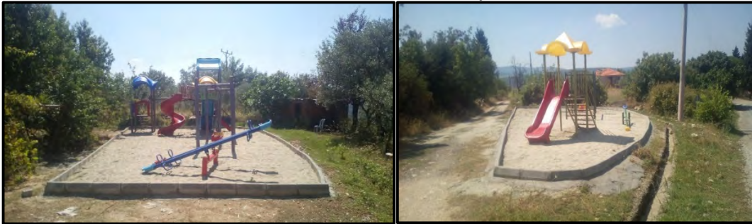
Oyun Grubu Montajı ve Etrafı Bordür Çekimi Yapıldı
