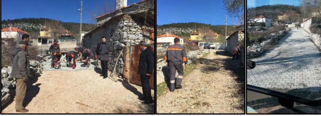
Parke Yol Yapım alıřmaları Yapılmıřtır
