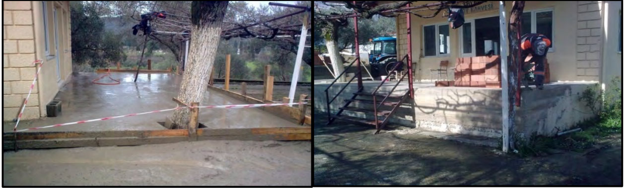
Köy Kahvesi Balkon Yapımı Sıva ve Bakım İşleri
