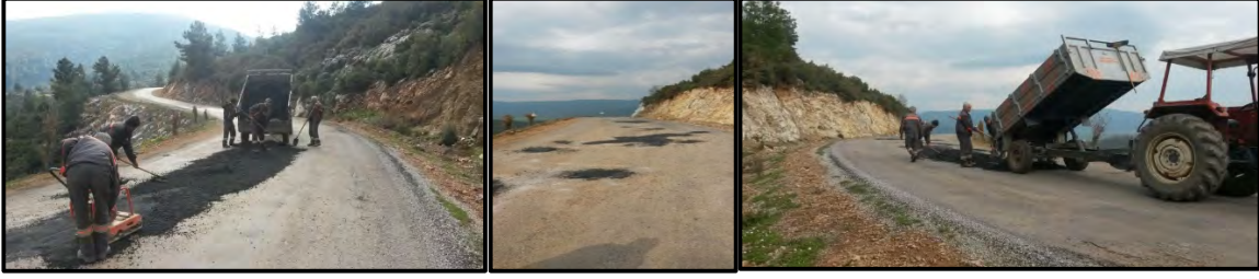
Kafaca-çifık Yolu Rodmiks İle Yol Bakım, Onarım ve Tamirat Çalışmaları Yapıldı
