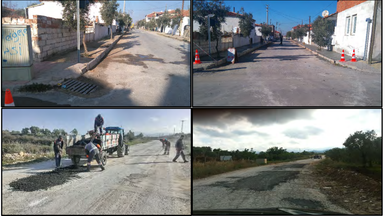
Rotmiks İle Yol Bakım Onarım ve Tamirat İşleri Yapıldı
