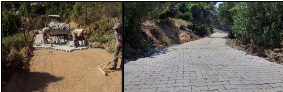
Mezarlık Yolu Parke Döşendi
