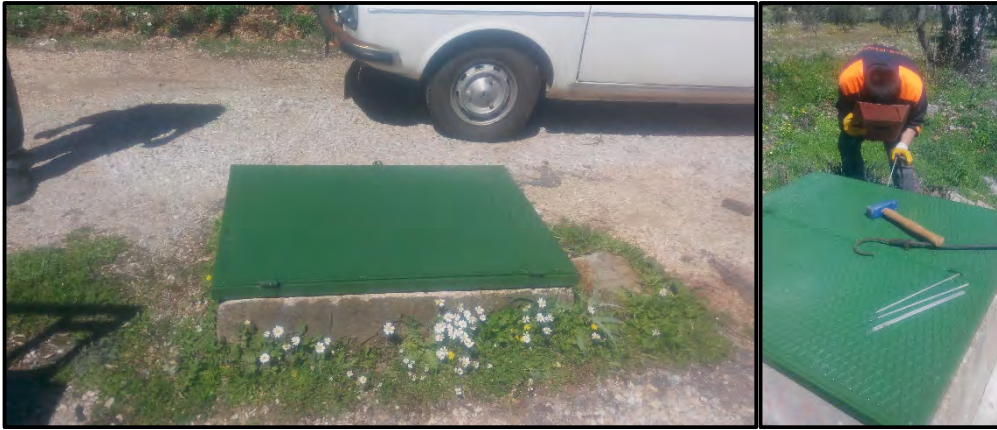
Yol İçi Açık Kuyu Kapaklarının Montajı Yapıldı
