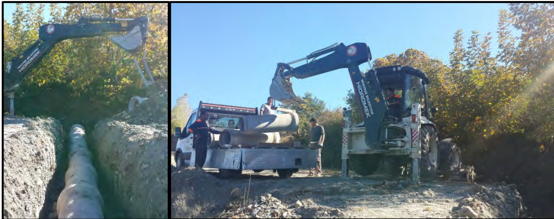
İş Makinası İle Büz Yerleştirme ve Yol Çakıllama İşi Yapıldı
