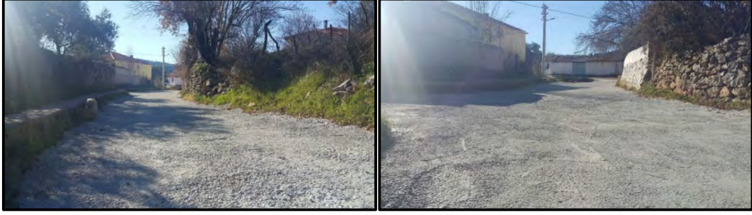
Beton Yol Kaplama İşleri Yapıldı
