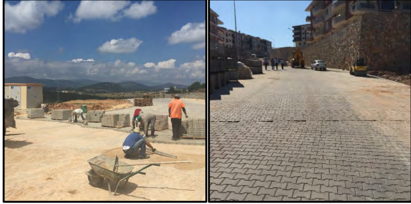
16. Sokakta Parke Yapım İşi
