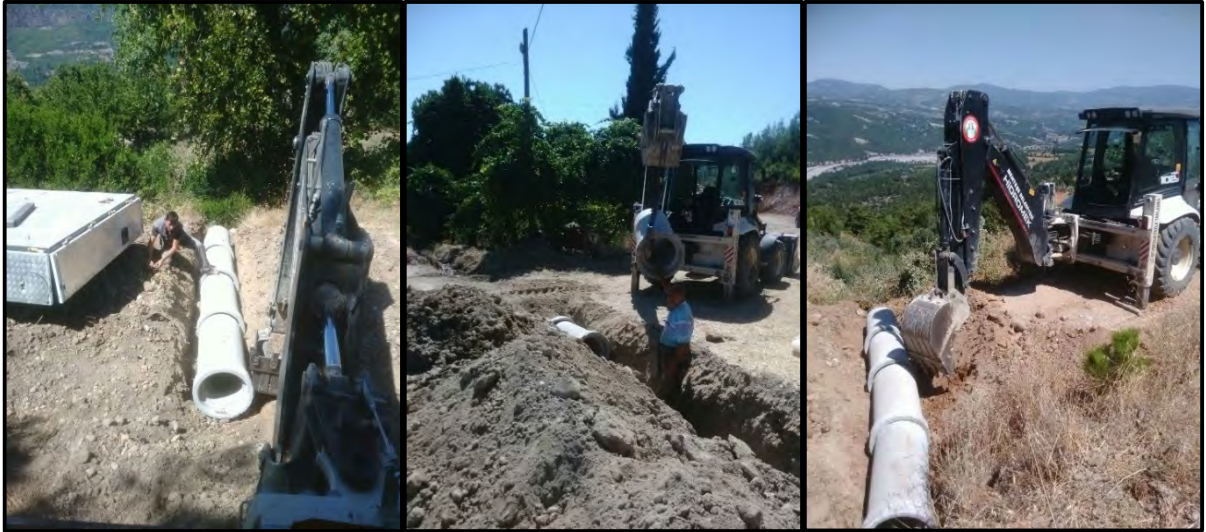
Yağmur Suları İçin Beton Büz Yerleştirildi.
