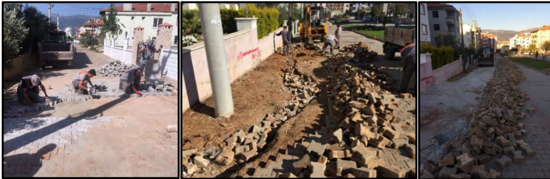
275 Sokak Parke Tamirat Çalışmaları Yapıldı
