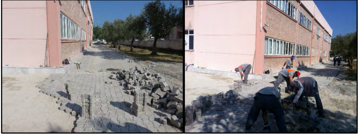
Bayır Lisesi Bahçesine Parke Döşendi
