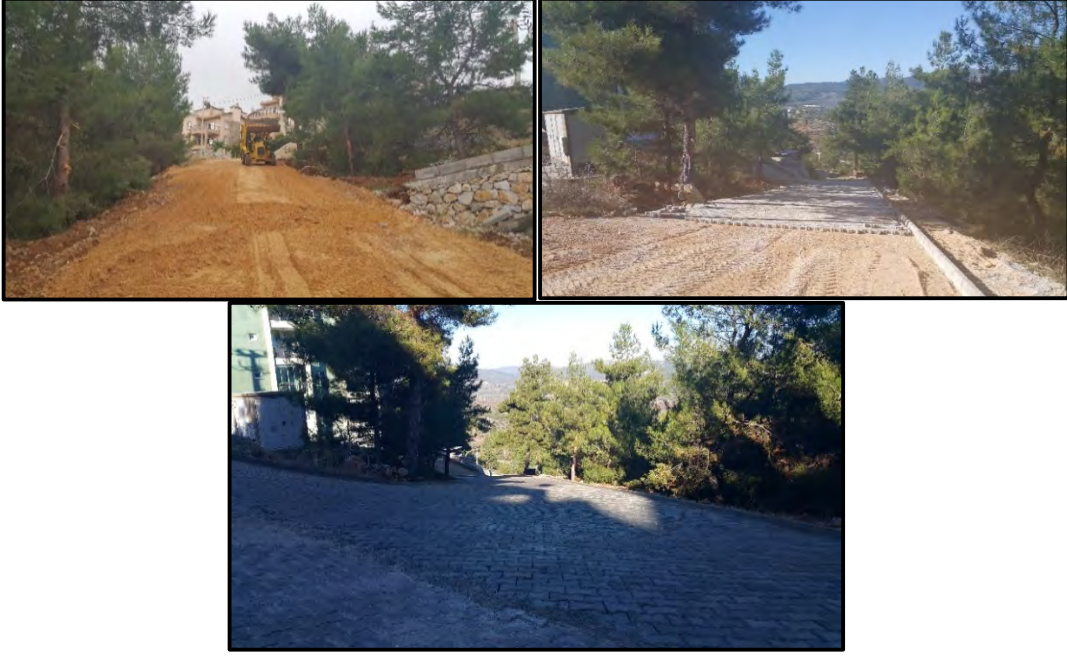
Yeşilevler Sitesi Parke Yol Yapım İşleri
