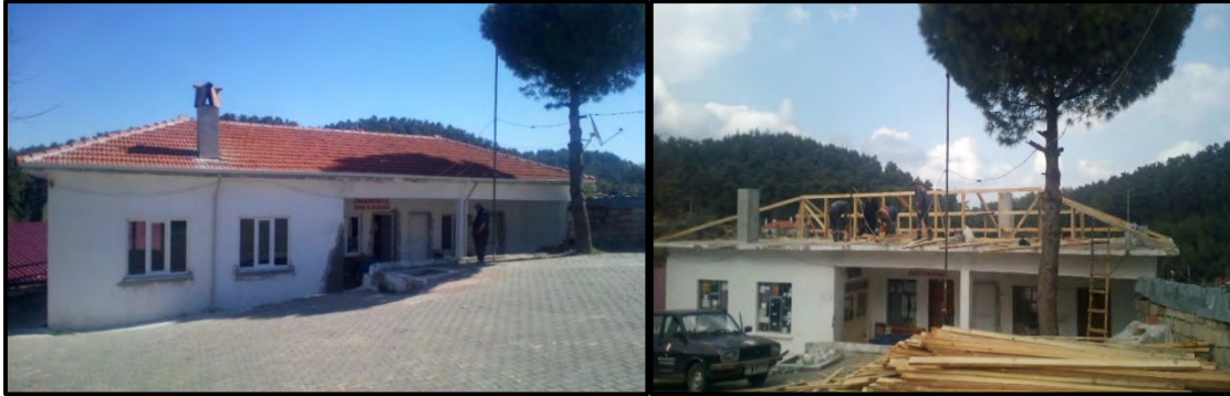
Kahvehane Çatı Yapım İşleri
