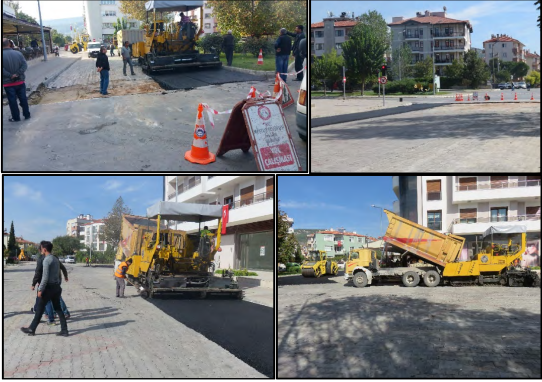
Şehit Özden Aşınmaz Caddesi Sıcak Asfalt Çalışmaları Yapıldı
