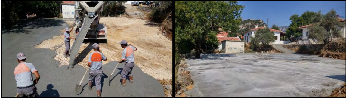
Çok Amaçlı Kullanım Alanına Beton Dökülmüştür
