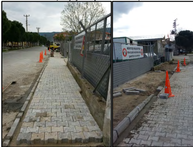
Kademe Önü Kaldırım Çalışması
