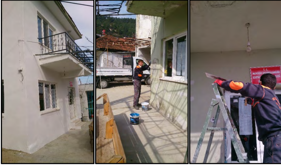
Muhtarlık Binası Bakım Onarım İřeri Yapıldı
