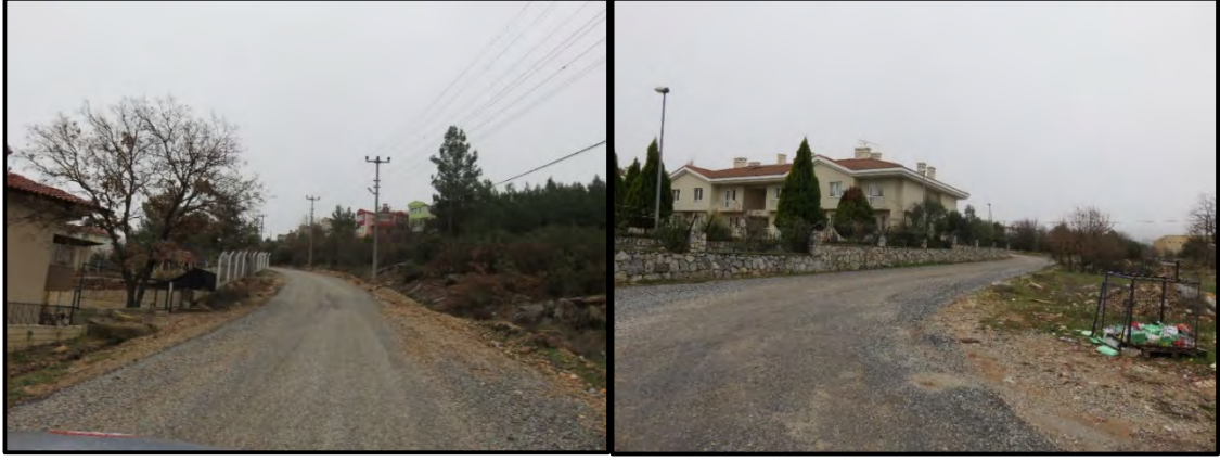
Asfalt Sathi Kaplama Yapılmıştır (6.088 m2)
