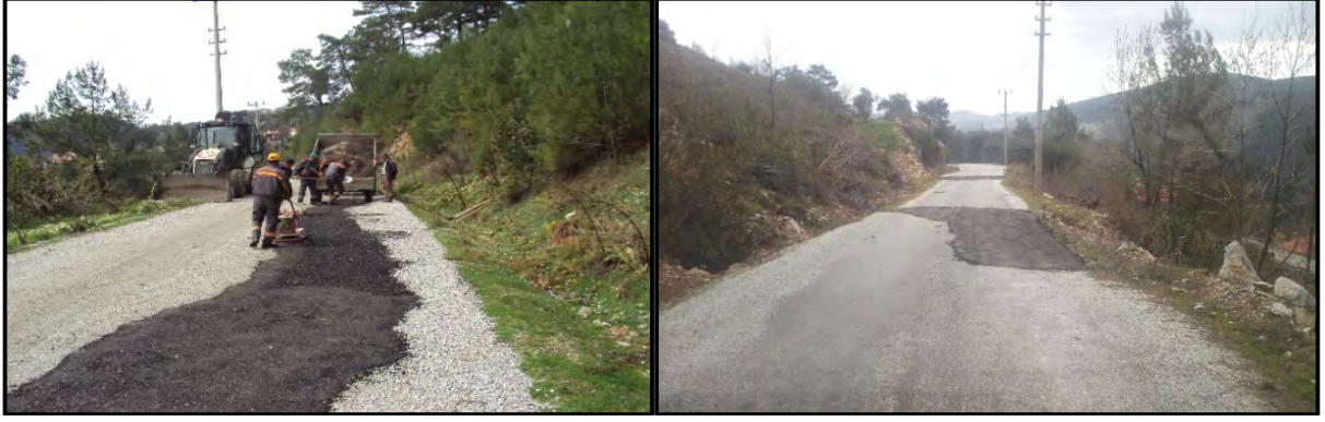
Rodmiks İle Yol Bakım Onarım ve tamirat Çalışmaları Yapıldı
