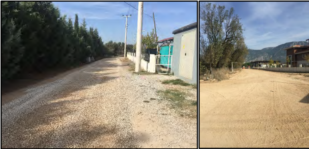
Güzel Sanatlar Lisesi Önü Yol Mıcırlama Çalışmaları Yapıldı
