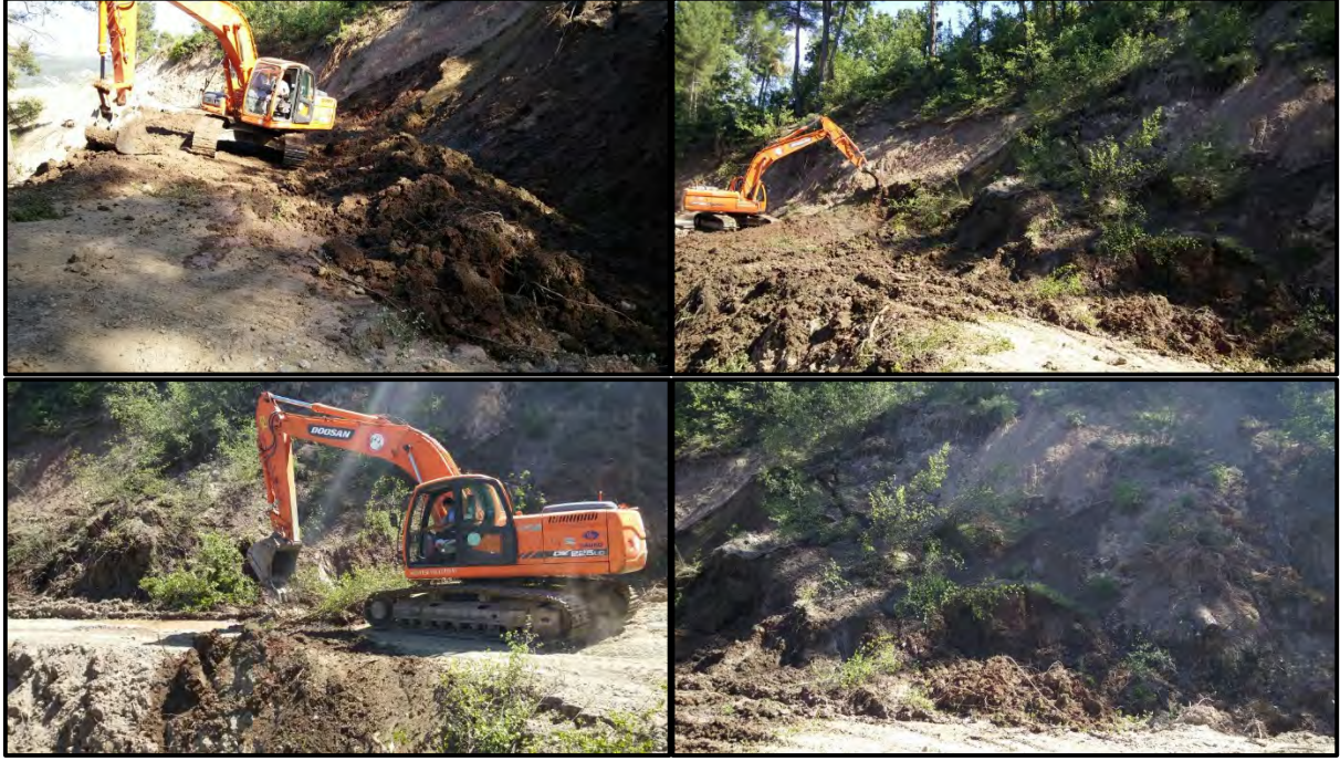
Heyelan Sonucu Ulaşımında Aksaklık Yaşanan Yollarda Çalışmalar Yapılmıştır Greyder İle Yol Bakım Onarım Çalışmaları Yapılmıştır.
