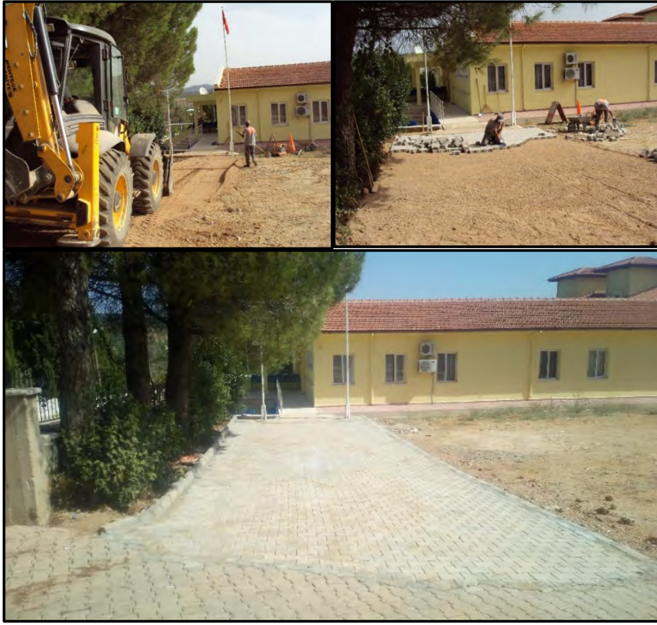
Sağlık Ocağı Parke Taşı Döşeme İşi
