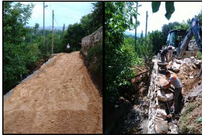
Yapılan İstinat Duvarı İle Araç Ulaşımına Kapalı Yol Ulaşımına Açılmıştır.
