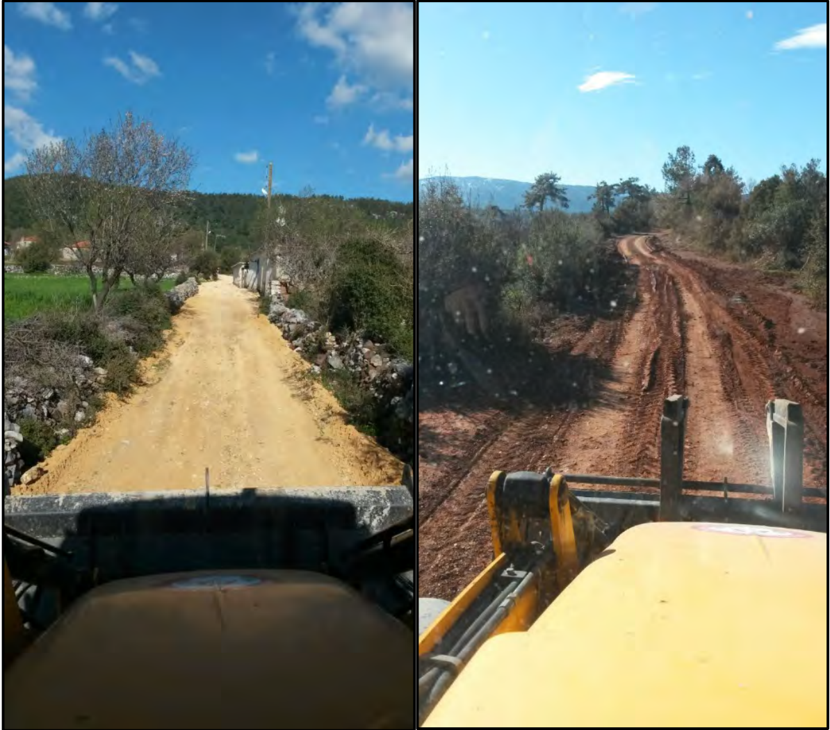
Yol Tesviye İřleri Yapıldı
