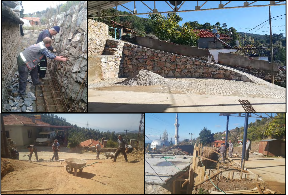
Çok Amaçlı Alana İstinat Duvarı ve Parke Yol Yapıldı
