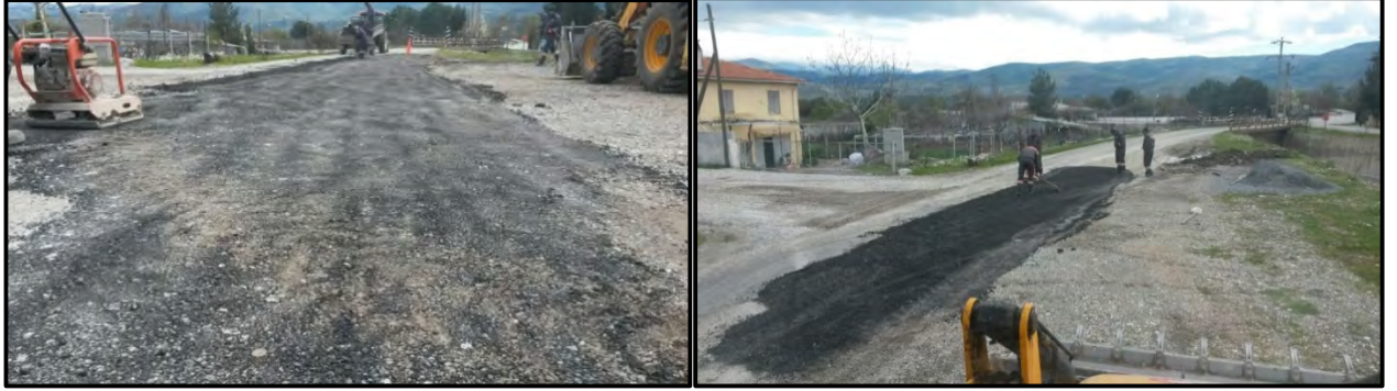
Rodmiks İle Yol Bakım, Onarım ve Tamirat Çalışmaları Yapıldı
