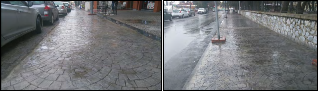
Ethem Selim Sokak ve Özer Türk Caddesinde Baskı Beton Kaldırım Çalışmaları Yapılmıştır
