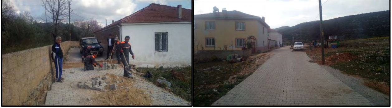
Parke Yol Yapılmıştır
