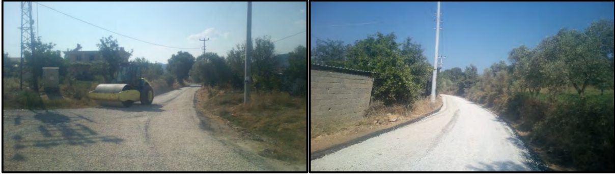
Sarmaşık Sokak Asfalt Sathi Kaplama (2.106 M2)
