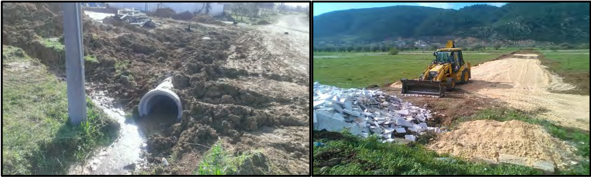
Büz Yerleştirme ve Yol Açma Çalışmaları Yapıldı
