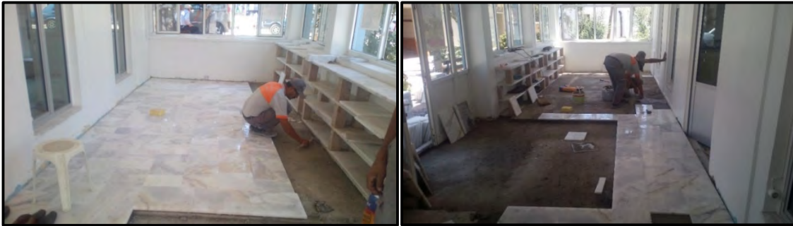
Kabasakal Camii Boya ve Mermer Döşeme İşleri
