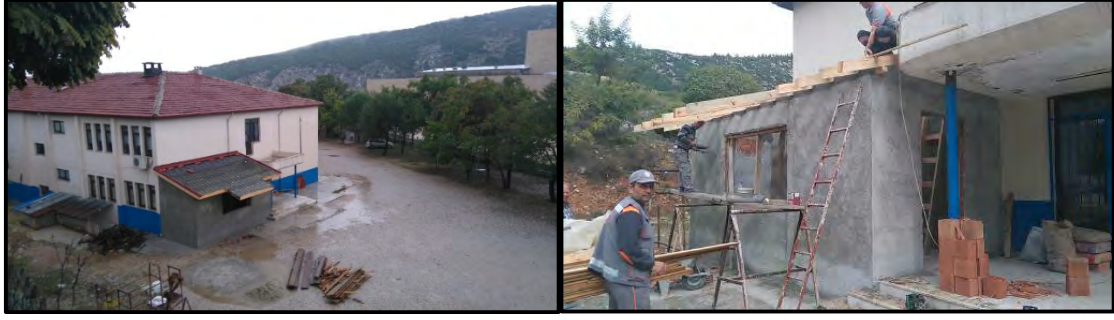
Şehbal Baydur İlkokulunda Kantin Yapım İşi
