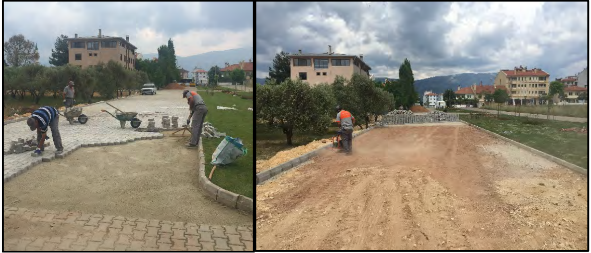
Muhtarlık Önü Parke Kaplama Çalışmaları Yapıldı
