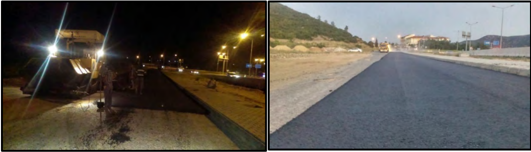
12. Sokak Civarı Asfalt Yol Yapıldı
