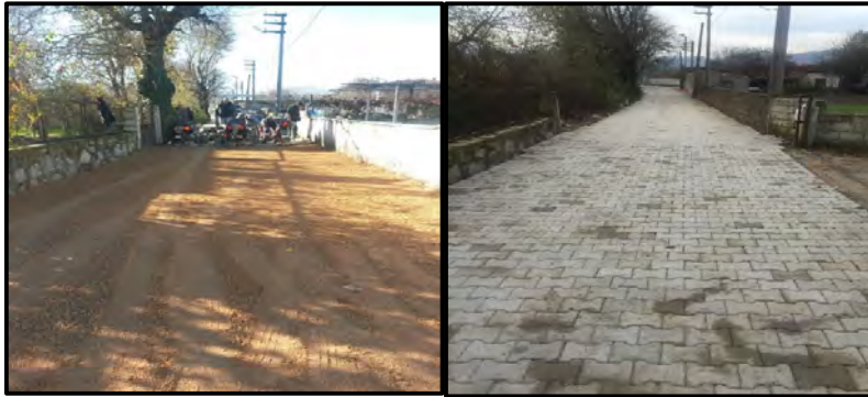
Köyaltı Küme Evleri Parke Yol Kaplama Çalışmaları Yapıldı
