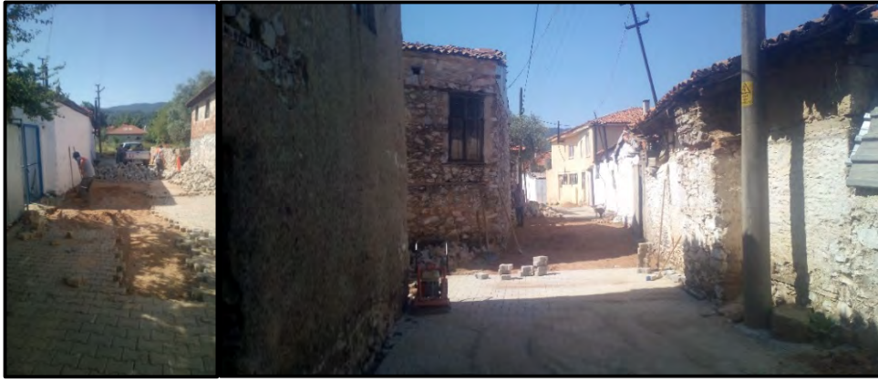
Parke Yol Onarım İşleri Yapıldı
