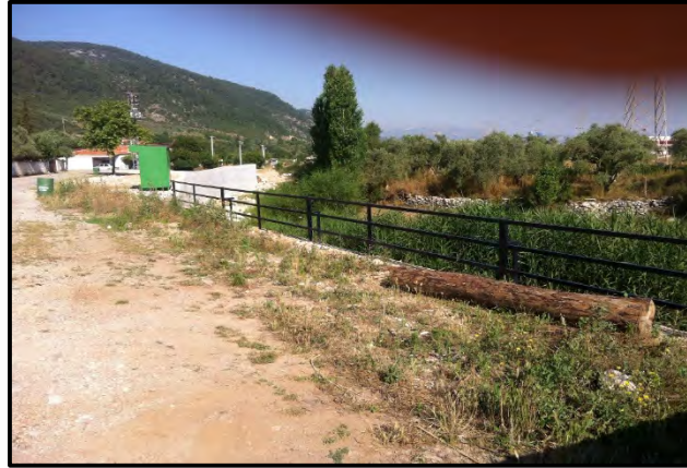
Yol Kenarına Demir Korkuluk Yapımı
