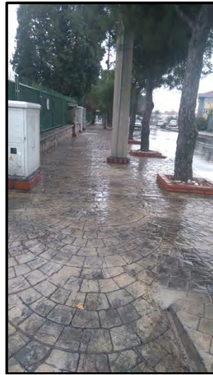
Şehit Asteğmen Yıldray Çeltikoğlu Caddesinde Baskı Beton Kaldırım Yapım Çalışmaları
