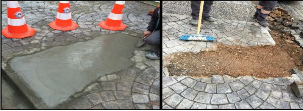
Milli Piyango Önü Baskı Beton Tamirâtı, Sinema Sokağı Parke Tamirat
