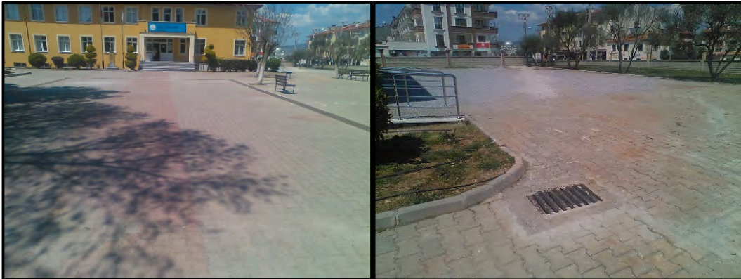
Kötekli Mahallesi Salih Zeki Gür İlkokulunda yağmur suyu kanalları açılıp drenaj hattı döşendi.
