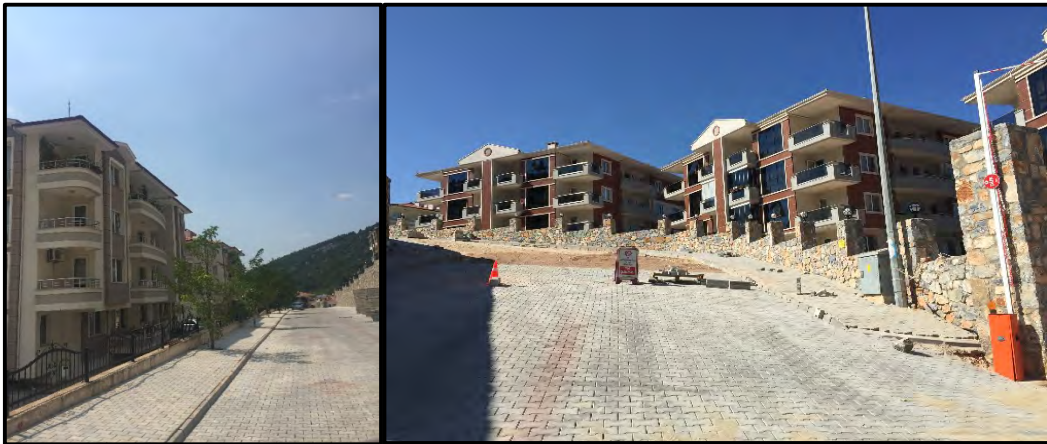
19. Sokakta Parke Kaplama Yapıldı
