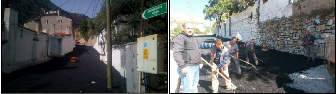
Değirmenler Sokakta Rodmiks İle Yol Kaplaması Yapıldı
