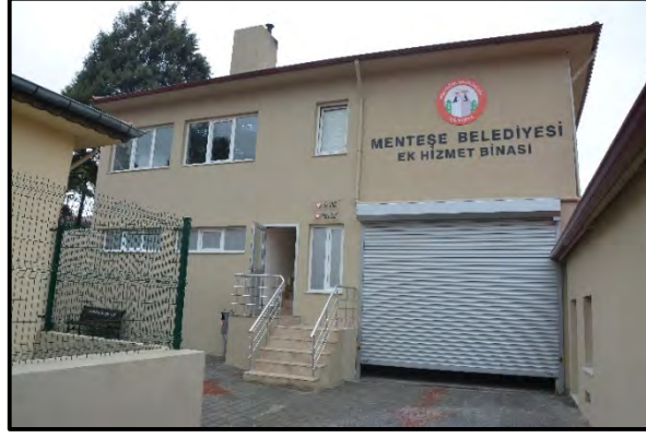
Menteşe Belediyesi Ek Hizmet Binası Tadilatı Yapıldı
