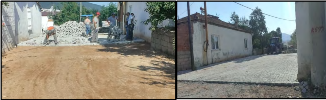
Parke Yol Yapımı
