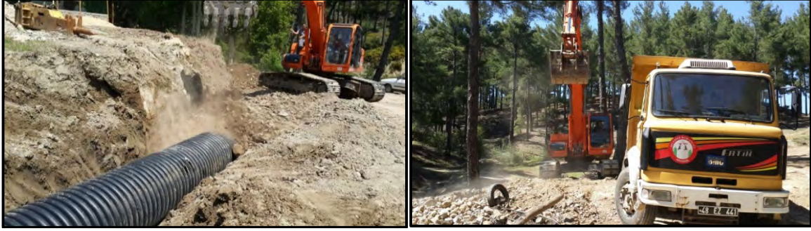
Beton Büz Yerleştirildi
