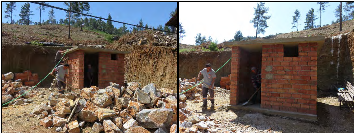
Camii Tuvaleti Yapıldı
