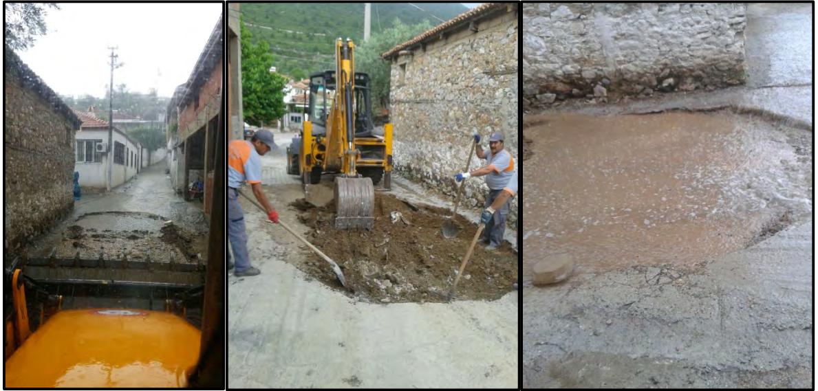
Beton Yolların Tamirâtı Yapıldı
