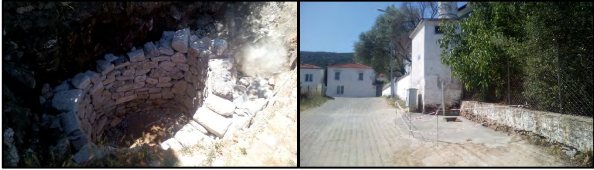
Balık Cami Foseptik Yapım İşleri
