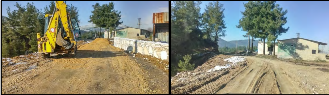
Yol Tesviye İşleri Yapıldı
