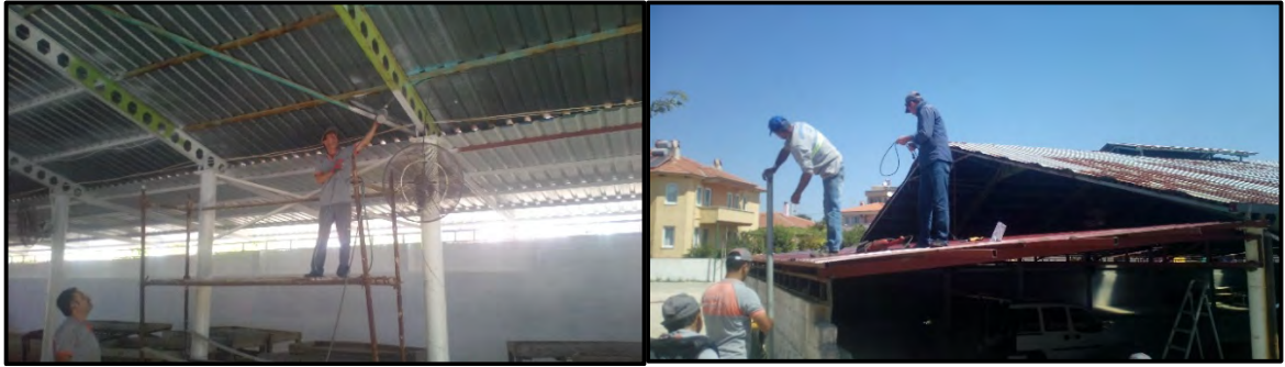
Pazar Yeri Bakım Onarım ve Yenileme Çalışmaları
