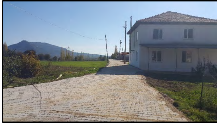
Parke Yol Yapım Çalışmaları
