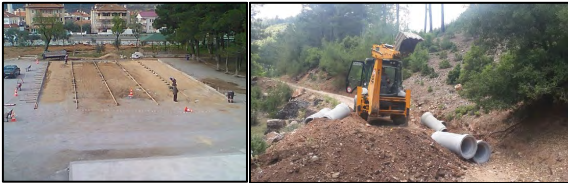
İhtiyaç Olunan Bölgede Büzler Yerleştirildi.
