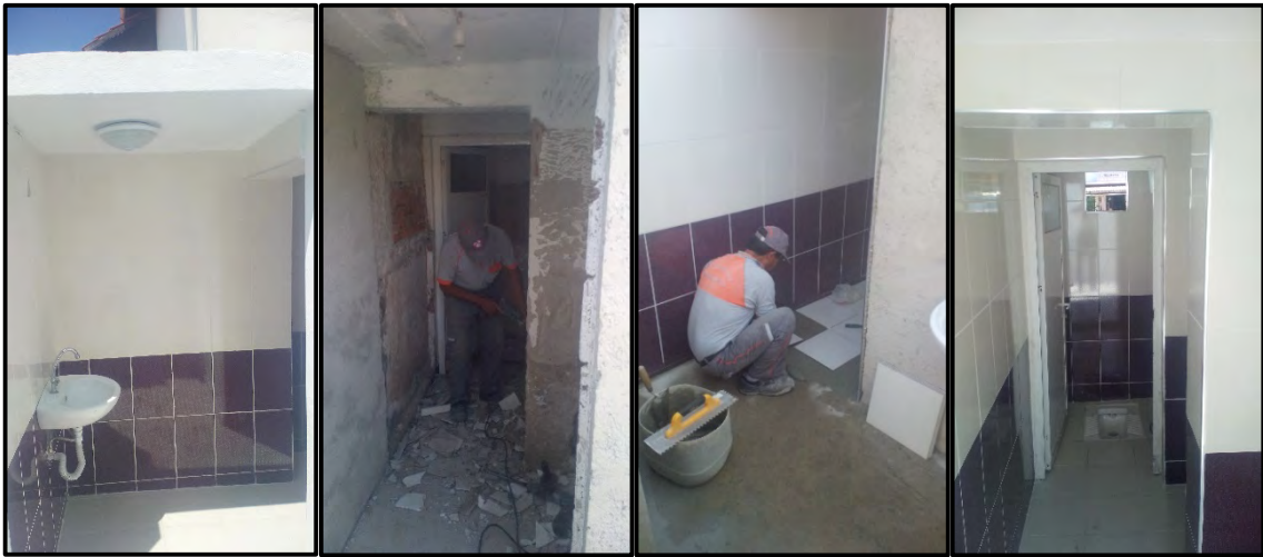
Pazaryeri Tuvaletleri Bakım Onarım İşi
