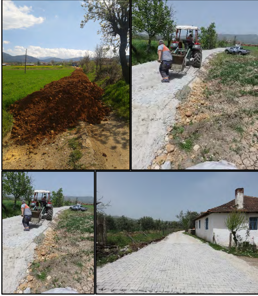
Kışın Ulaşımında Problem Yaşanan Yolda 750 M 2 Parke Taş Döşenerek Sorun Çözümüne Kavuşturulmuştur
