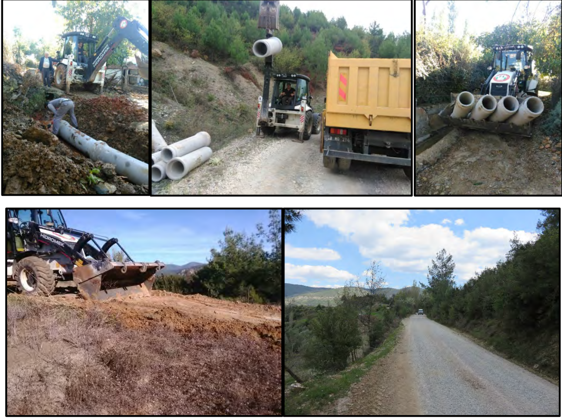
Yapılan Yol Çakıllama, Büz Yerleştirme, Bakım Onarım ve Tesviye İşleri Yapıldı.
