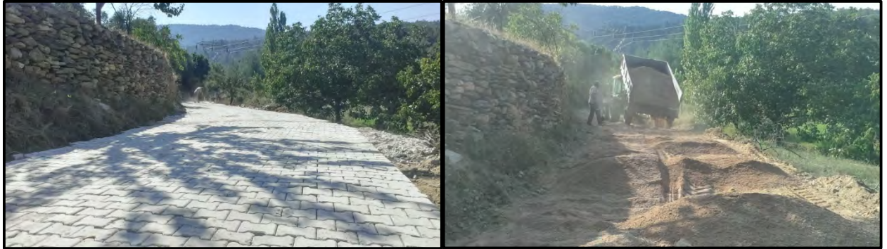
Kilit Parke Yol Yapım İşi
