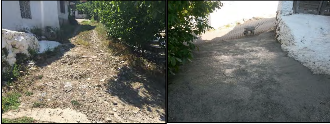
Dere Sokakta Beton Kaplama Yapıldı
