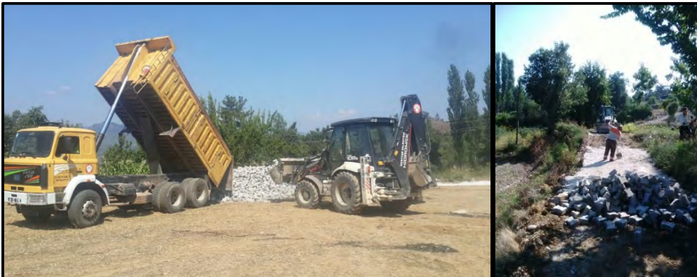
Klit Parke İle Yol Kaplama Yapıldı.
