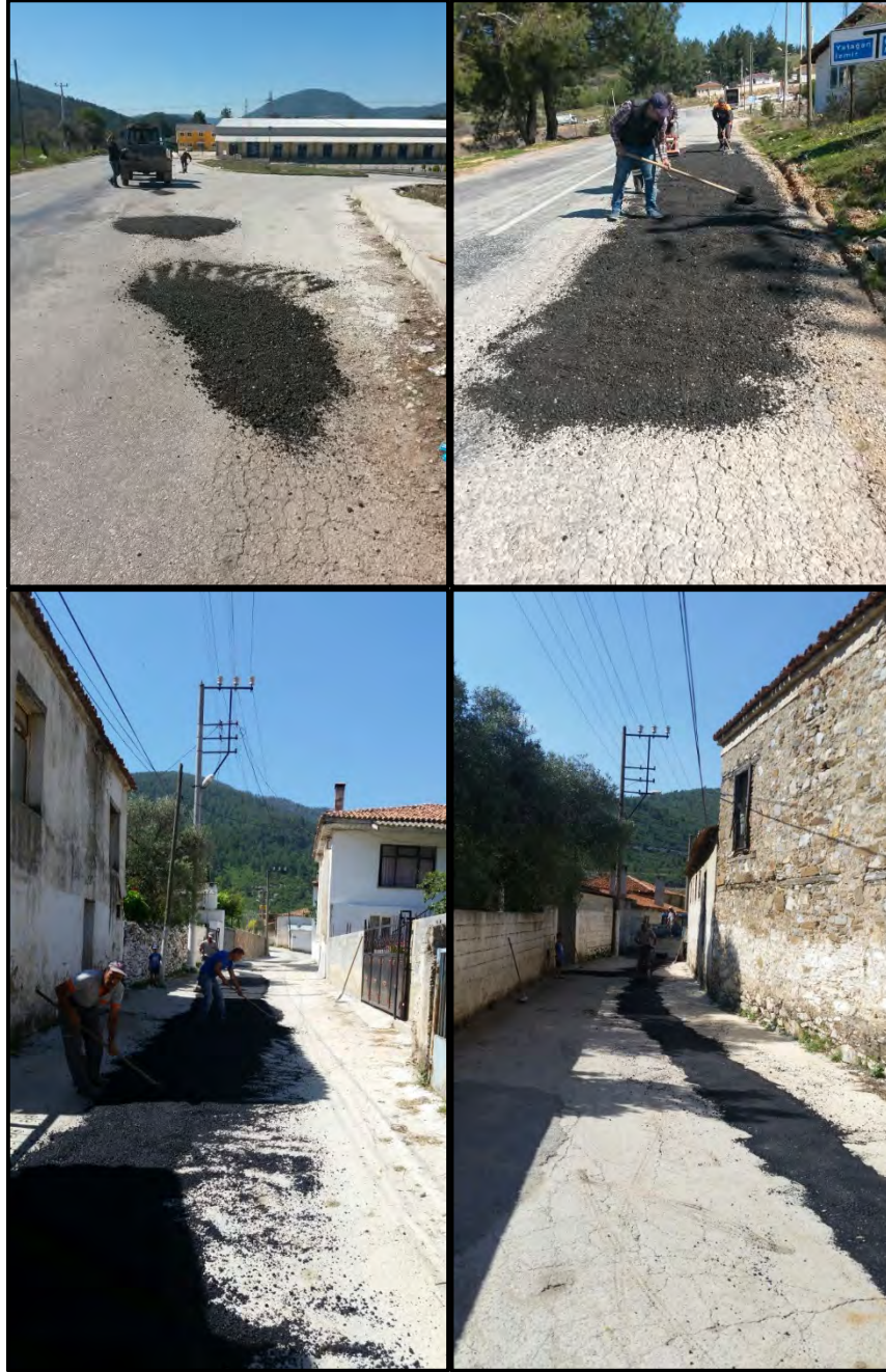
Ana Yol Rodmiks İle Yol Bakım, Onarım ve Tamirat Çalışmaları Yapıldı
