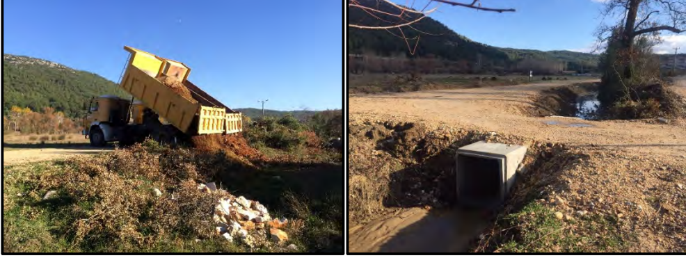
Cedit Köprüsüne Beton Büz Yerleştirilmiştir
