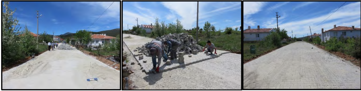
Parke Yol Kaplama Çalışmaları Yapıldı
