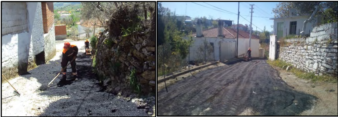
Rotmiks ile Yol Bakım Onarım ve tamirat Çalışmaları Yapıldı
