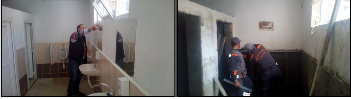
Umumi Tuvaletlerin Yapım, Bakım ve Onarımları
