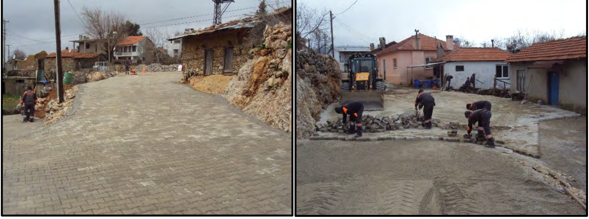
Parke Yol Yapılmıştır
