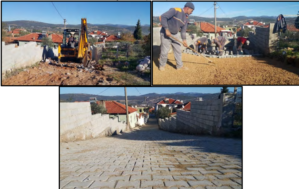
Nergis Sokak Parke Yol Yapım İşleri
