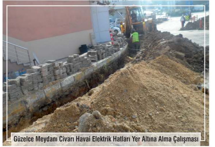
Güzelce Meydanı civarı Elektrik Havai Hatları Yeraltına Alma Çalışması
