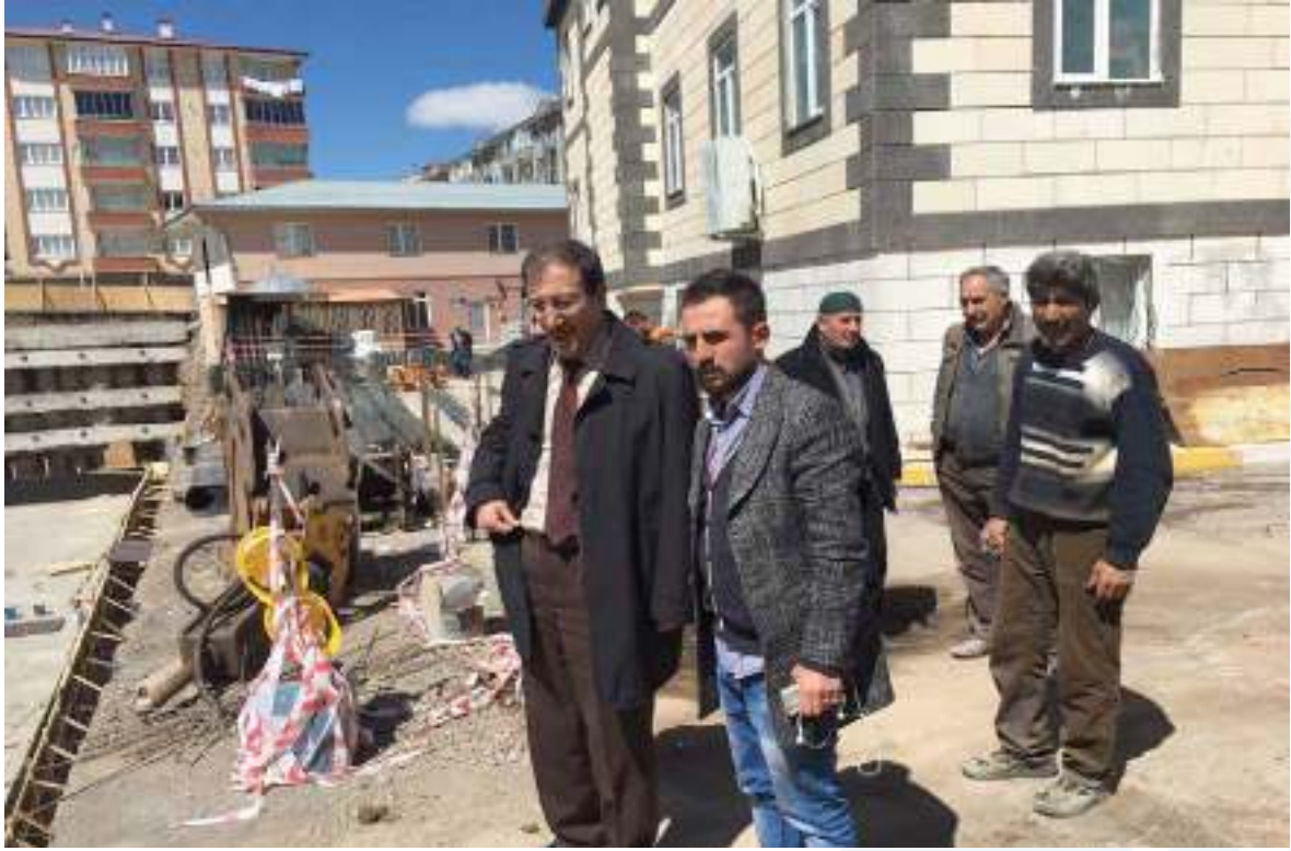
26.04.2017 Palandöken Belediyesi Yeni İkinci Kültür Merkezi İnşaatı Yerinde İnceleme
