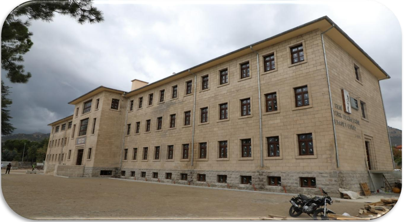
ISUBU Merkez Yüzüncü Yıl Yerleşkesi Taş Bina Restorasyonu Fotoğrafları
