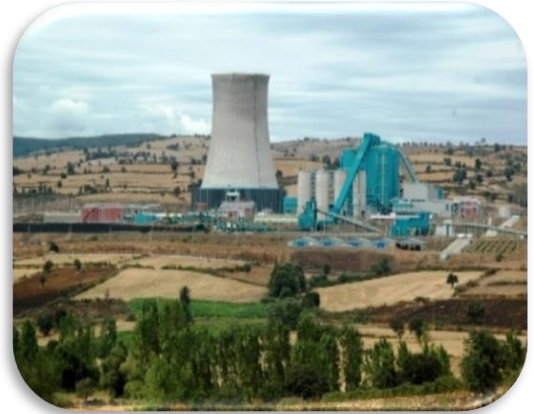
EÜAŞ 18 Mart Termik Santrali
