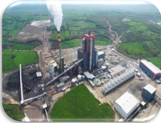
ODAŞ Termik Santrali
