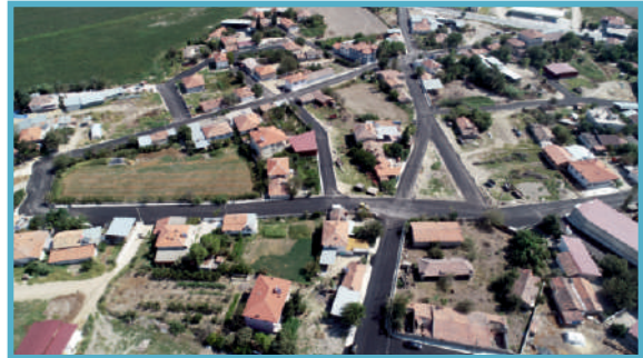
Aşağışamlı Mahallesi Üst Yapı - SONRA
