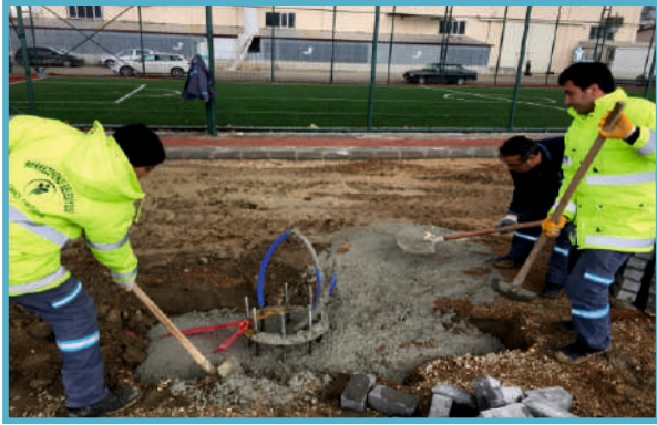
10 metre elektririk direği ankraj betonu atımı
