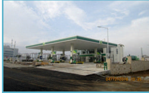
Karahasanlı Mahallesiinde Akaryakıt Satış İstasyonu iskan kontrolü
