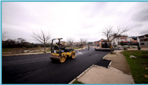
Yenişehir Mahallesi asfalt yol yapım çalışması
