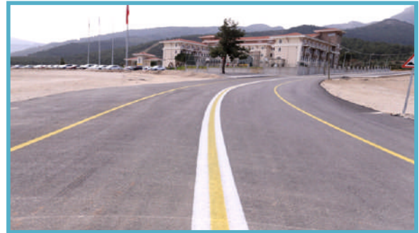
Şirinköy Mahallesi asfalt yol yapım çalışması
