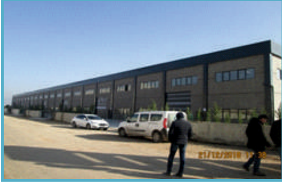
Hacıyüplü Mahallesiinde imalathane iskan kontrolü
