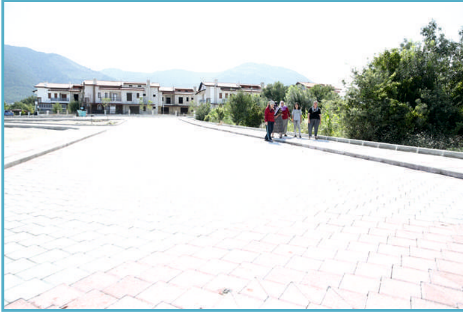
Barutçular Mahallesi kilit taş ve bordür yol çalışmaları
