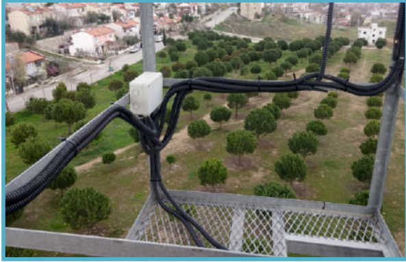
Açık olan kabloları spiral koruma içine alma
