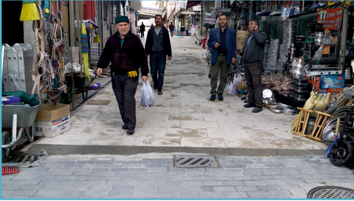
Saraylar Mahallesi Bakırcılar Sokakta hasarlı traverten zemin kaplaması yenilendi.
