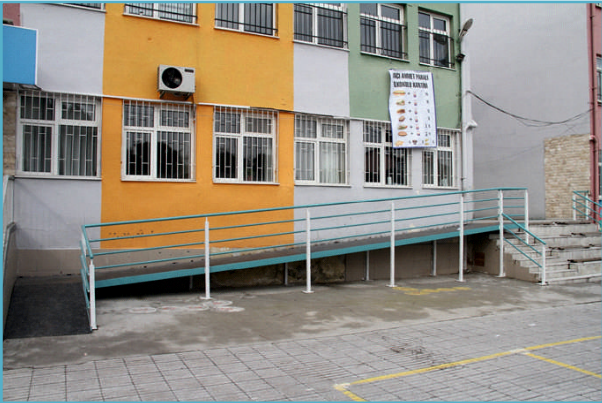
Hacı Ahmet Paralı İlkokuluna engelli rampası yapıldı
