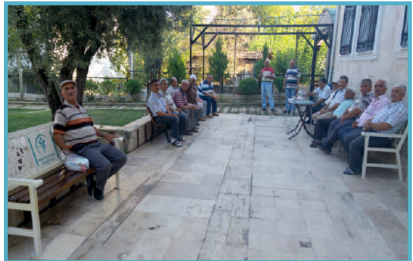
Muratdede Mh. Üzümlü dedesi cami bahçesi bank montajı
