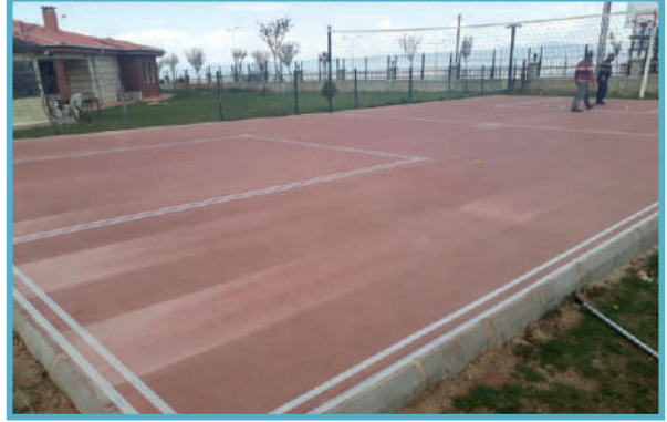
Göveçlik Mh. Engelsiz yaşam merkezi basket saha yapımı
