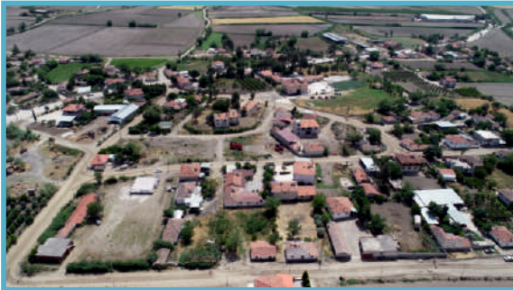
Aşağışamlı Mahallesi Üst Yapı- ÖNCE
