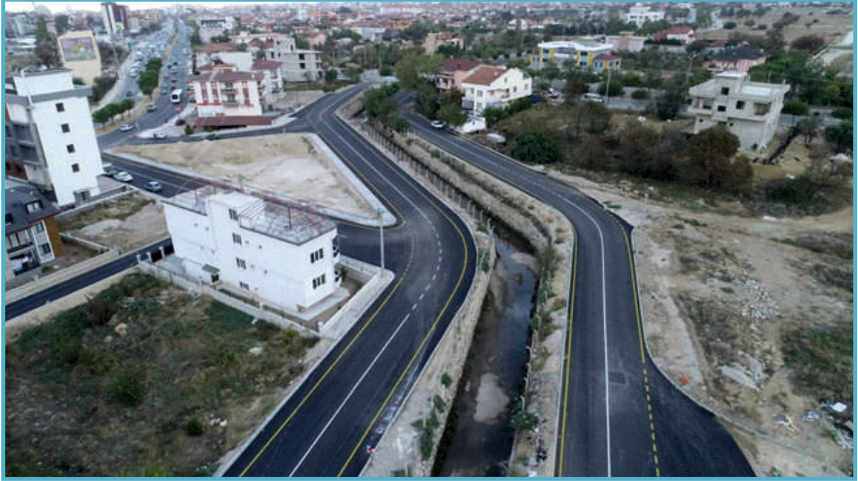
Bahçelievler Mahallesi asfalt yol yapım çalışması
