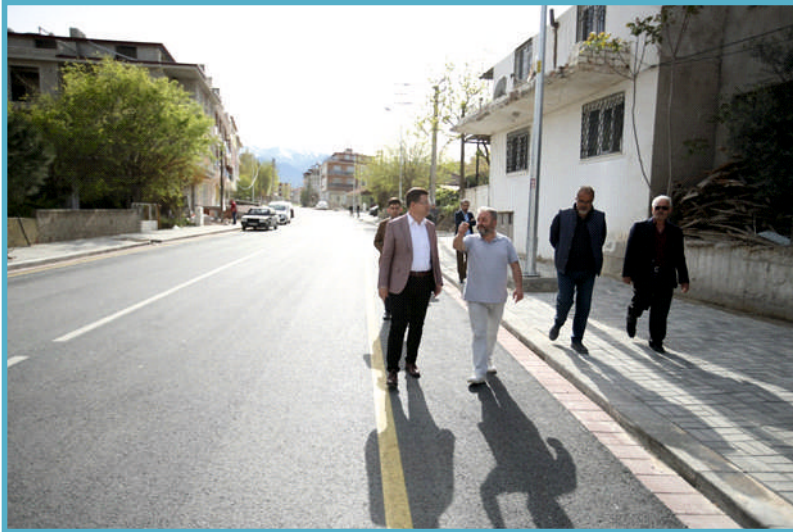
İlbade Mahallesi kilit taşı, bordür ve asfalt yol çalışması
