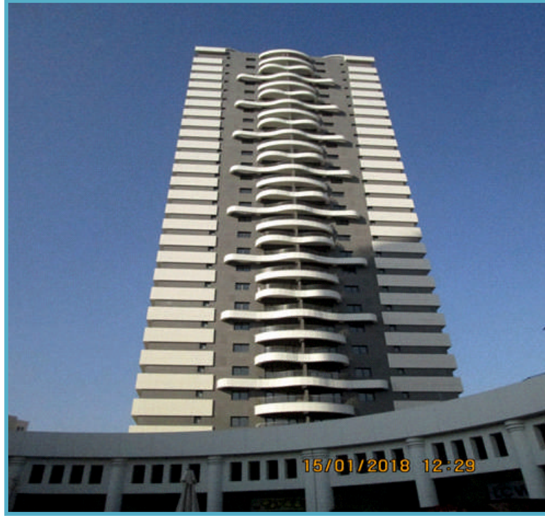
Gümüşçay Mahallesinde konut iskan kontrolü
