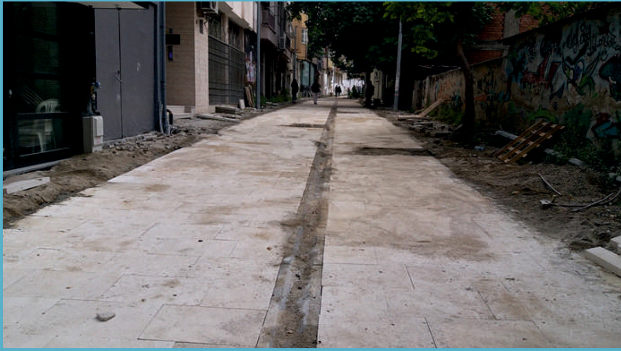
Altıntop Mahallesi Meserret Sokakta hasarlı traverten zemin kaplaması yenilendi.
