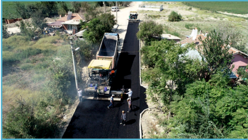
Aşağışamlı Mahallesi asfalt yol yapım çalışması
