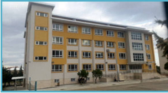
Bereketli Ortaokulu iskan kontrolü
