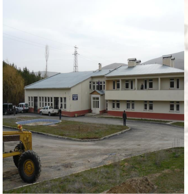
Altyapı Hizmetleri Hizmet Binası
