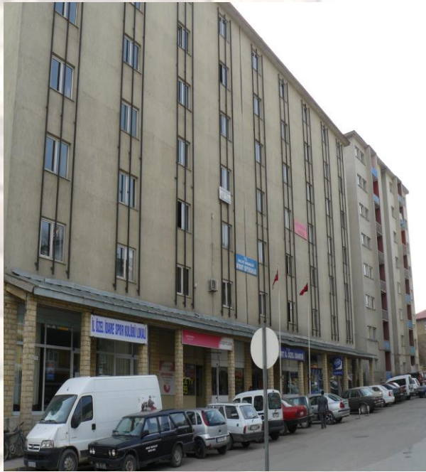
İl Özel İdaresi Hizmet Binası
