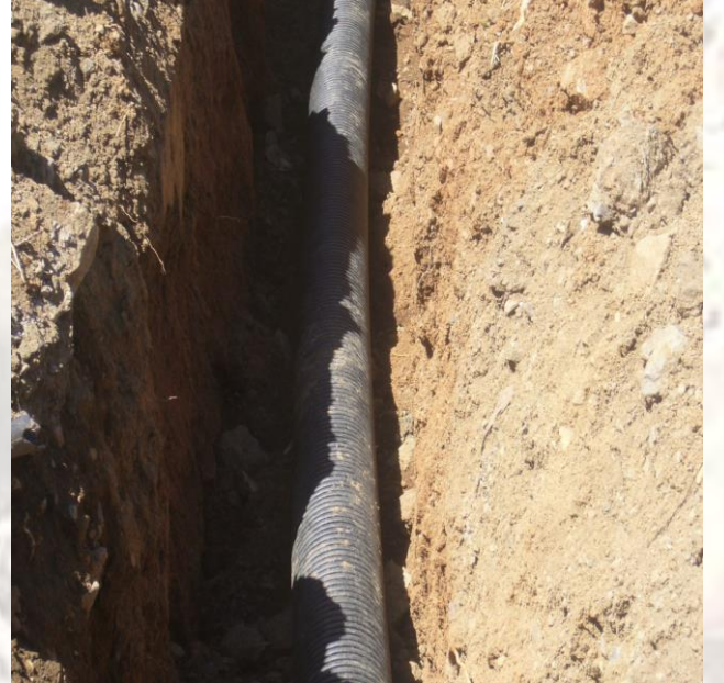
Y.Dikmetaş Köyü Kanalizasyon (Yeni Hali)
