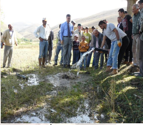
Ozansu Köyü İçme Suyu Projesi
