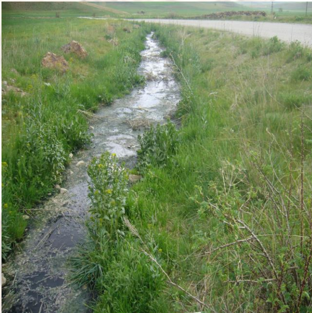
Y.Dikmetaş Köyü Kanalizasyon (Eski Hali)
