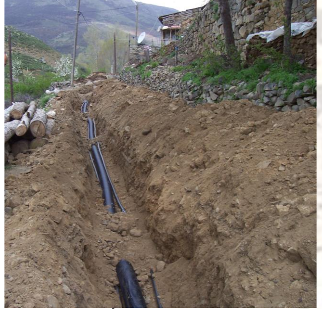
Suludere Köyü İçmesuyu ve Kanalizasyon
