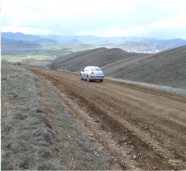
Y.Pınarlı Köyü Stabilize Yol Çalışması
