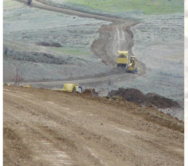
Y.Pınarlı Köyü Stabilize Yol Çalışması
