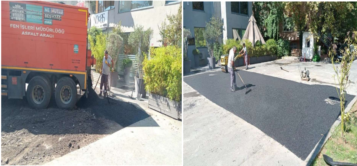
Akat Mahallesi, Yeşim Sokak Asfalt Serim Çalışması
