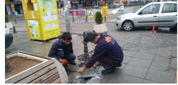
Tehlike Arz Eden Yerlere Panel Çit Yapımı
