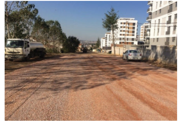
Yeni İmar Yolu Açılması ve Zemin İyileştirme Çalışmaları
