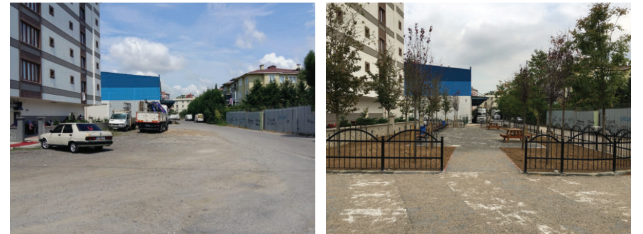
Hatmi Sokak Parkı Yapım Öncesi Genel Bir Görünüş
