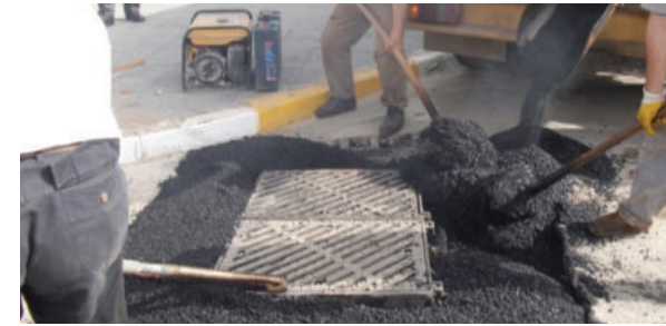
Yağmursuyu ızgara Yapımı ve Montajı
