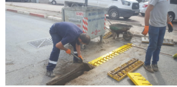
Yağmur suyu ızgara Yapımı ve Montajı
