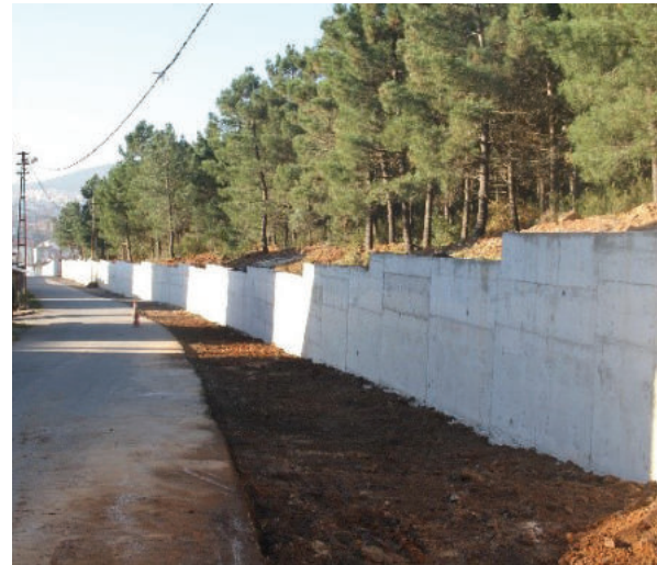
İstinat Duvarı Çalışması
