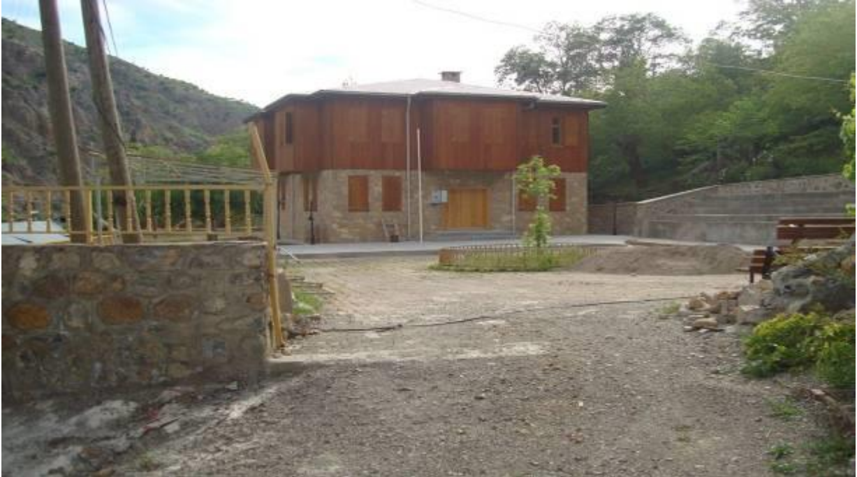
1- Kemaliye İlçesi Başbağlar Köyü kültür evi yapımı (299.357,49 TL.)
