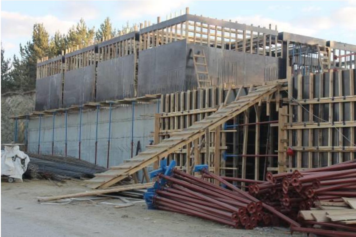
Refahiye Huzur Evi İnşaatı
