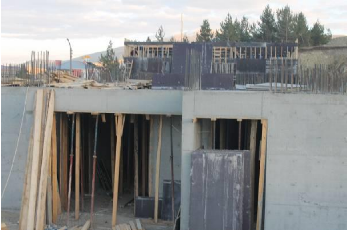
Refahiye Huzur Evi İnşaatı
