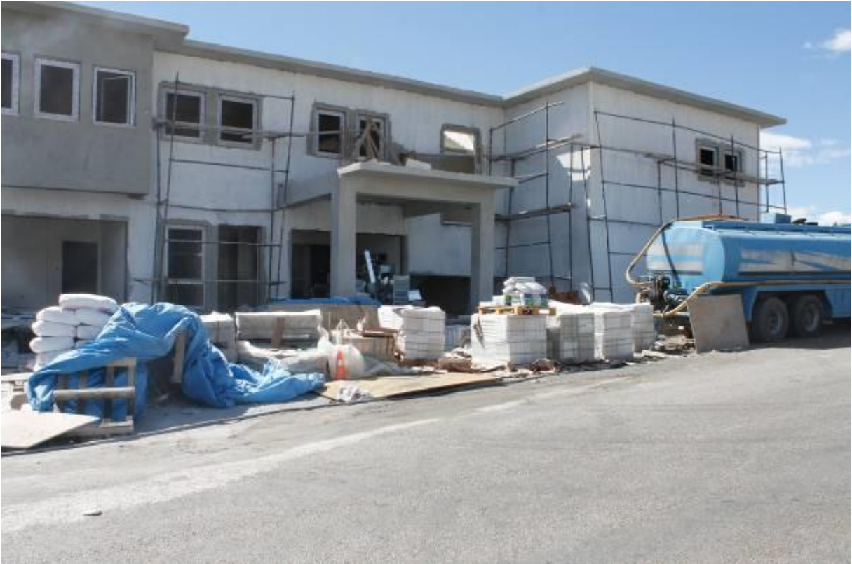
Engelsiz Yaşam Merkezi İnşaatı
