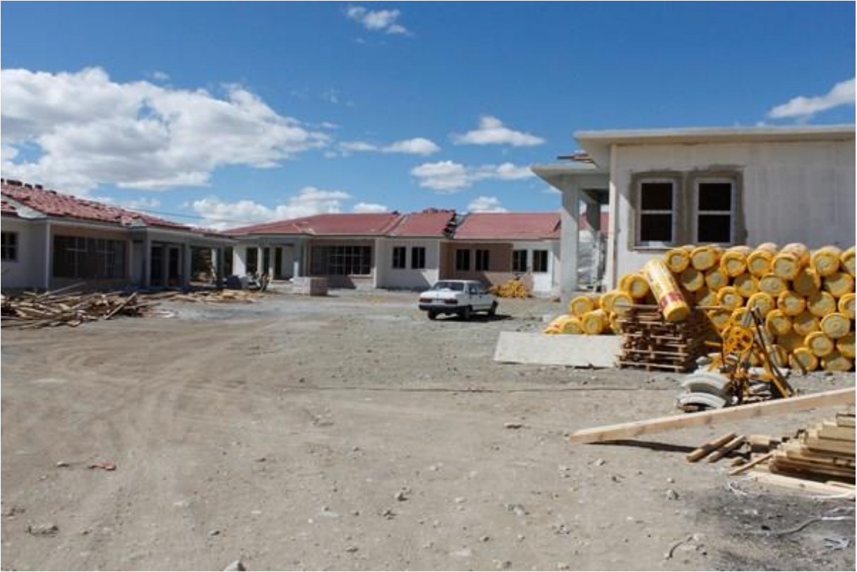
Engelsiz Yaşam Merkezi İnşaatı
