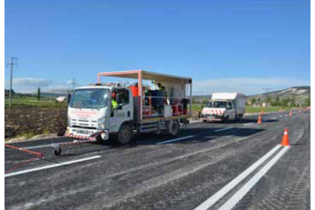
Bigadiç İlçemiz Yol Çizgi Çalışması..
