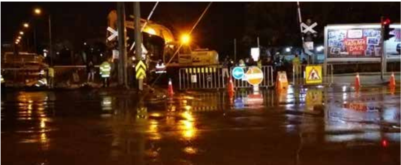
Yol kapama/işaretleme çalışmaları
