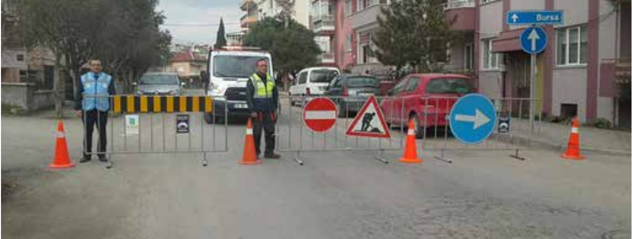
Yol kapama/işaretleme çalışmaları
