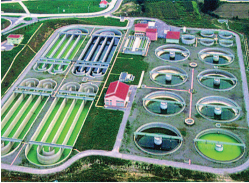
Karaman Atıksu Arıtma Tesisi
