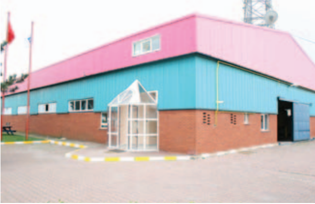
Maltepe İçmesuyu Arıtma Tesisi
