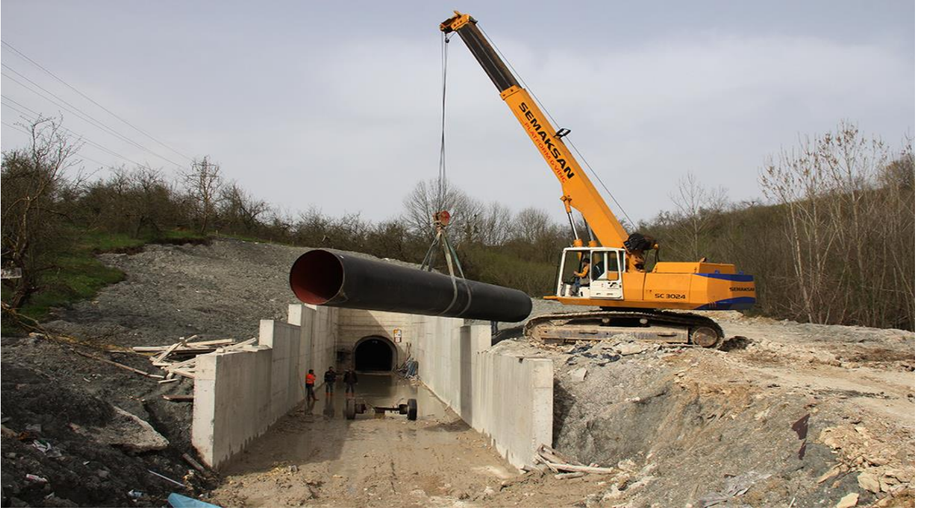
Çelik İsale Hattı Tünel İnşaatı
