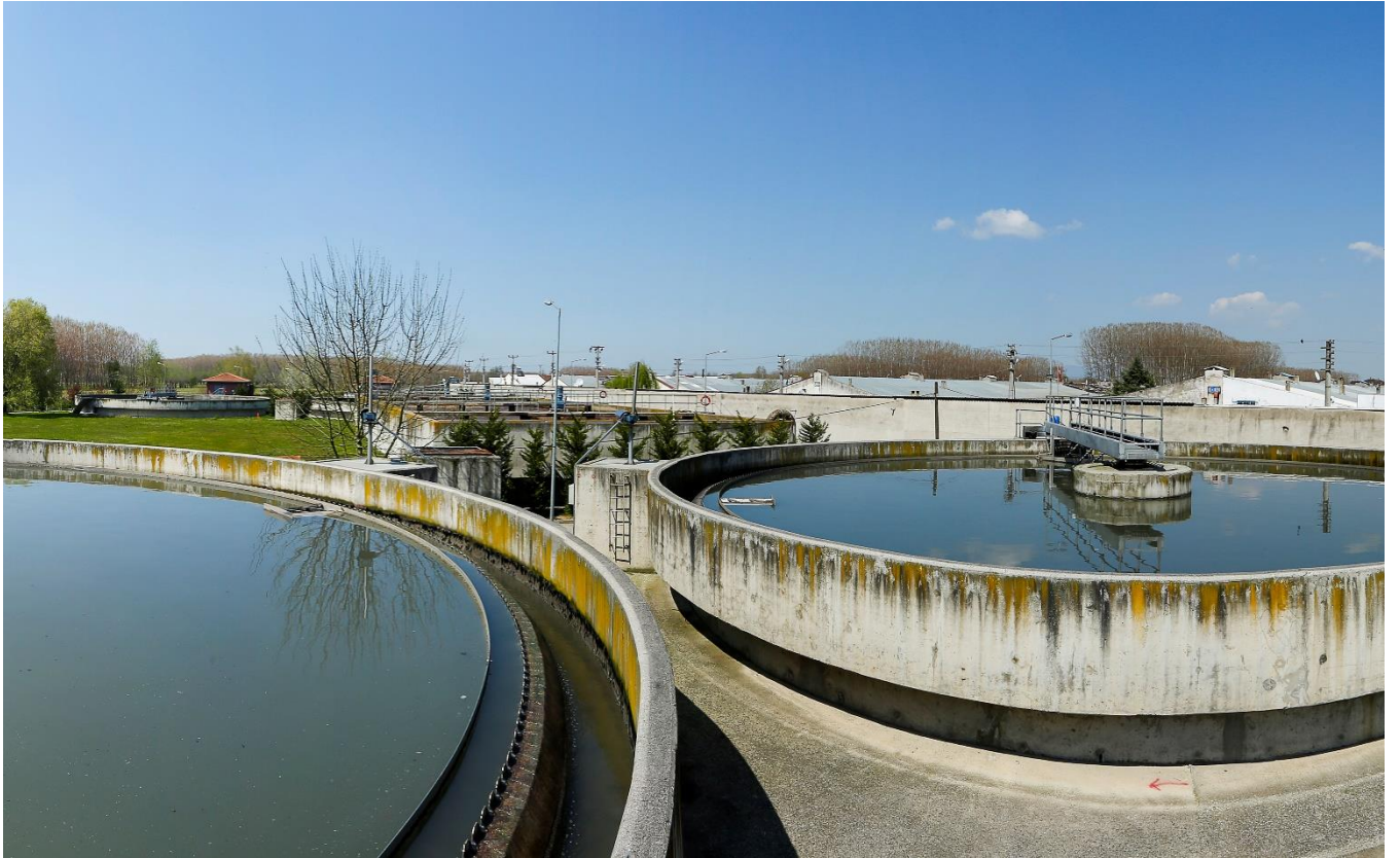
Hendek Atıksu Arıtma Tesisi
