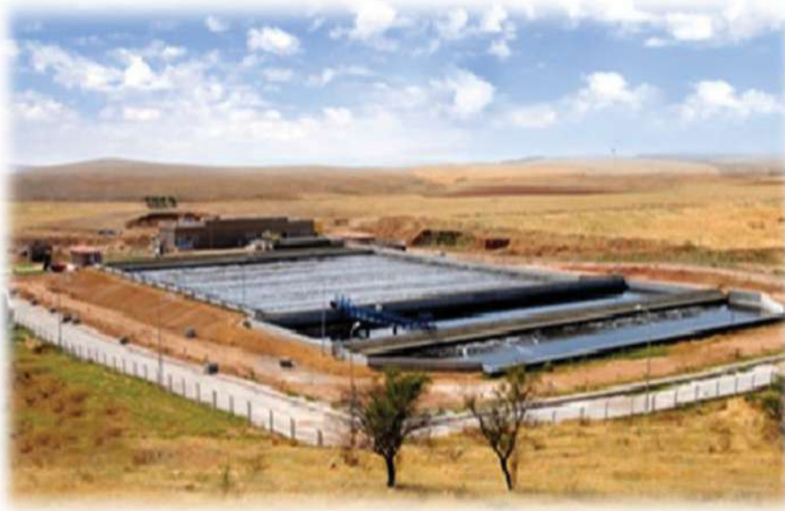
Atık Su Arıtma Tesisi
