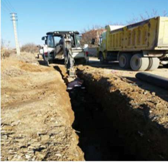
İçme Suyu Hat Çalışması
