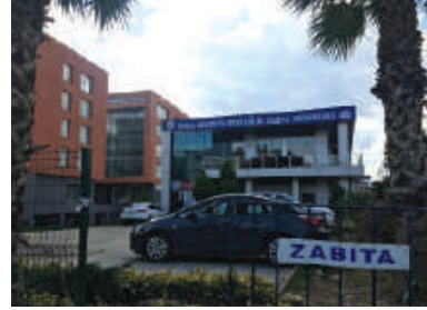
Zabıta Yeni Hizmet Binası
