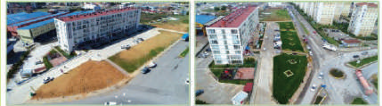
9. PATLAYICILAR CAD.DUMANKAYA ADRES ÖNÜ YEŞİL ALAN DÜZENLEMESİ
