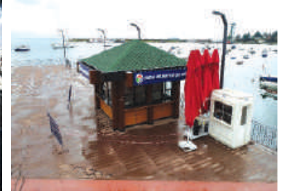
Tuzla Sahil Çay evi Yapımı
