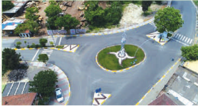
İSTASYON KAVŞAĞI SAAT KULESİ YAPIMI
