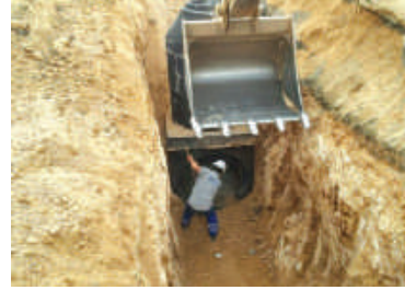
Orhanlı Mahallesi Sabancı Caddesi Ø1000 mm Yağmursuyu Hattı Çalışması
