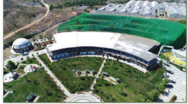
6740 M2 ÇİM ÇİT UYGULAMASI YAPILMIŞTIR.
