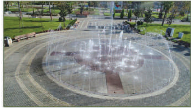
ŞELELE PARK KURU HAVUZ YAPIMI
