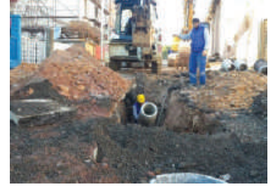
İçmeler Mahallesi Katre Sokak Ø300 mm Yağmursuyu Hattı Çalışması
