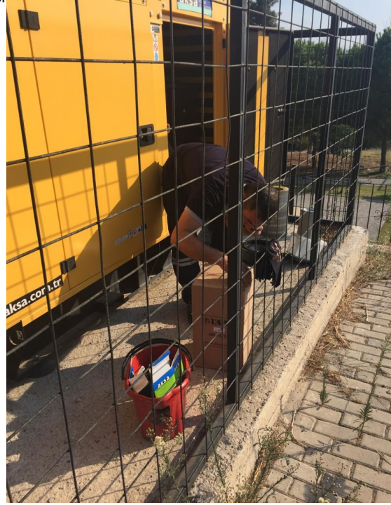
Jenaratör Pompa Bakımı
