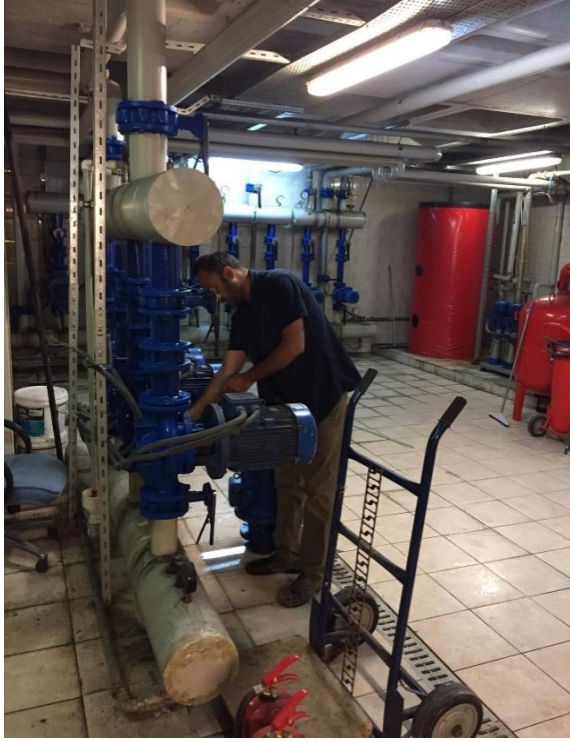
Sirkülasyon Pompası Tamir İşi
